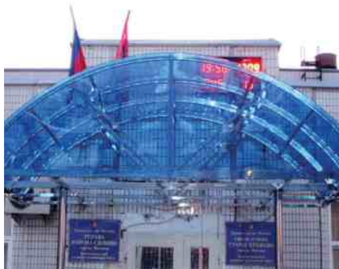
Козырек на нержавеющей металлокаркасе, облицованный голубым монолитным поликарбонатом.
