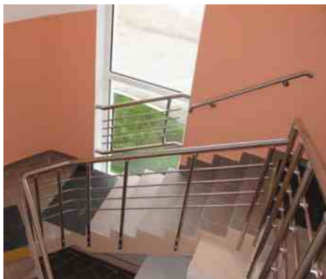
Ограждение с боковым крепежом, ригеледержателем k018 и четыремя ригелями диаметром 16 мм.
