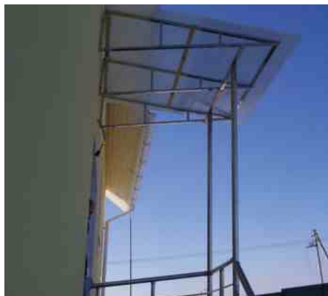
Простейший козырек над входной группой. Каркас из нержавеющей стали и сотовый поликарбонат.
