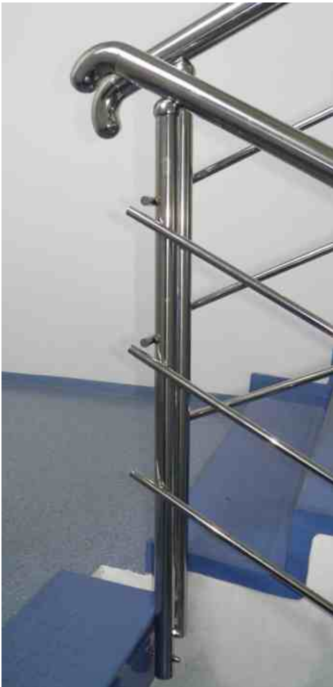
Эконом вариант: точечная сварка оконечных отводов. Поручень и ригели не завязаны на повороте. Наконечник стойки сфера K016. Боковой крепеж на шпильку сквозь стойку.
