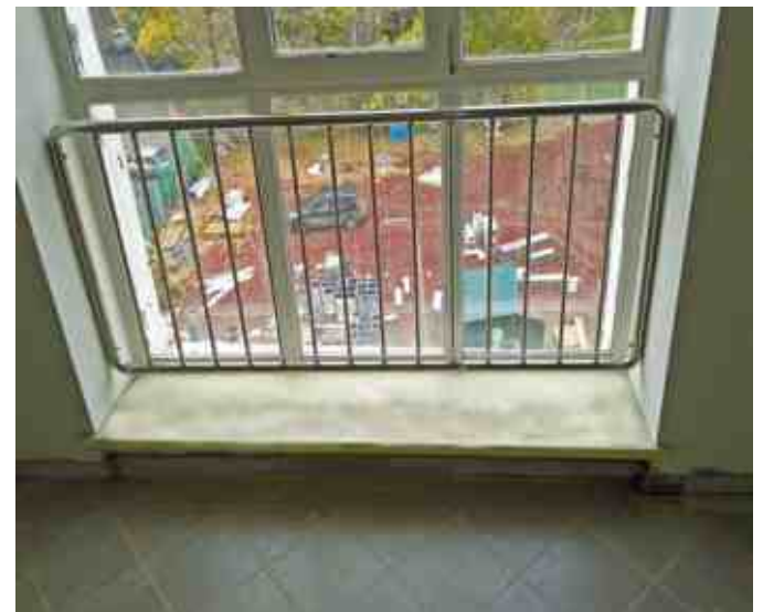
Съемное ограждение окна на жесткой раме с вертикальным заполнением на деталях k211.
