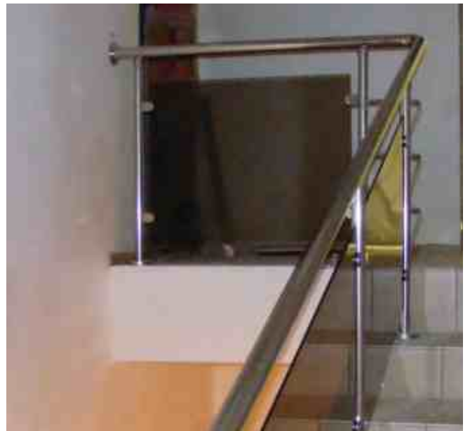
Ограждение со стеклом 8 мм бронзовым в массе. Наконечник стойки к016, крепление стойки через 3х анкерную закладную.
