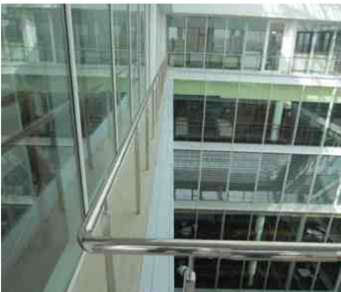
Техническое ограждение атриума вдоль стеклянных перегородок. Квадратные стойки 40x40 мм в стиле квадратных стоек алюминиевых перегородок, круглый поручень 50 мм, завязан на поворотах.
