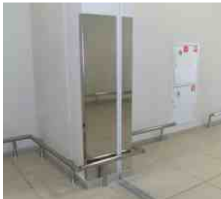
Отбойник вдоль стен крепление сверху в пол.
