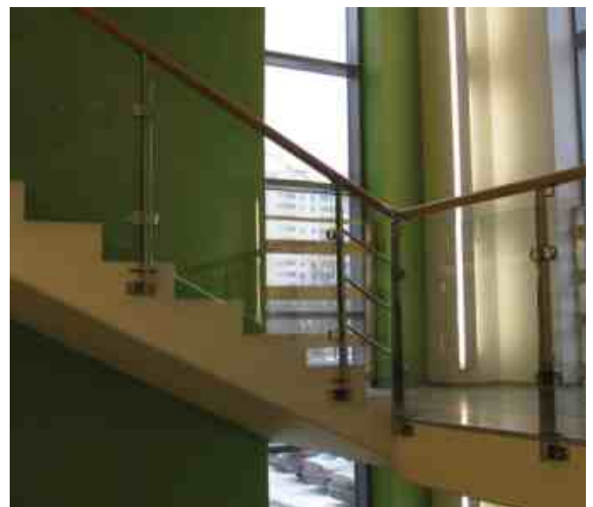
Стеклоанное ограждение со стойками из полированной нержавеющейки 10 мм, с минималистичным боковым крепежом и деревянным поручнем, завязанным нержавеющейкой на поворотах.
