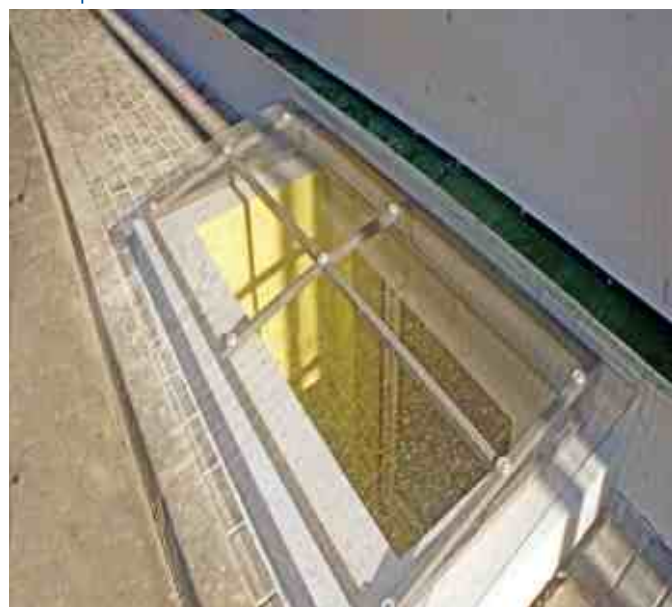
Навес прямка из белого монолитного поликарбоната.
