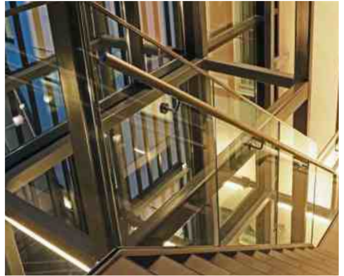
Ограждение без стоек высотой 1200 мм, с защитой кромок П-образным профилем, с боковым крепежом и поручнем на выносе на комфортной высоте 950 мм.
