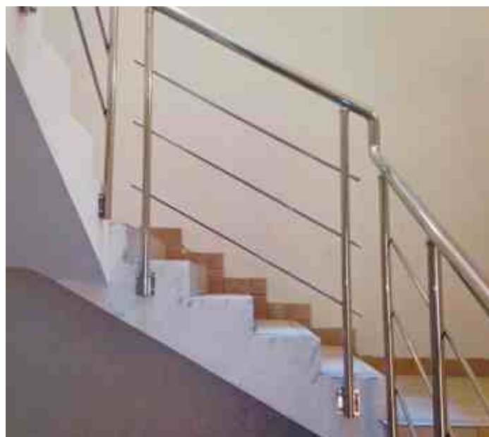
Иллюстрация стандартной проблемы при боковом крепеже: образование выхода на вертикаль из-за геометрии колодезных лестниц. Единственная возможность сохранить одинаковую высоту на соседних маршах - скомпенсировать перепад в 1 высоту ступени выходом поручня на вертикаль.
