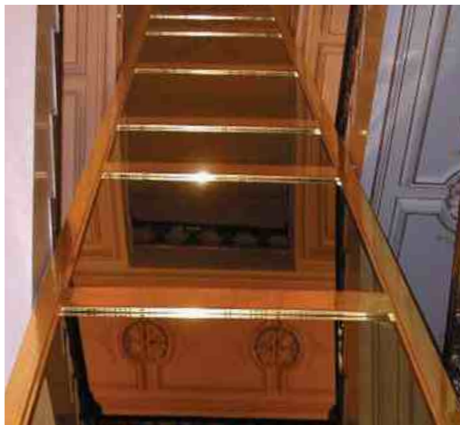
Облицовка лифтовой шахты листом с покрытием нитрид титана и стеклом с зеркальной тонированной пленкой.
