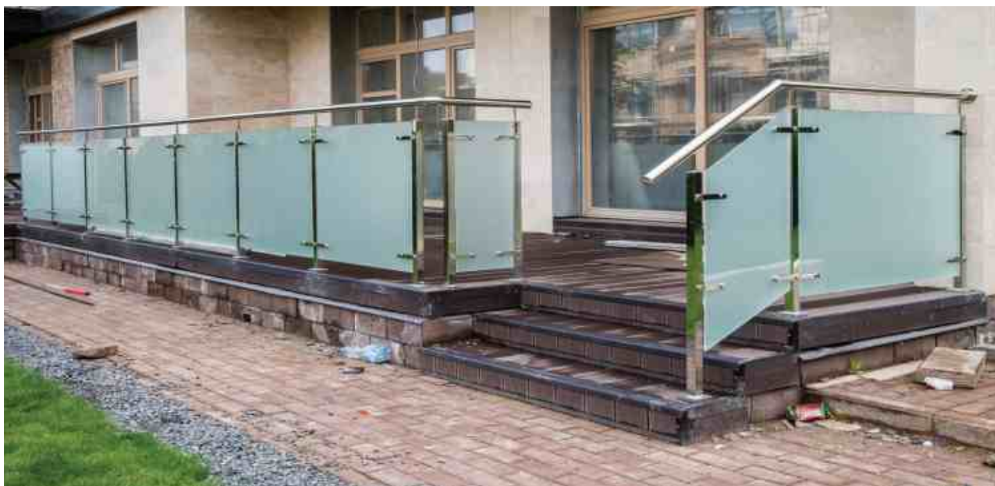
Входная группа совмещенная с балконом первого этажа. Ограждения со стойками 40x40 мм, круглым поручнем д. 50,8 мм, пластинчатыми стеклодержателями и матовым в массе стеклом, благодаря которому с внутренней стороны балкона крепление стекла практически не видно.
