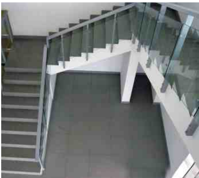
Ограждение со стойками из черного металла с покраской в RAL и пластинчатыми стеклодержателями в автосалоне.
