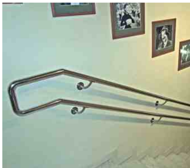
Пристенный поручень в кинотеатре «Эльдар» для взрослых и для детей на высоте 900 мм и 600 мм соответственно.
