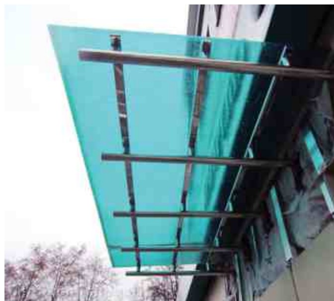
Козырек 2,5 м на 10 метров на нержавеющей металлокаркасе, закрепленный со съемом фасада. Каркас накрыт голубым сотовым поликарбонатом
