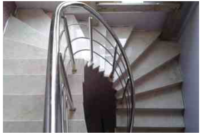
Ограждение забежной лестницы с крышками под золото, 3 ригеля. Наконечник k034, стойки д. 38 мм.
