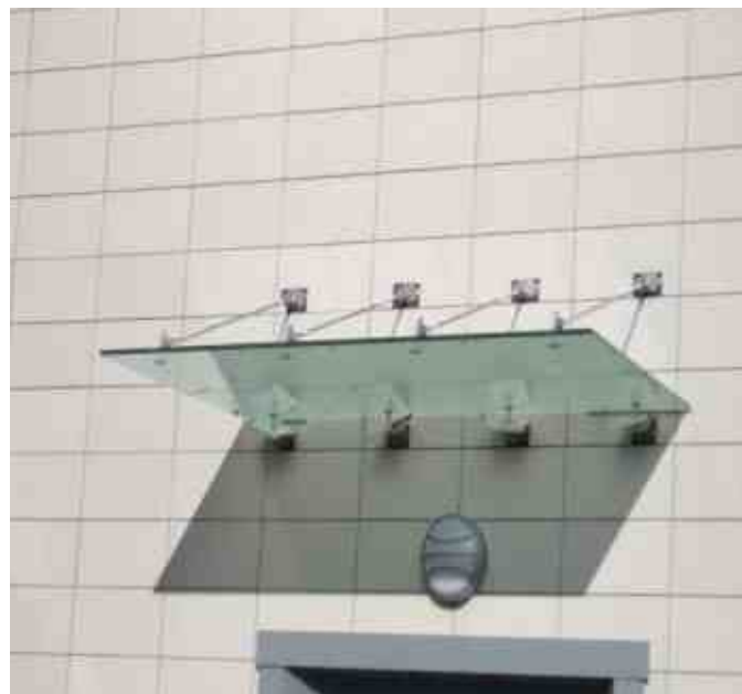
Козырек 1,5 x 2,5 метра на вантах. Стекло триплекс 8+8 мм.
