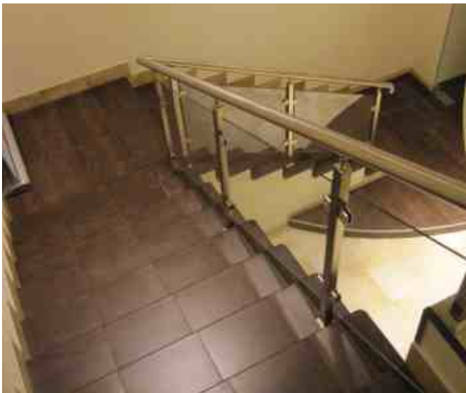
Ограждение из шлифованной нержавеющей стали на квадратных стойках, со стеклянным наполнением между стойками.
