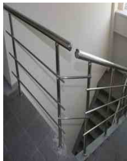
Выход на балкон лестничного марша, без завязки поручня и без завязки ригелей. Две перемычки внахлест для жесткости.
