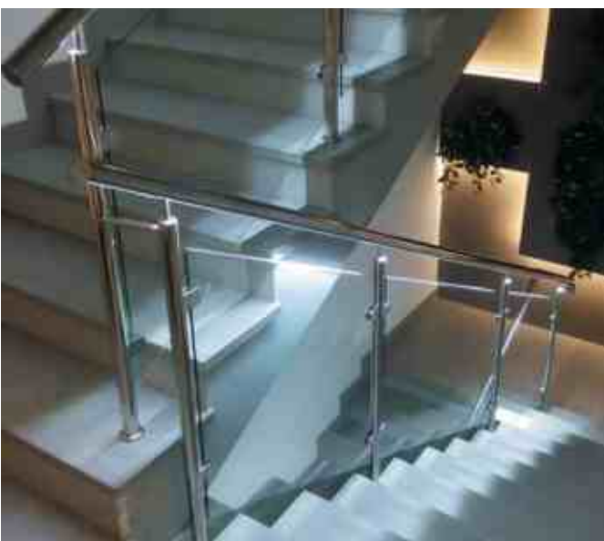
Простое ограждение на зажимных стеклодержателях. Освещение лестницы только с помощью подсветки внутри поручня ограждений.
