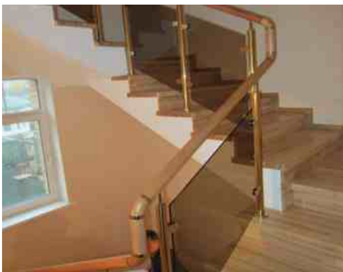
Стекло с пленкой под бронзу. Деревянный поручень завязан деревянными сегментами. Наконечник стойки k006, крепление стойки сверху в ступень цангой k026.
