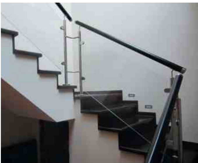
Ограждение без завязки пластикового поручня с двумя перемычками на поворотах. Осветленное стекло дает голубоватый оттенок.
