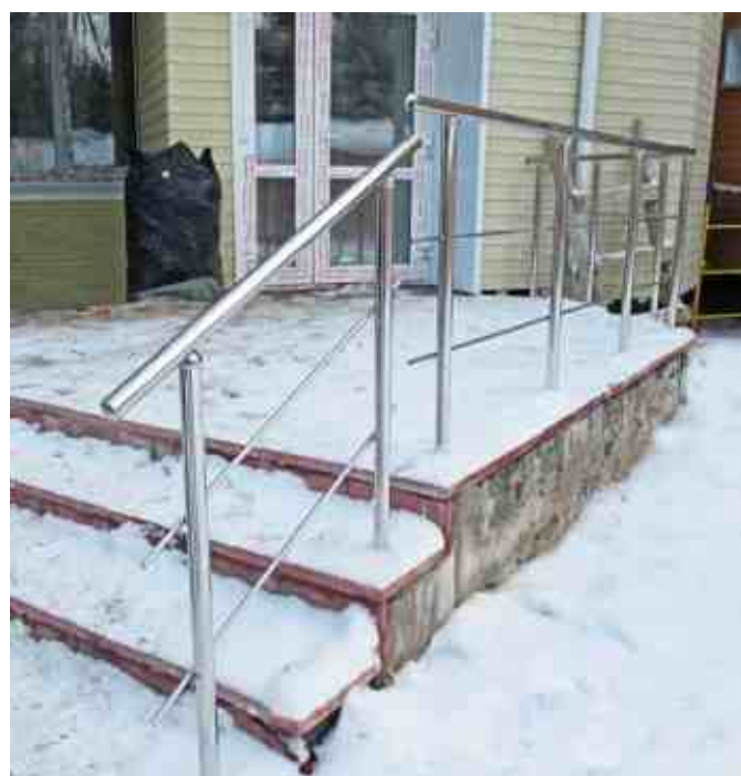
Ограждение входной группы эконом вариант с двумя ригелями. При выходе на площадку поручень и ригель прерывается.
