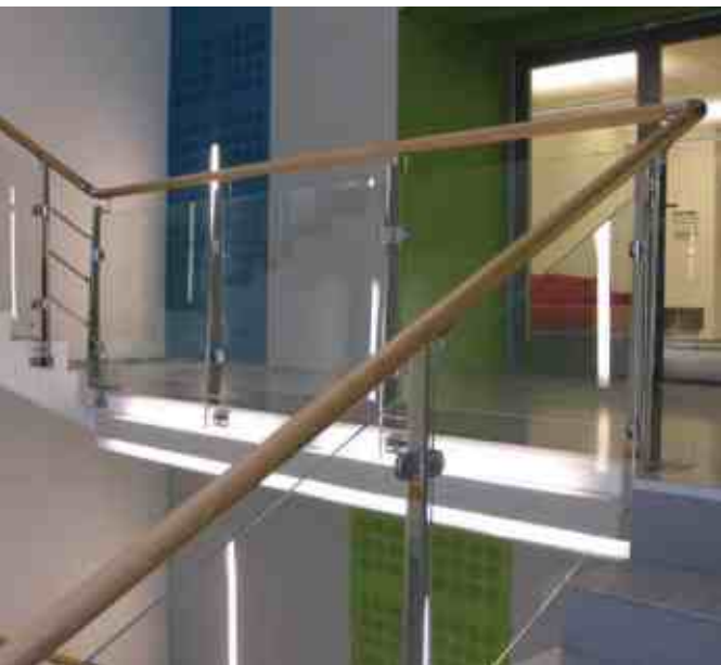
Офис компании из Финляндии. Нержавейка, стекло и деревянный поручень естественного цвета. Просто, без излишеств, экологично, приятно на ощупь, удобно, красиво и недорого.
