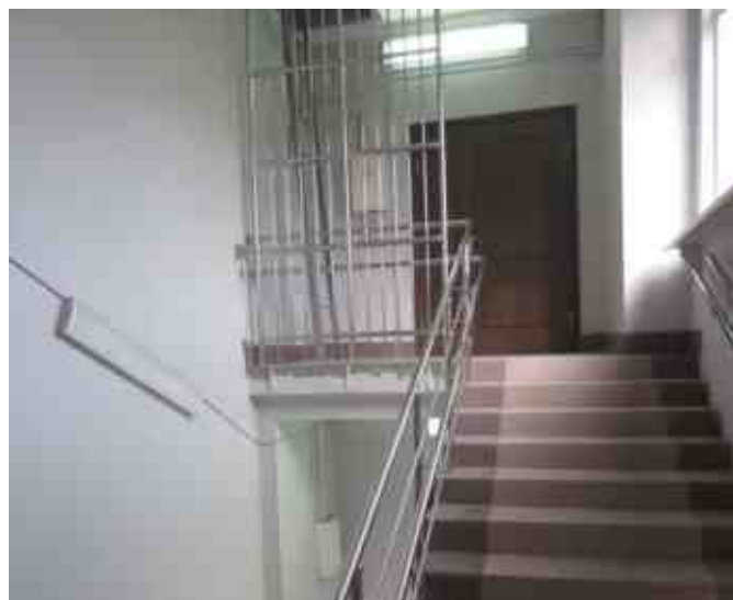
Ограждение площадки лестницы в здании управы. Дополнительный детский поручень на высоте 700 мм.
