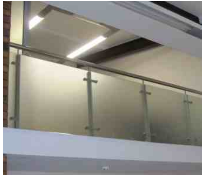
Ограждение на стойках 40x40 мм с ультра матовым стеклом и наконечником k239.
