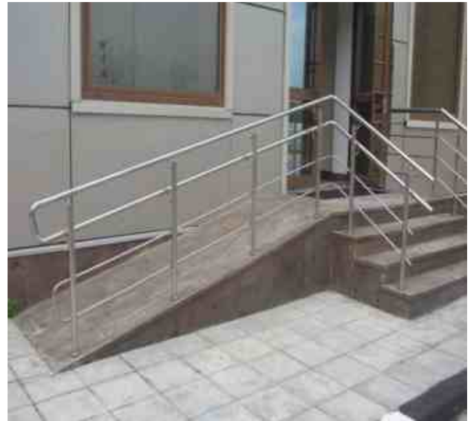
Обратите внимание, при проектировании уклон пандуса сделали слишком большим, не соответствующий ГОСТу. Перила пандуса выполнены по всем требованиям заказчика.
