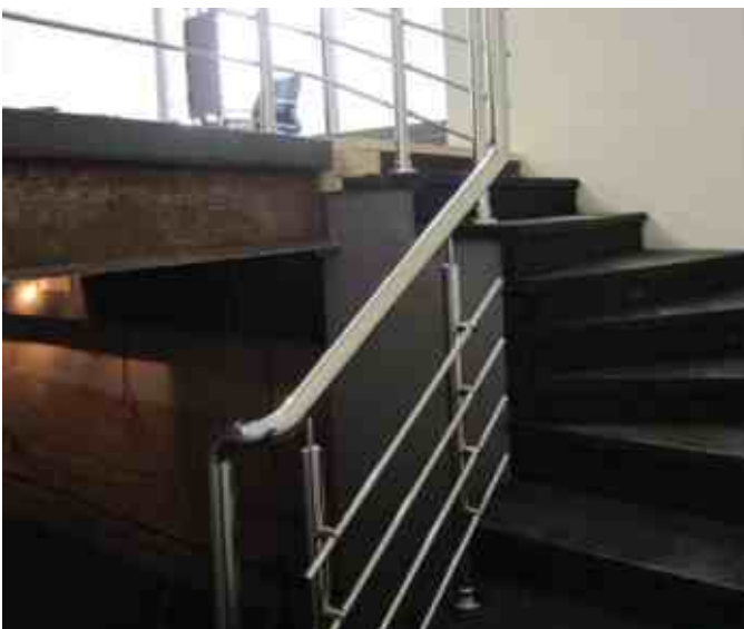
Завязка круглого поручня на 5 забежных ступенях (сохраняют площадь в ущерб удобству). Выход на вертикаль для общей жесткости. Обычно по таким лестницам ходят "по стенке". На стенке должен быть дополнительный пристенный поручень.
