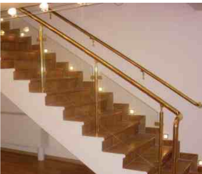
Ограждение с прозрачным стеклом, стойками и поручнем из латуни. Дублирующий пристенный поручень.
