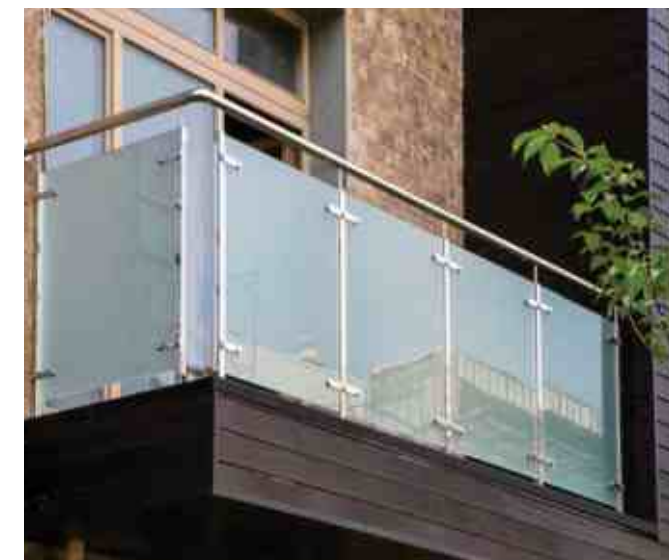
Ограждение балкона в элитном коттеджном поселке. Стекло матовое в массе для обеспечения приватности. Стекло установлено на пластинчатых стеклодержателях.
