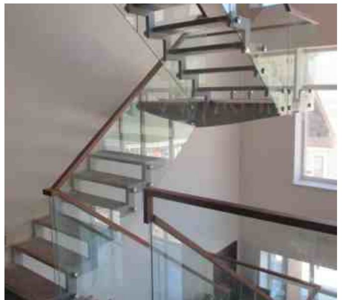
Воздушная лестница на металлическом косоуре с деревянными ступеньками, боковым крепежом ограждений и деревянным поручнем, повторяющим изгибы стекла.
