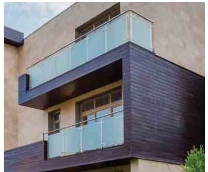
Ограждение балконов в таунхаусе. Обеспечена приватная зона за счет тонировки стекла химическим травлением
