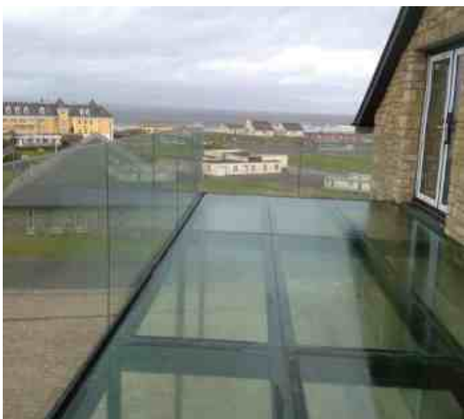
Стекло́нный пол на балконе может служить прозрачным навесом над патио. Ограждение без стоек это лучший выбор для созерцания прекрасного пейзажа.
