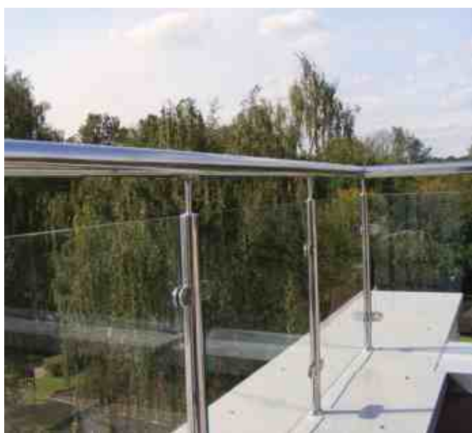
Ограждение балкона с круглыми стойками д. 38 мм. Стекло 8 мм крепится на зажимных стеклодержателях.
