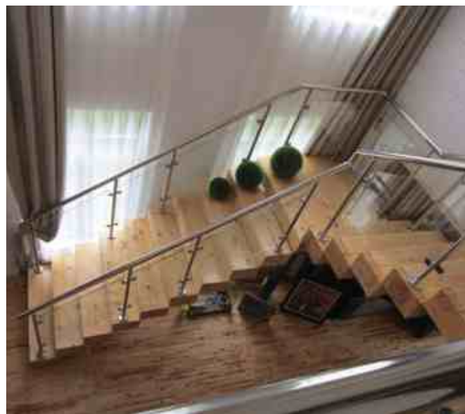
Ограждение со стеклом 8 мм на зажимных стеклодержателях k039, большие крышки k201 прикрывают треханкерные закладные k232.
