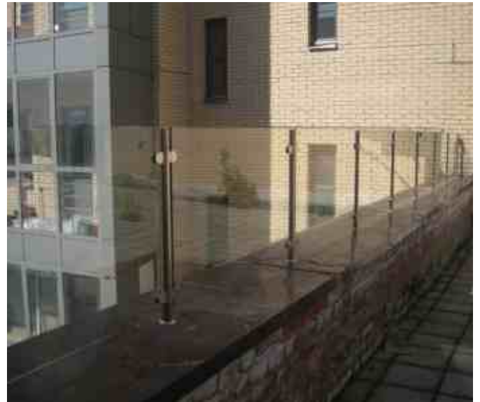
Самое доступное по цене из стеклянных ограждений: стойка д.38 мм, зажимные стеклодержатели k038, стекло закаленное 8 мм обычное.
