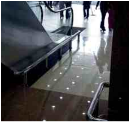
Отбойник защищает отделку эскалатора.
