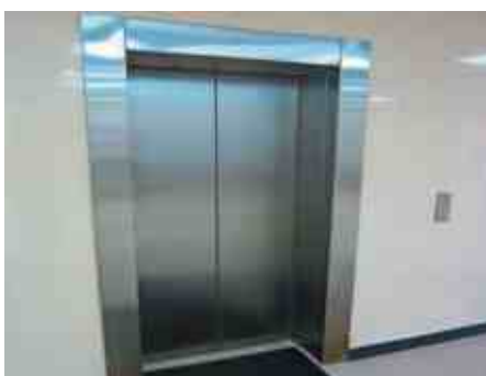
Облицовка нержавеющей сталью 86
