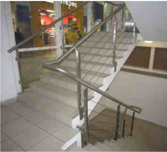
Ограждения на пластинчатых стойках из нержавеющей стали с 5 тросиками и круглым поручнем, завязанным на поворотах, с выносом на площадку. Тросики завязаны между маршей.
