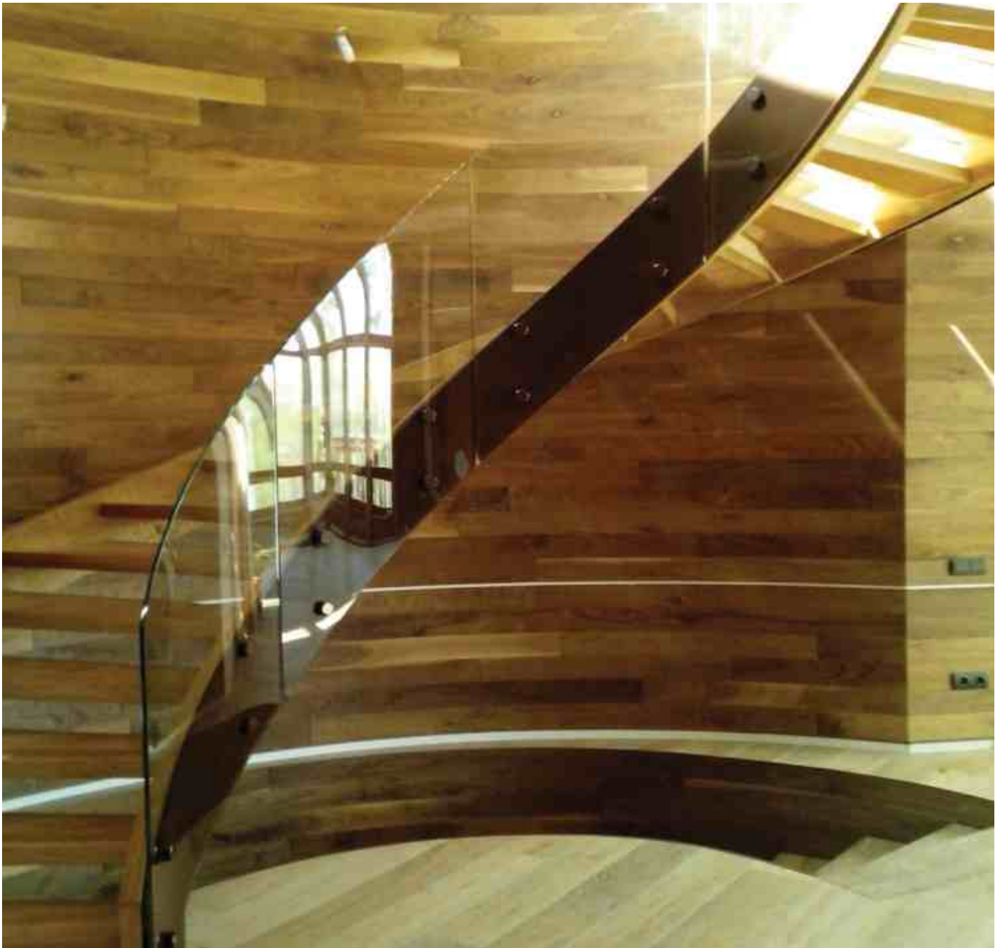
Стеклянное ограждение забежной лестницы с боковым крепежом на точках, без поручня. Стекло 12 мм гнутое по радиусу.
