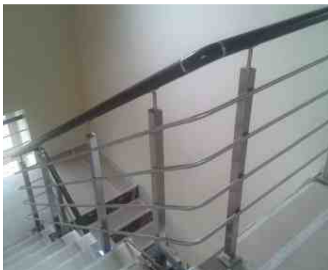
Чистовые полы укрыты картоном до начала монтажа четырехригельного ограждения на квадратных стойках 40 x 40 мм. Крышка K076, наконечник K239. Ригели приварены внахлест со стойкой завязаны между маршей. Поручень деревянный, завязан на поворотах кольцами.
