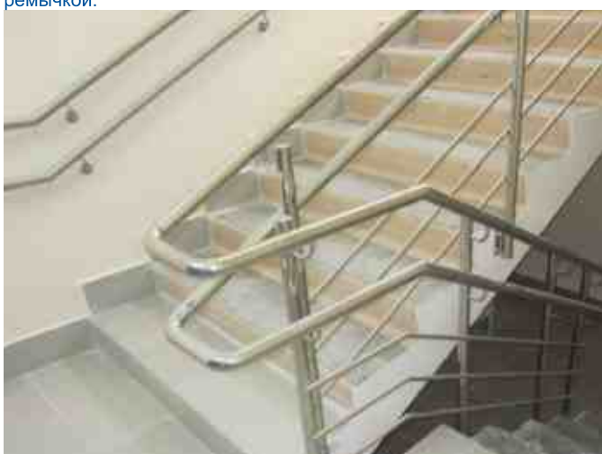
Ограждение в частной больнице с двумя поручнями д.38 мм на выносе. Стойки крепятся сбоку на пластине K056. На стене выполнен дублирующий пристенный поручень для облегчения подъема в обе стороны.
