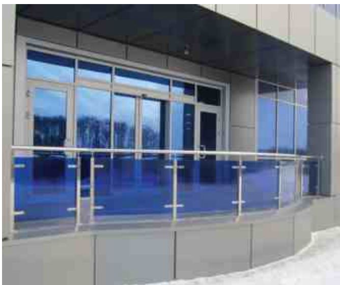
Ограждение балкона входной группы с тонированным синей пленкой стеклом 8 мм на пластинчатых стеклодержателях. Стойки 40x40 мм, поручень круглый 50 мм.
