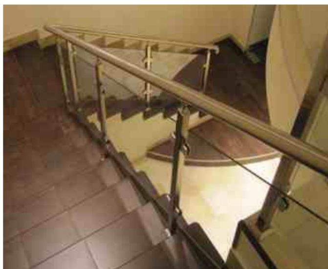
Ограждения лестницы на квадратных стойках 40x40 мм из шлифованной нержавеющей стали, с наконечником k203. Мощные и красивые квадратные литые стеклодержатели k003.
