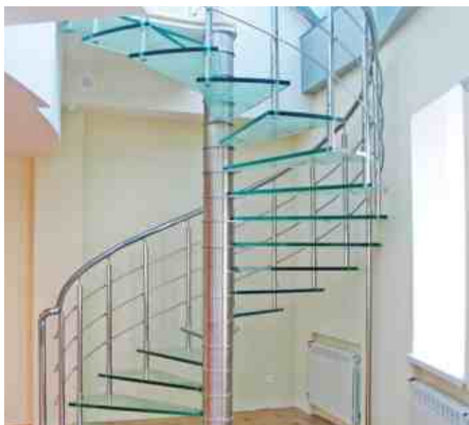
Большевая винтовая лестница на наборном центральном столбе с трехригельным ограждением.
