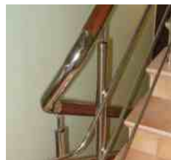
Завязка поручня вставкой из нержавеющей стали.
