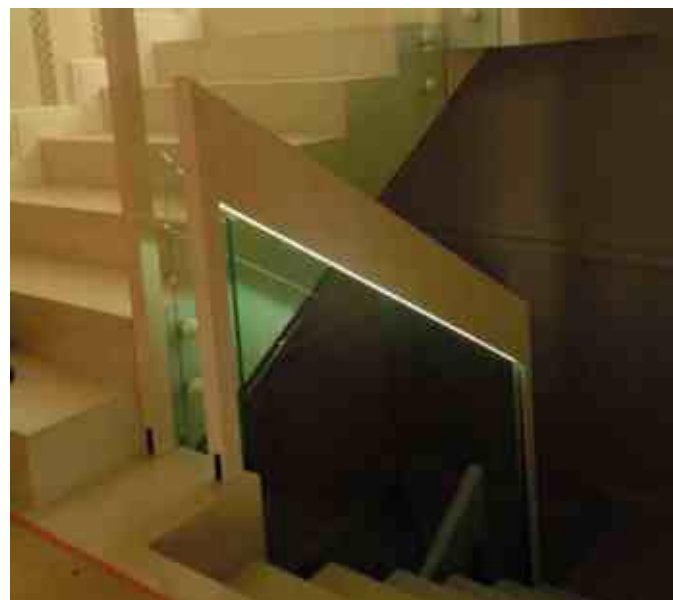
Дизайнерские ограждения с подсветкой сверху в торец стекла. Для красивого свечения применено английское стекло зеленоватого оттенка.
