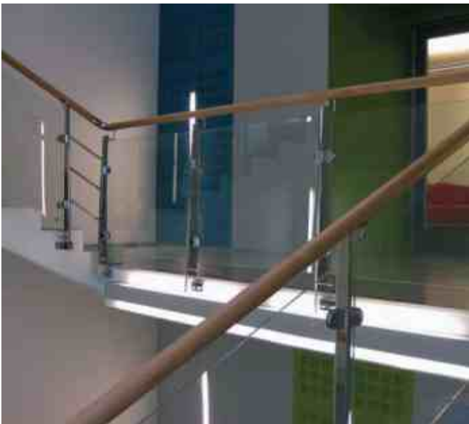
Ограждение с боковым крепежом, стойками из полированной нержавеющейки и зажимными стеклодержателями. Стекло триплекс 4+4 мм, деревянный поручень бук на выносе.
