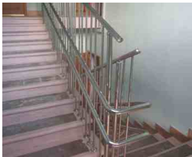
Ограждение с ригелями в школе. Выполнено с тремя поручнями д.38 мм на высоте 500 мм, 700 мм и 1500 мм по ГОСТу. Поручни завязаны между маршей. Верхний поручень не завязан для экономии. Каждый вертикальный ригель забурен в лестницу.
