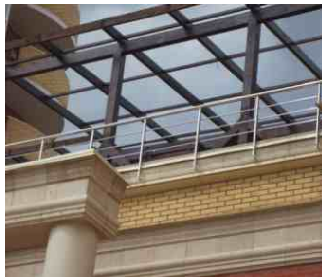
Ограждение террасы с боковым крепежом в фасад, с тремя ригелями д.16 мм и стойками с интервалом 1 метр. Нержавеющая полированная сталь.
