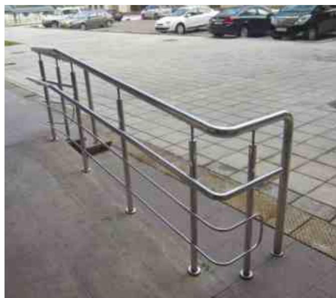
Ограждение входной группы скомбинировано с перилами на большом пандусе, уход поручня в пол придает дополнительную жесткость всей конструкции.
