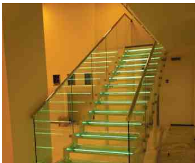
Лестница на двух косоурах из черного металла. Ступени из триплекса 10+10+10 мм с подсветкой. Ограждение из стекла 12 мм установлено сбоку. Поручень д. 48 мм с пазом.
