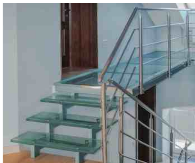
Ступени и площадка из триплекса 8+8+8 мм. Ступени приклеены на точки с помощью ультрафиолетового клея.
