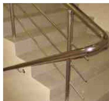
Уход поручня ограждения на пристенный поручень.
