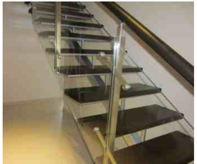
Ограждение на стойках со скрытым боковым крепежом и смыканием стеклянных панелей за стойкой. Стекло крепится на пластинчатых стеклодержателях.
