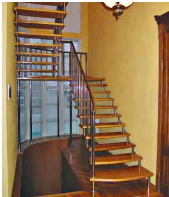
Больцевая лестница с дубовыми ступенями. Больцы по обеим сторонам.
