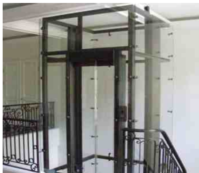
Облицовка стеклом лифтовой шахты.
