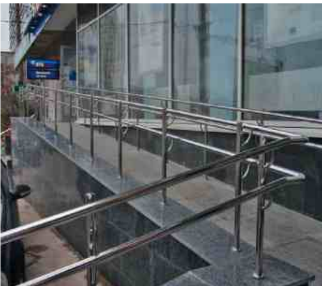
Ограждения «Г-образного» пандуса отделения банка. Ограничителем с внешней стороны служит парапет, в который сверху закреплены стойки с двойным поручнем на высоте 700 мм и 900 мм.
