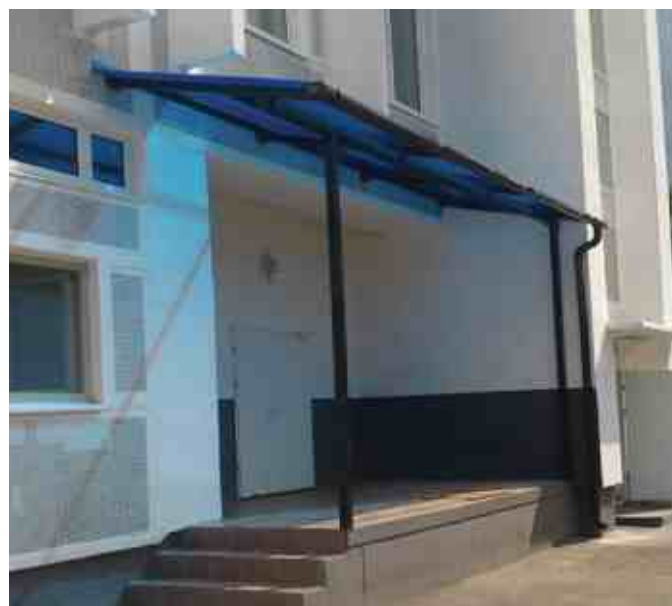
Навес из черного металла над входной группой жилого дома. Накрыт синим сотовым поликарбонатом.
