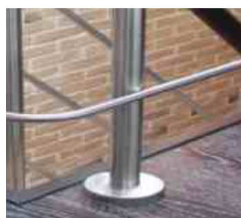
Большая декоративная крышка k201. Внешний диаметр 100 мм.
