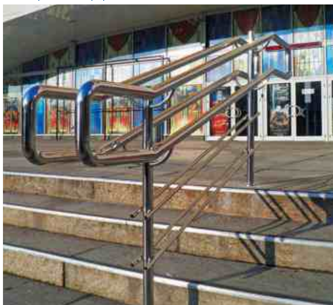
Потокооразделитель на лестнице при входе в кинотеатр. Поручень на выносных держателях расположен по обе стороны от стоек.
