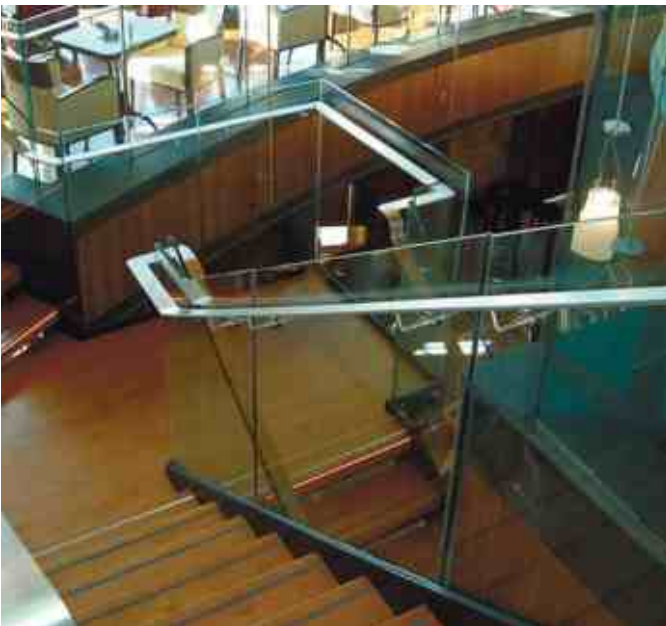
Ограждение ресторана без стоек высотой 1200 мм, без защиты кромок, с ультрапрямоугольным поручнем 10x80 мм, плавно перебегающим с марша на марш.
