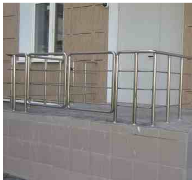
Ограждение входной группы погрузочно-разгрузочной зоны магазина. Специально оборудовано калиткой из нержавеющей стали с замком.
