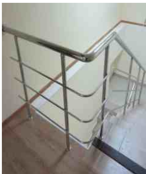
Выход на балкон лестничного марша, площадка забегает на марш и, чтобы сохранить высоту поручня, поворачивает в горизонте на длину выбега.
