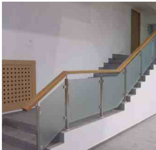
Ограждение с деревянным поручнем цвета «натур» и сечением 40x80 мм на квадратных стойках 40x40 мм и матовым стеклом. Крышка фланца стойки трапецевидная k064.
