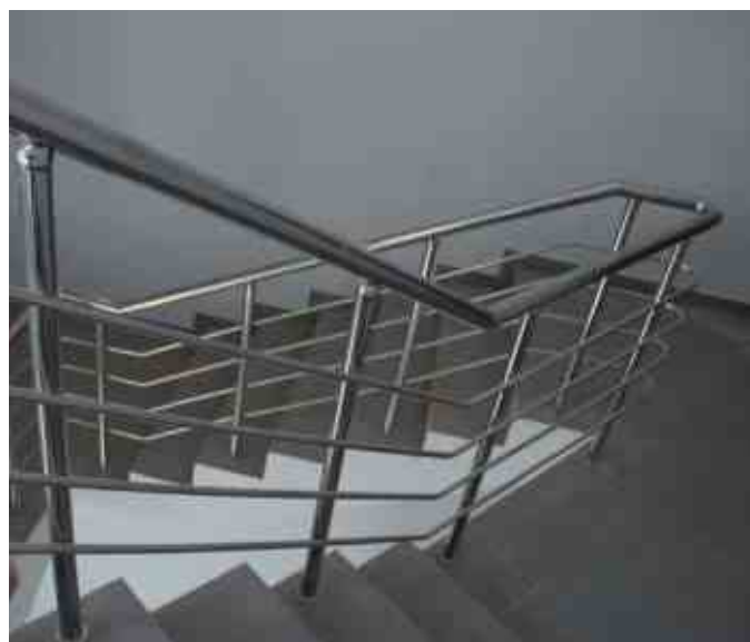
Ограждение колодезной лестницы с завязкой поручня, ригелей на поворотах. Крепление стоек сверху в ступень.
