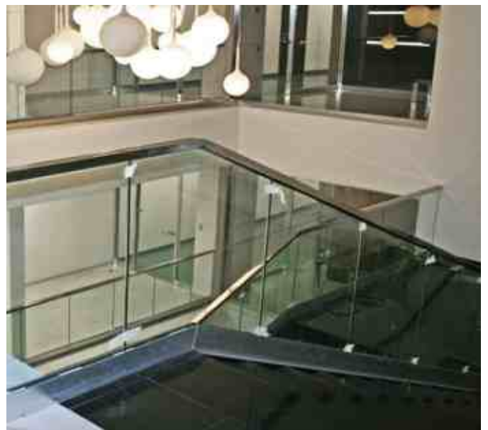
Ограждение в офисе без стоек с триплексом 8+8 мм, с прямоугольным поручнем с пазом к824 из полированной нержавеющей стали.
