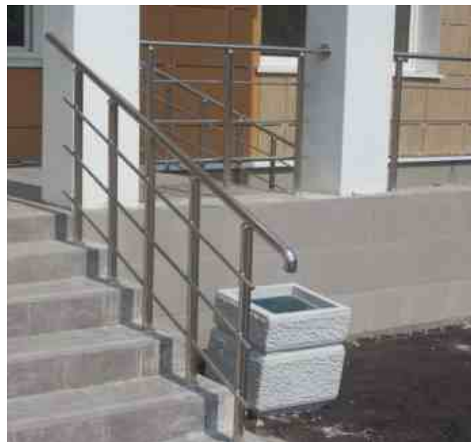
Ограждение входа в поликлинику. Стойки установлены в каждую ступень по просьбе заказчика, окончание поручня отвод k020.
