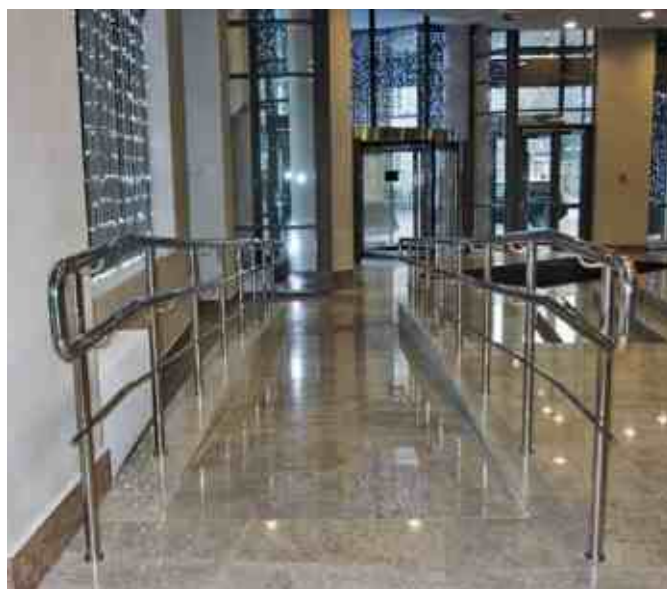
Ограждения пандуса внутри торгового центра. Крепление стоек осуществлялось методом бурения дорожного керамогранита и бетона и последующей вклейкой на специальный состав.
