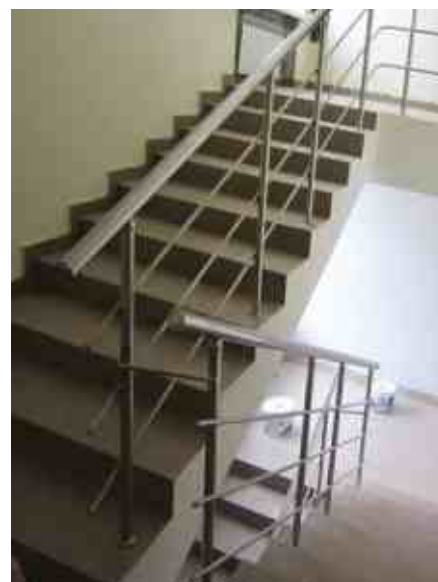
Стандартная лестница, ограждение с тремя ригелями, поручень и ригели развязаны между маршами. Стойки соединены одной перемычкой, выход на балкон завязан.
