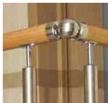
Завязка шарообразным соединителем.
