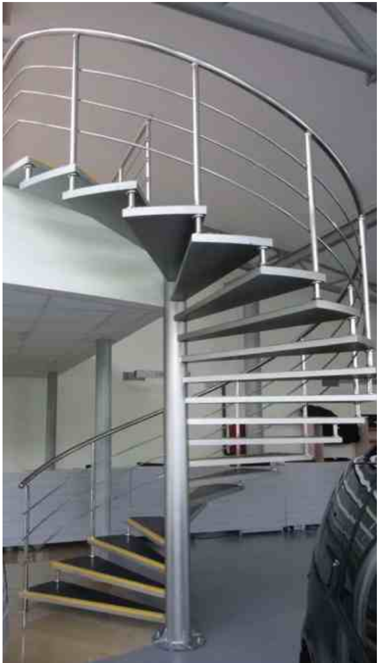
Винтовая лестница на центральном столбе и на больцах. Ограждение трехригельное прокатано по радиусу.
