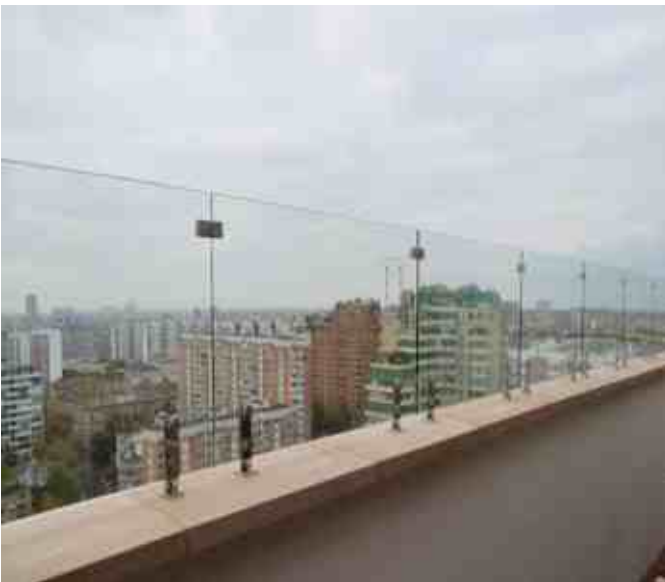
Ветрозащитное ограждение балкона с креплением сверху в парапетную крышку с помощью мини-стоек k276.
