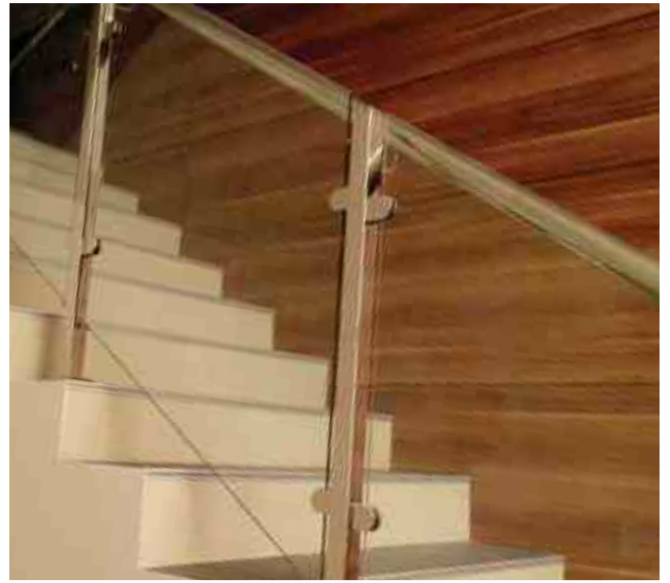
Ограждения лестницы на квадратных стойках 40x40 мм. Стекло прозрачное, поручень на выносах внутрь марша. Стеклодержатели на разных уровнях.
