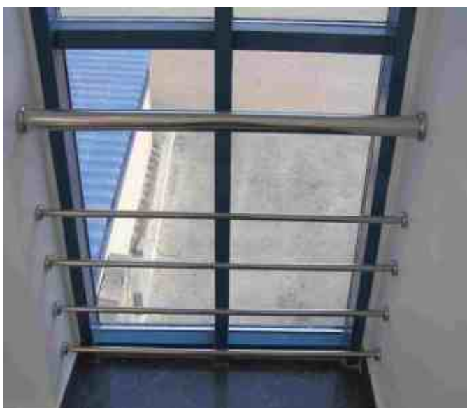
Ограждение с четырьмя ригелями в окне, враспор между откосами.
