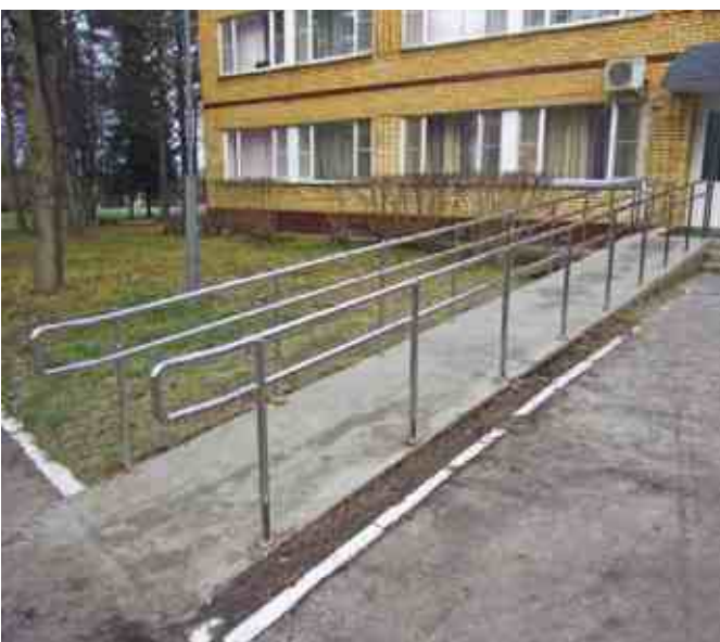
Асфальтированный пандус при входе в поликлинику. В местах крепления стоек на всю глубину залита песко-цементная смесь для надежности конструкции.
