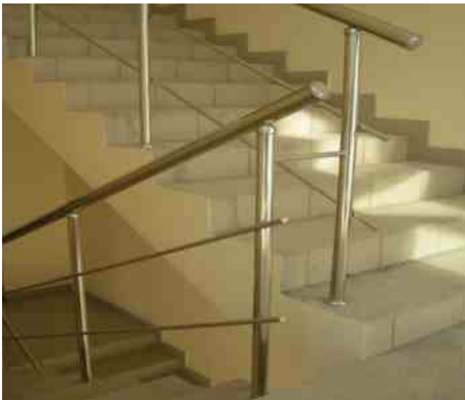
Самый экономичный вариант ограждений с 2-мя ригелями. Поручень и ригели развязаны. Для жесткости установлена перемычка между крайними стойками.
