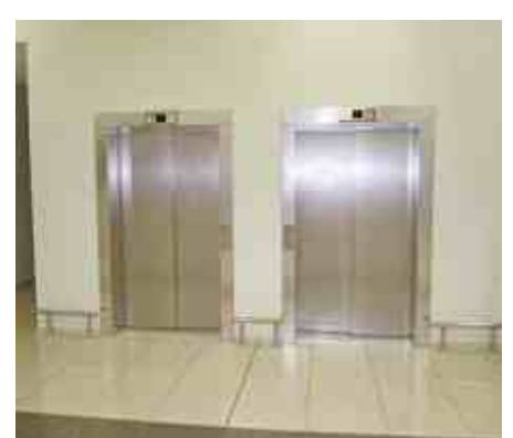
Защита отделки вокруг лифтового портала.
