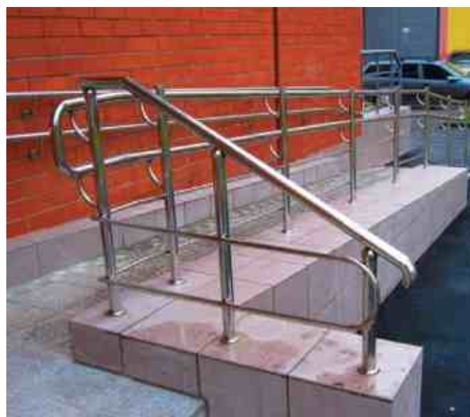
Ограждение парапета входной группы. Поручень повторяет конструкцию ступеней благодаря разной высоте стоек. Ригель непрерывен с ригелем пандуса.
