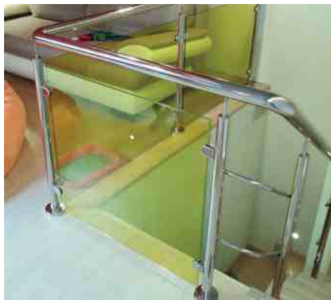
Стекло с желтой декоративной пленкой. На углу завязка 2 ригеля диаметром 16 мм. наконечник стойки сфера k034, крепление стойки сверху в ступень с большой крышкой k201.
