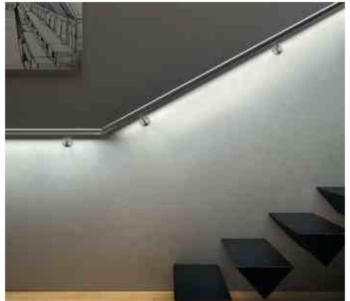
Зонирование светом, с помощью встроенного в пристенный поручень LED светильника. На лестнице с оригинальными консольными ступенями.
