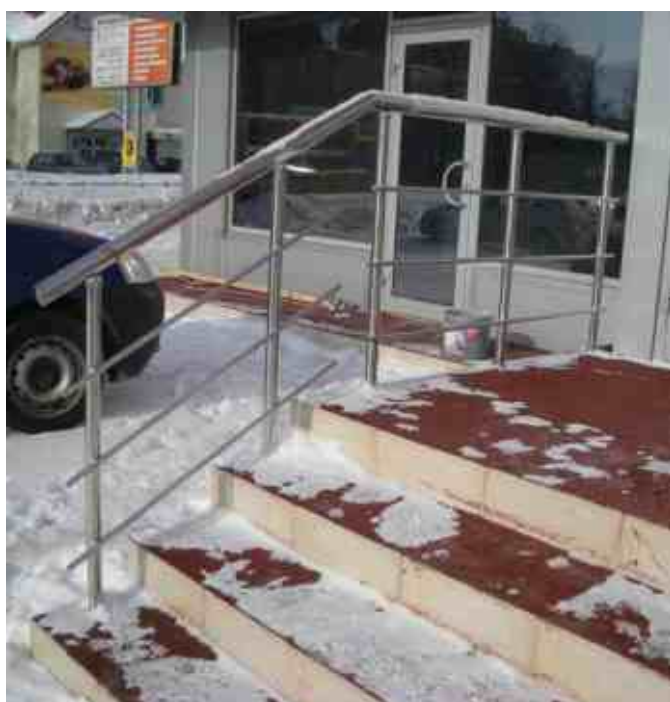
Ограждение входной группы с тремя ригелями. При выходе на площадку поручень непрерывен, а ригель прерывается.
