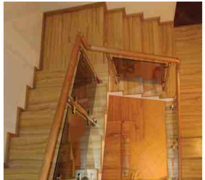
Колодезная лестница с деревянным поручнем и ограждением на зажимных стеклодержателях со стеклом цвета бронза.
