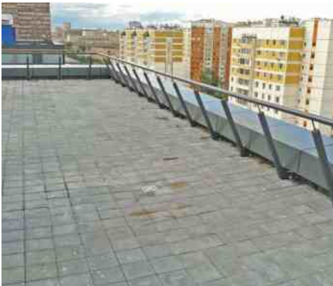
Черновое ограждение балкона в бизнес центре. Крепление стоек сбоку в парапет для сохранения архитектурного замысла: с земли ограждение не заметно за счет наклона стоек в площадь кровли.
