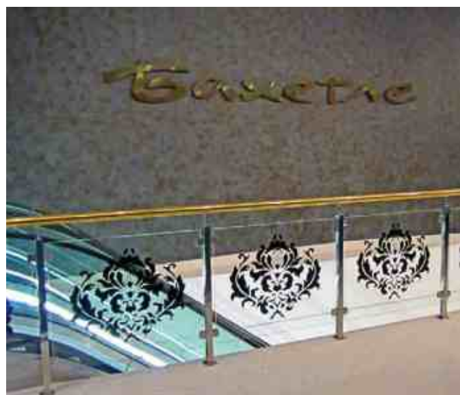
Ограждение на квадратных стойках с латунным поручнем квадратными зажимными стеклодержателями и стеклом 8 мм с рисунком.
