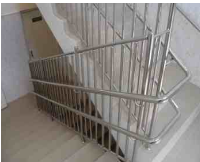
Ограждение в школе с маленьким межмаршевым расстоянием. Выполнено с тремя поручнями д.38 мм на высоте 500 мм, 900 мм и 1500 мм. Вертикальные ригели опираются на нижнюю балку д.25 с помощью деталей к212. Стойки завязаны между собой одной перемычкой.
