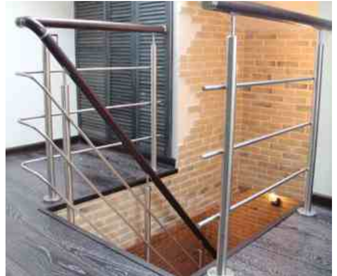
Круглые стойки диаметром 38 мм с большой крышкой k201, прикрывающей фланец треханкерной закладной с креплением в деревянный пол. Лестница с наклоном 60 градусов к горизонту забирает у дома мало площади, но ходить по ней не слишком комфортно. Поручень деревянный завязан с маршем.
