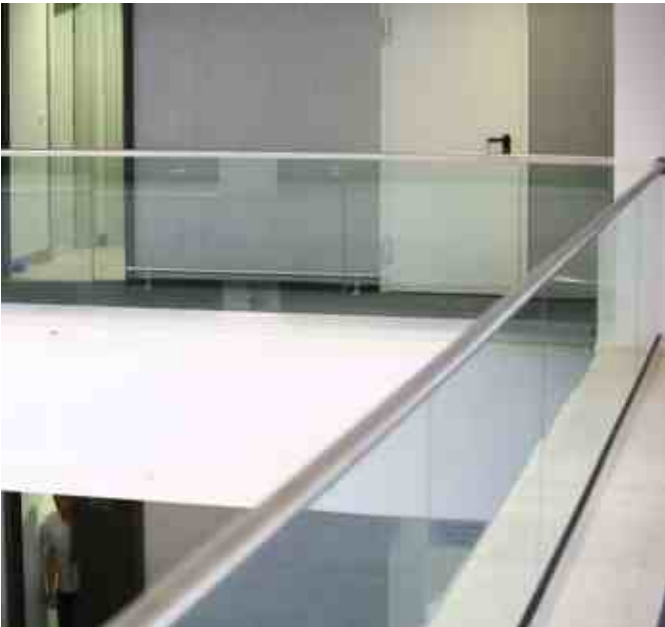
Ограждение со стеклом триплекс 8+8 мм в зажимном алюминиевом профиле k601 и поручнем с пазом диаметром 48,3 мм. Окончание поручня в колонну фланцем k238.
