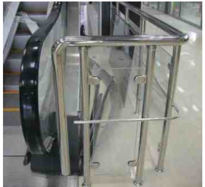
Примыкание к эскалатору. В данном случае бетонная плита подходит к механизму вплотную и крайнюю стойку удалось поставить поближе.
