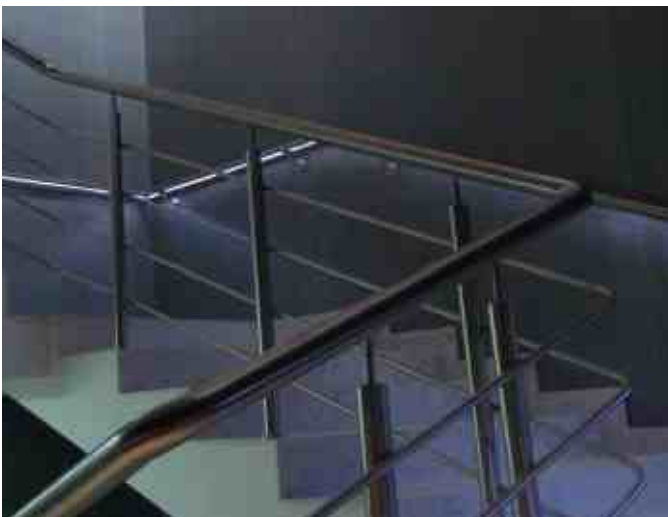
Подсветка эркера лестницы с помощью светильников, встроенных в пристенный поручень.
