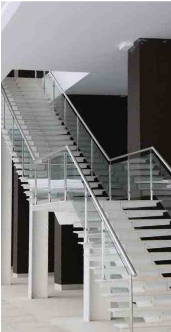
Ограждение с осветленным стеклом 8 мм на зажимных стеклодержателях. Стойки установлены через 3 ступени на 4-ю для ощущения пространства.
