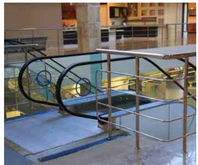
Экономичное примыкание к эскалатору. Стойки d = 38 мм, вертикальное заполнение ригелями 16 мм.
