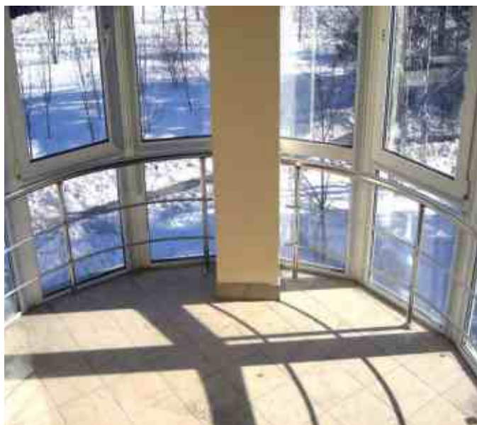
Ограждение в санатории с двумя ригелями гнутое по радиусу, предназначено для любования красивым пейзажем, открыв окно и облокотившись на поручень.
