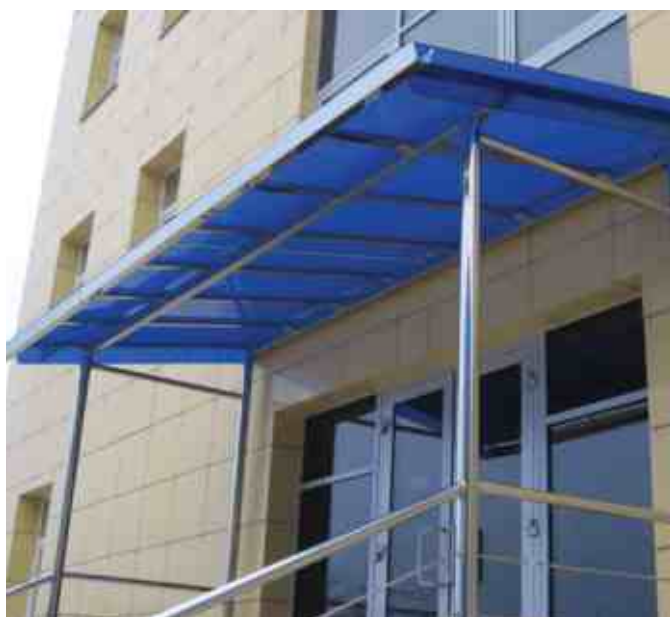
Козырек на нержавеющей металлокаркасе прямой облицован голубым монолитным поликарбонатом
