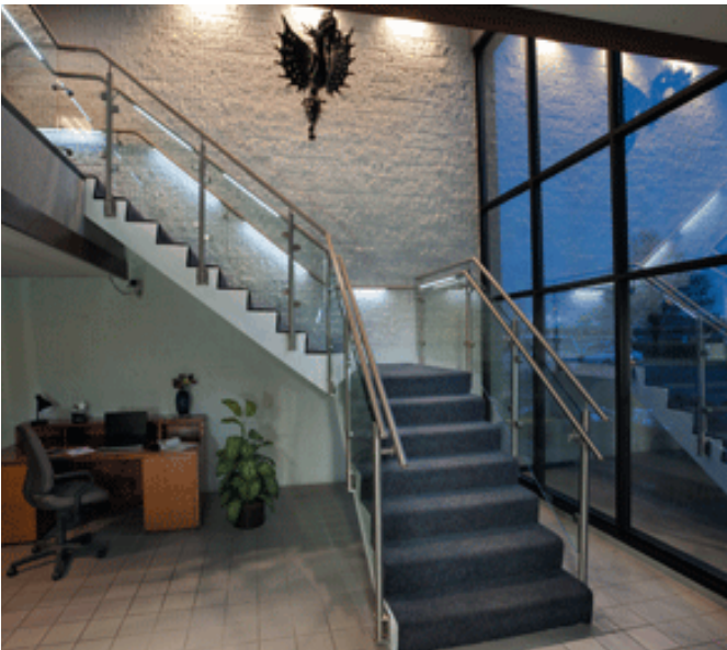
Освещение лестницы с помощью светодиодов. Стойки крепятся сбоку лестницы, подсветка вынесена в плоскость марша на детский поручень.
