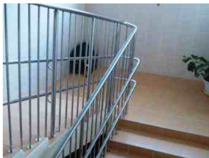
Ригельное ограждение в школе с креплением ригелей в вертикально в плитку и большой шайбой-крышечкой. Поручни на высоте 500 мм, 700 мм, 1500 мм, завязаны между маршей.
