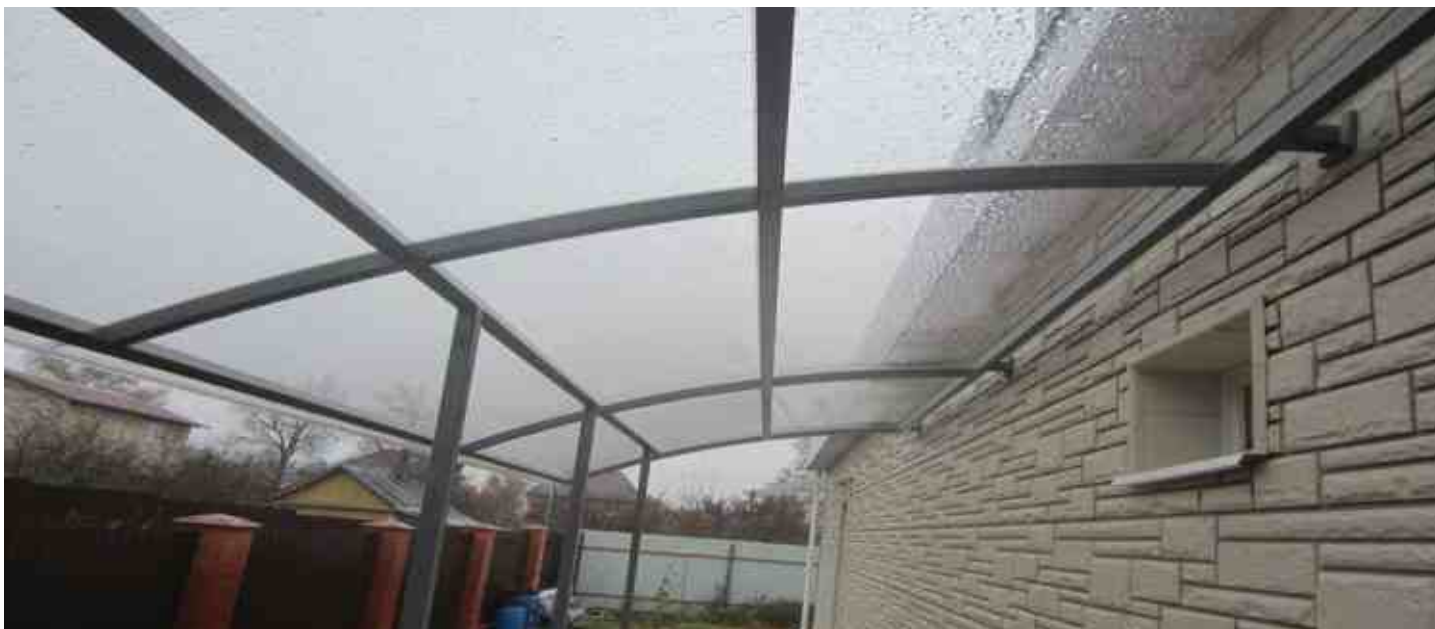
Навес для машины, примыкающий к дому. Каркас из черного металла, накрыт монолитным поликарбонатом толщиной 8 мм. Направляющие навеса прокатаны по радиусу для большей жесткости и схода снега.
