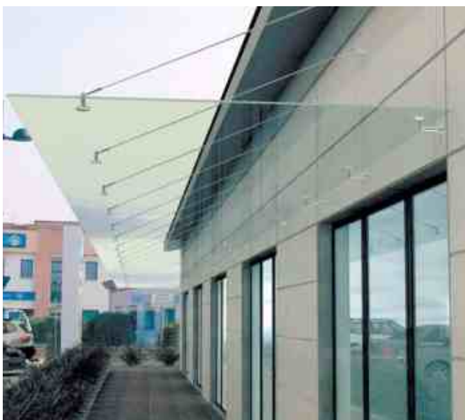
Козырек 2,2 м на 15 метров на вантах. Осветленное стекло 8+8 мм.
