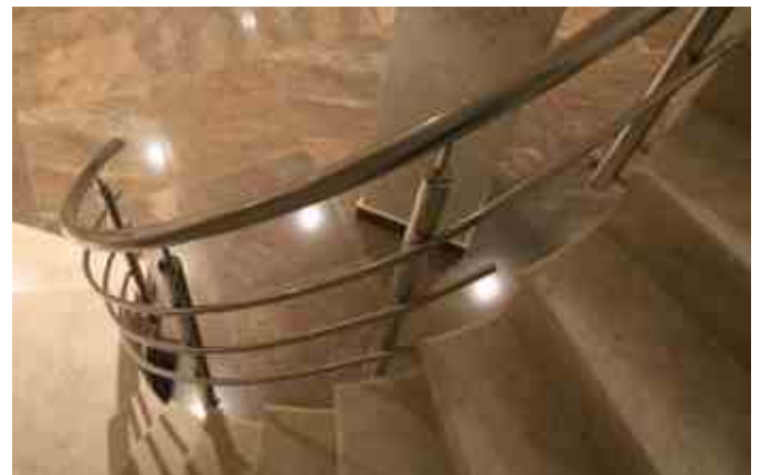
Ограждение забежной лестницы гнутое по спирали с ригелями в частном доме с торцевым креплением с выносом относительно марша.
