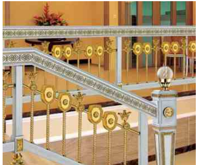
Секции из крашеного дуба с литыми деталями из латуни.
