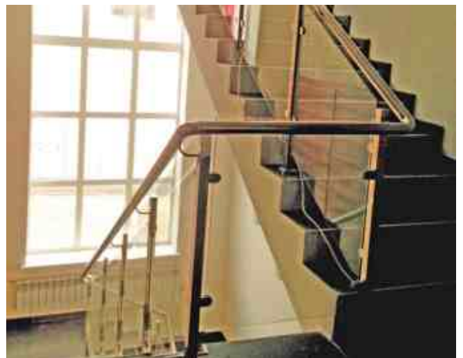
Ограждение с стеклом 8 мм на квадратных стойках 40x40 мм с просветом 600 мм между маршами. Круглый поручень 50 мм на выносах.
