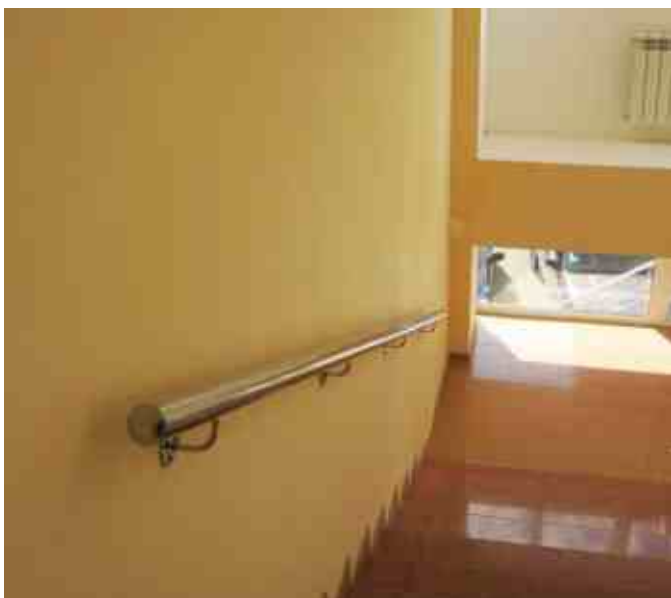
Классический простой пристенок. Диаметр поручня 50 мм, вынос 55 мм для обеспечения 25 мм зазора для свободного прохождения руки между поручнем и стеной. Крепление поручня снизу для удобного скольжения руки.
