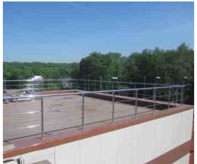
Самое простое ограждение обслуживаемой кровли в фитнес-центре: круглые стойки д.38 мм, 2 ригеля д.16 мм, наконечник стойки сфера k017, малый низ k015.
