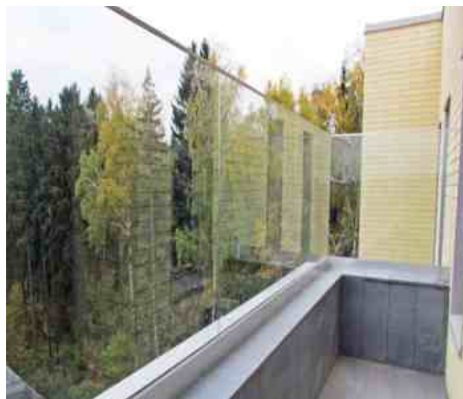
Ограждение балкона с креплением стекла сверху в алюминиевый профиль. Для дополнительной жесткости сверху стекла установлен П-образный профиль.
