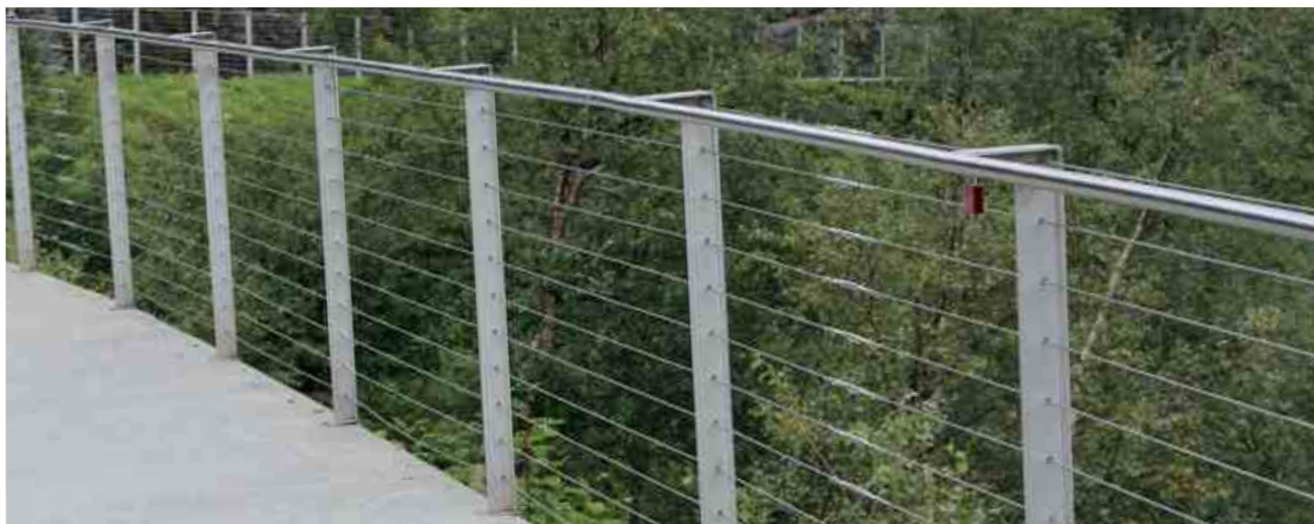
Минималистичное ограждение в 11 тросиков диаметром 5 мм на стойках из матовой нержавеющей стали с выносом поручня.
