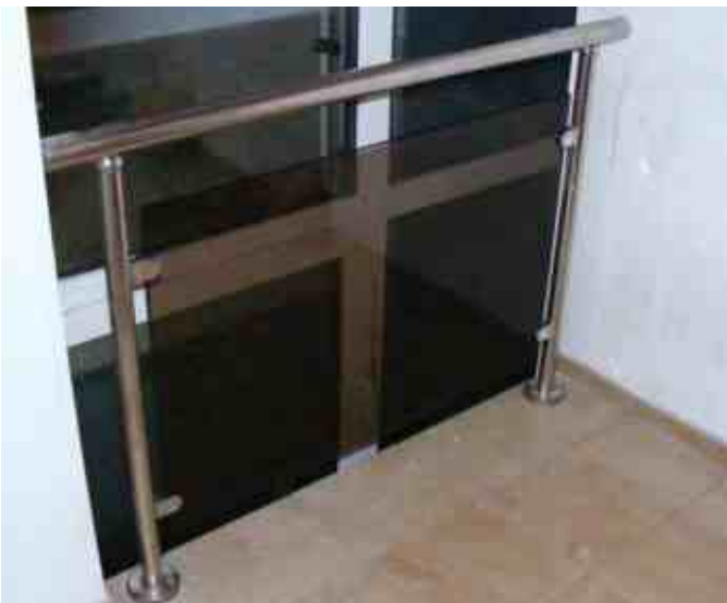
Защитное ограждение окна со стеклом цвета бронза.
