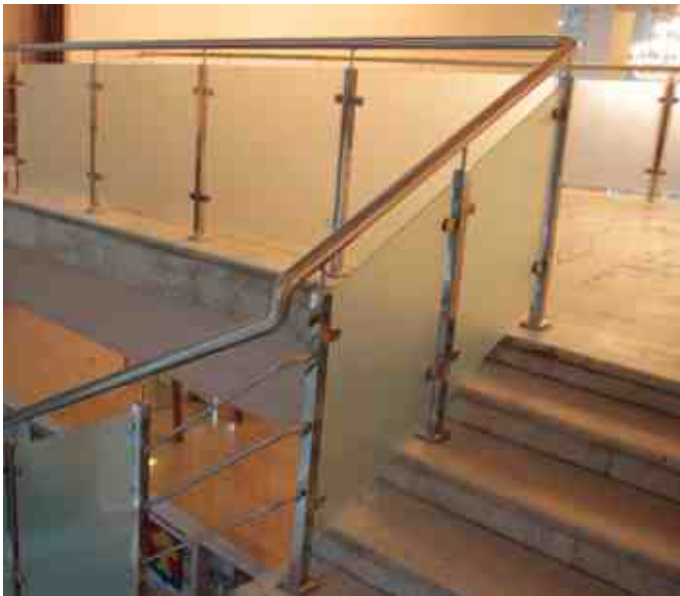
Ограждение колодезной лестницы с матовым стеклом и стойками 40x40 мм.
