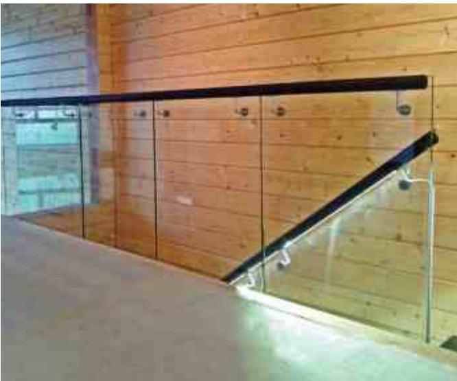
Ограждение без стоек с LED подсветкой внутри деревянного поручня д. 50 мм.
