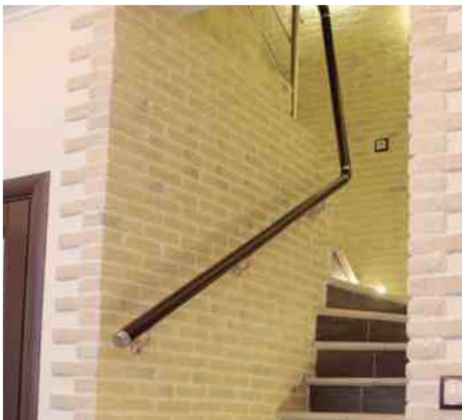
Пристенный поручень из дуба тонированный под красное дерево в цвет наличников на двери, завязан с основным ограждением с помощью соединителей типа «кольцо» и деревянных сегментов.
