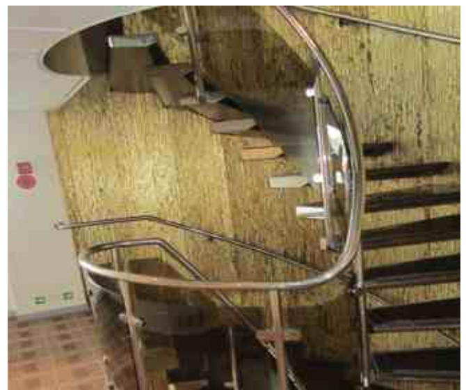
Стеклоанное ограждение с монолитным гнутым поликарбонатом на зажимных стеклодержателях, стойки без наконечников.
