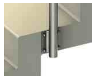
Крепеж пластина k056 (устанавливается на четыре анкера М8).
