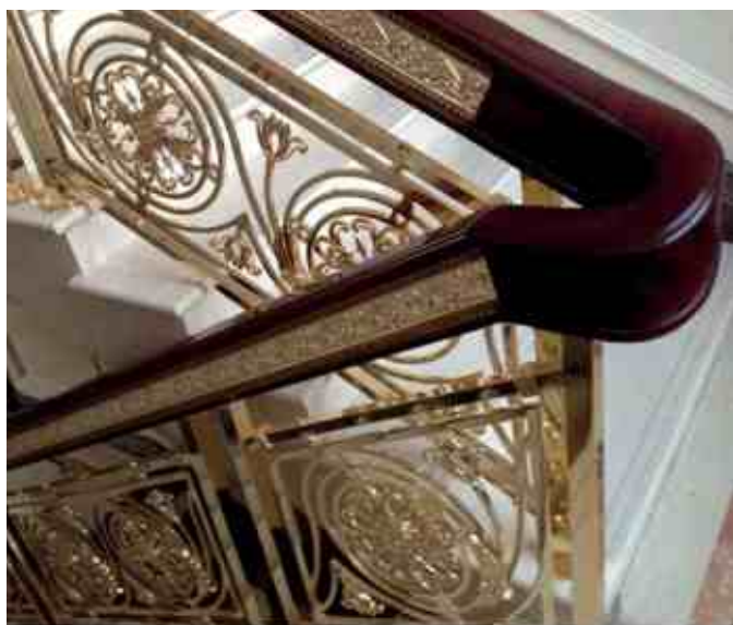
Литые секции из латуни на квадратных стойках и деревянным поручнем с латунными вставками, выполненные чеканкой.
