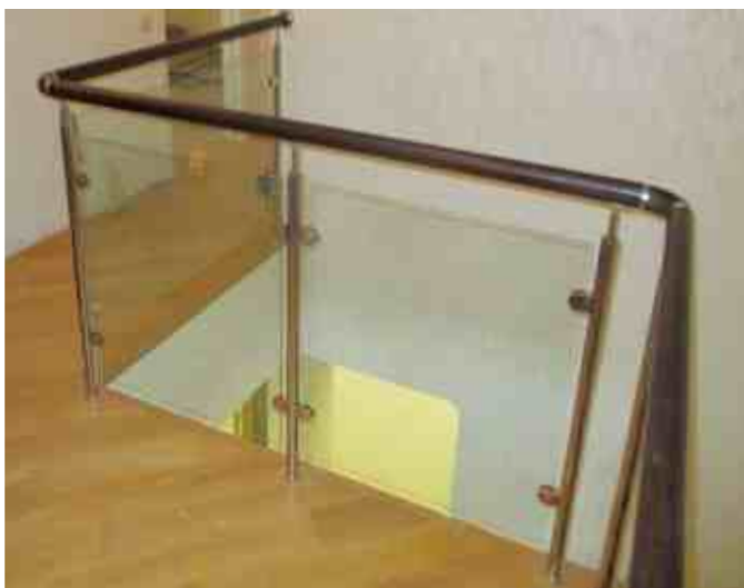
Деревянный поручень завязан деревянными сегментами с соединением декоративными кольцами. Наконечник стойки k006. На углах по 2 стойки, просвет не заполнен.
