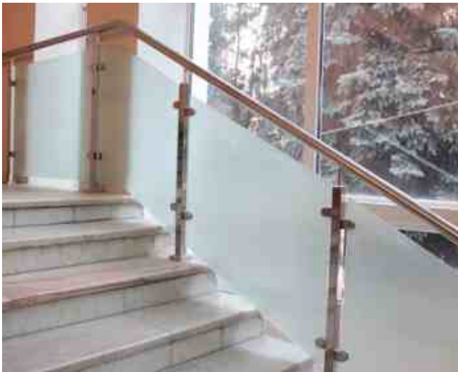
Ограждения лестницы на квадратных стойках 40x40 мм, крышка стойки k076. Стекло оклеено матовой пленкой. Стекло сложной формы на переходе на площадку.
