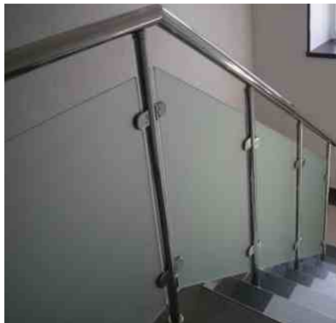
Ограждение со стеклом 8 мм, матовое со средним заполнением просвета между стойками стеклянным полотном. Наконечник стойки сфера k017, крепление стойки сверху в ступень с крышкой среднего размера k043.
