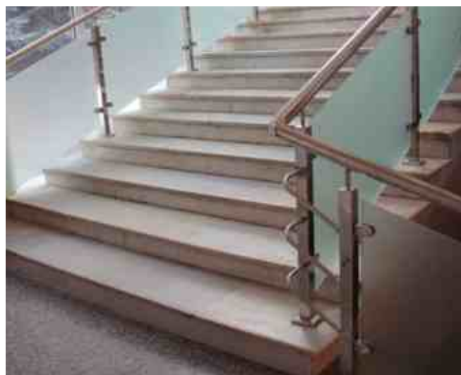
Ограждение на квадратных стойках 40x40 мм, стекло с ультра-матовой пленкой. На углах завязка 3 ригеля по 16 мм каждый. Зажимные стеклодержатели k039.
