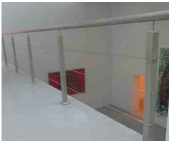
Ограждения из шлифованной нержавеющей стали с тремя тросиками на квадратных стойках 40x40 мм с круглым поручнем диаметром 50 мм.
