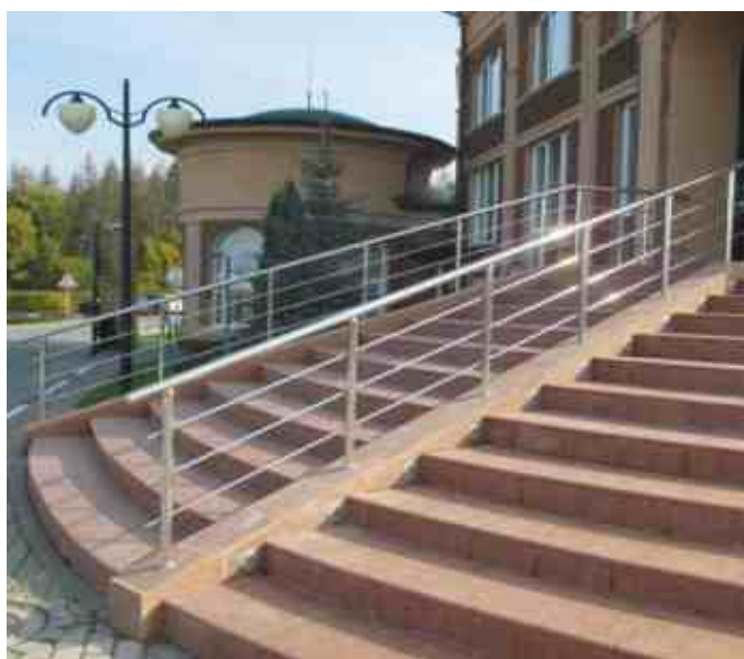
Ограждение парапета входной группы с тремя ригелями элитного частного дома. Благодаря полировке нержавеющей стали 800GRIT конструкция ограждений растворяется в пространстве.
