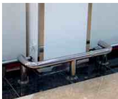
Колесоотбойники вокруг квадратной колонны, все развязано.
