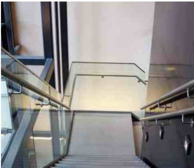
Ограждение без стоек с поручнем для детей на высоте 700 мм и поручнем для взрослых на высоте 900 мм. Комбинация дневного света, подсветки и глянцевых поверхностей заставляет свет струиться по всем плоскостям.
