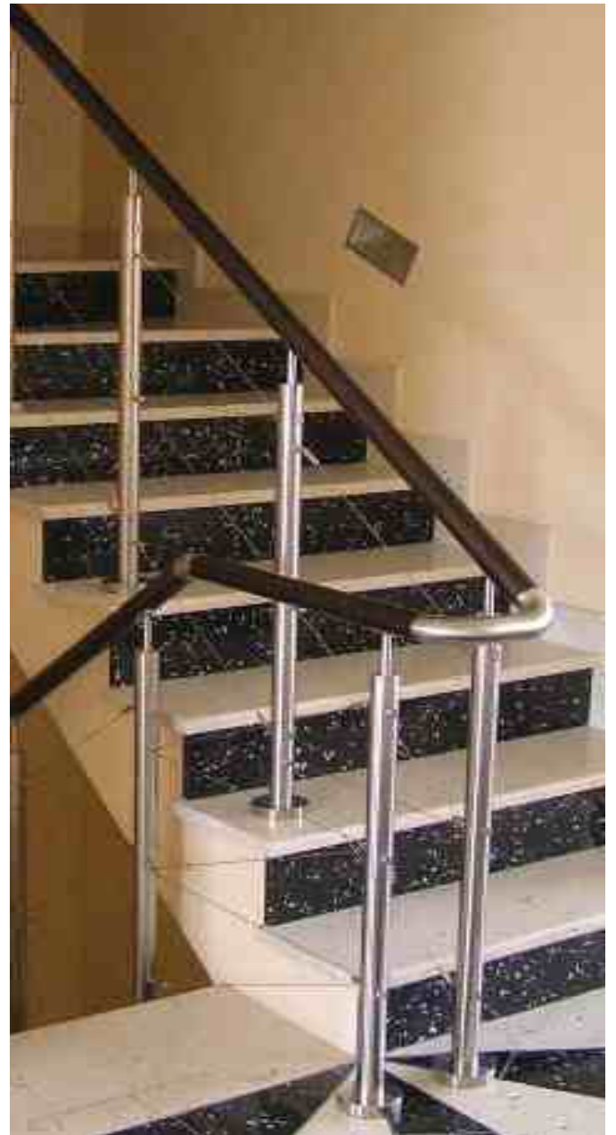
Тросики на этом ограждении выполнены вторым по популярности, после прямых линий методом - зигзагом. Такие ограждения выполняются на более мощных стойках, ведь трос натянут с большим усилием.
