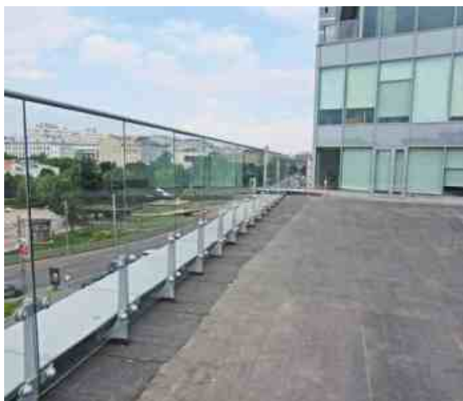
Ветрозащитное ограждение эксплуатируемой кровли. Стекло установлено на пластинчатые стойки из черного металла, поручень смонтирован на стекло сверху для жесткости конструкции.
