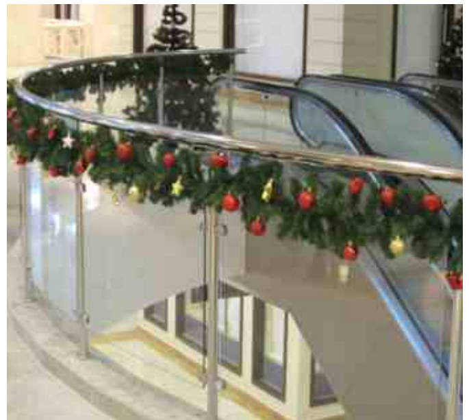
Ограждение круглого атриума: закаленное стекло толщиной 8 мм на зажимных стеклодержателях k038, наконечник k006, малая крышка k015.
