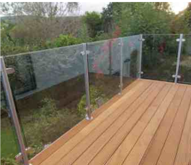
Ограждение балкона с круглыми стойками д.38 мм с креплением через декинг в бетонное основание. Стекло триплекс 4+4 мм крепится на зажимных стеклодержателях.
