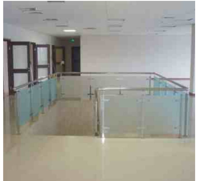
Последний этаж офисного здания, кабинеты директоров. Закаленное стекло 8 мм с матовой пленкой на пластинчатых стеклодержателях.
