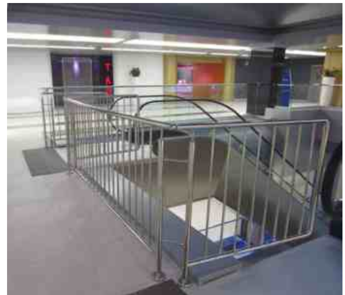
Экономичное примыкание к эскалатору. Устанавливать стойку в нишу электромоторов нельзя, поэтому консольное крепление на выносе. Стойки d = 38 мм, вертикальное заполнение ригелями 16 мм.
