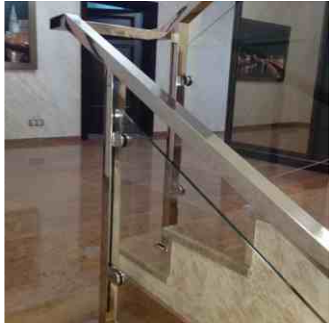
Ограждения лестницы на квадратных стойках 40x40 мм и квадратным поручнем 40x40 мм, со сложной завязкой на повороте, без наконечников.
