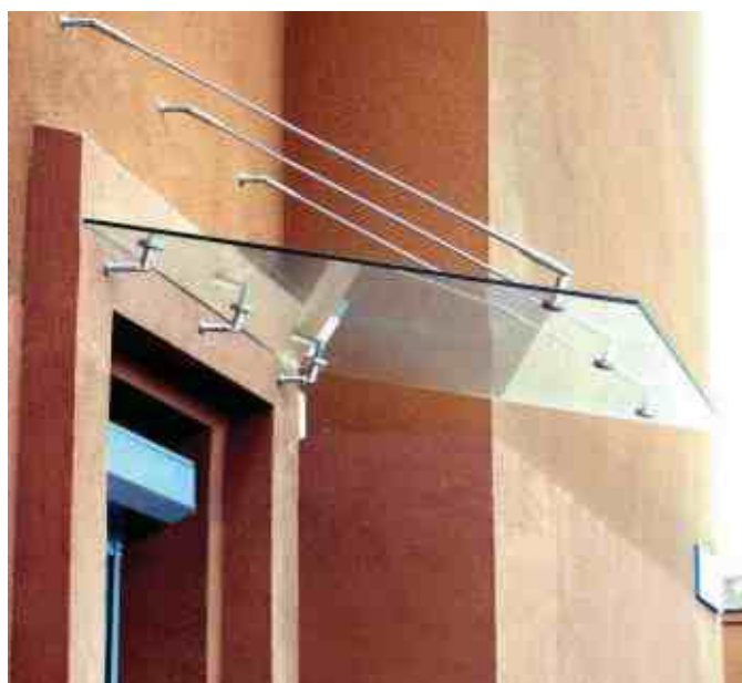
Простейший козырек на вантовом креплении.
