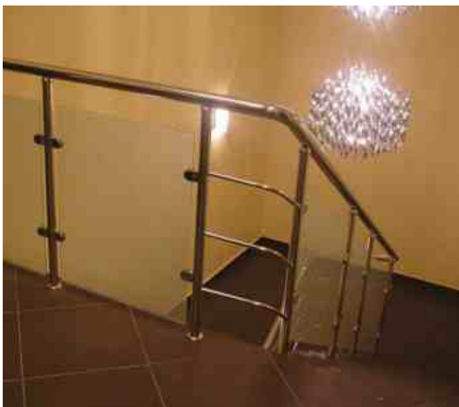
Стекло с матовой декоративной пленкой в полосочку. На углу завязка 3 ригеля диаметром 16 мм. Наконечник стойки сфера k017, крепление стойки сверху в ступень с малой крышкой k035.
