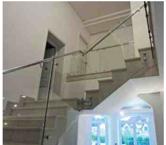
Колодезная лестница со стеклянным ограждением и выносом поручня на держателях k008.
