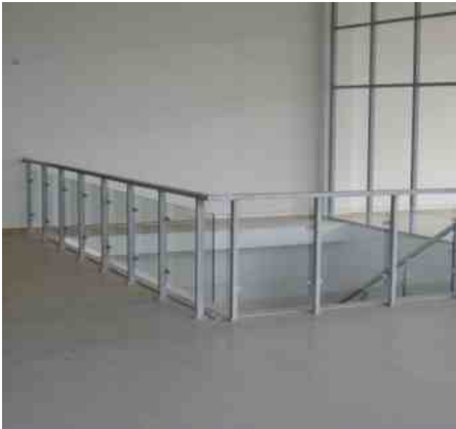
Ограждение в автосалоне. Мощные стойки из черного металла в цвет пола и стеклопакетов, по заданию от архитекторов должны удерживать машины от падения вниз.
