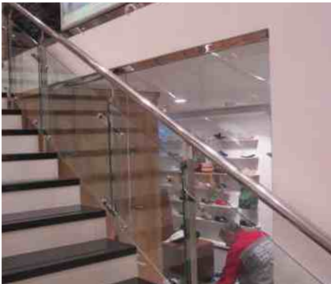
Ограждение на стойках 40x40 мм с боковым крепежом на пластинчатых стеклодержателях, смыкание стекол перед стойкой.
