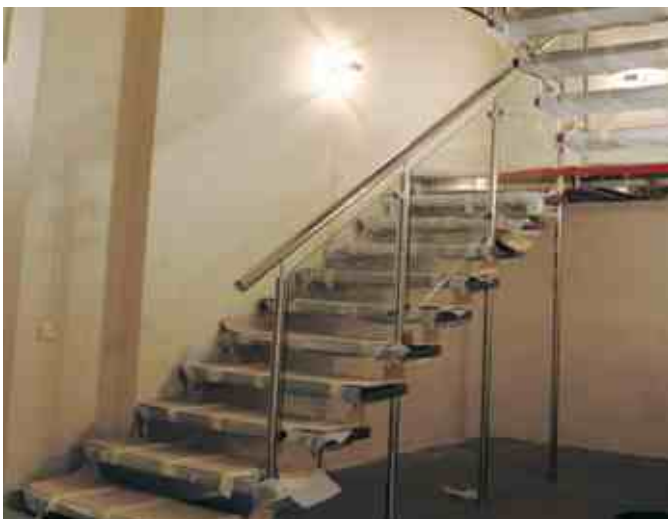
Ограждение со стеклом 8 мм с максимальным заполнением про света между стойками стеклянным полотном. Наконечник стойки к034, крепление стойки через болц ступени. Ступени укрыты картоном перед монтажом.
