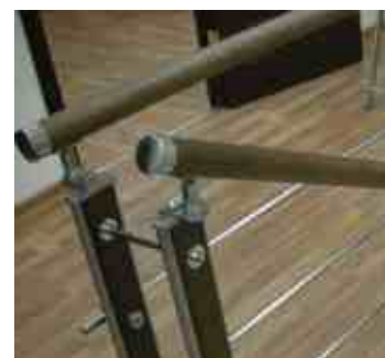
Деревянный поручень не завязан. Жесткость придает перемычками.
