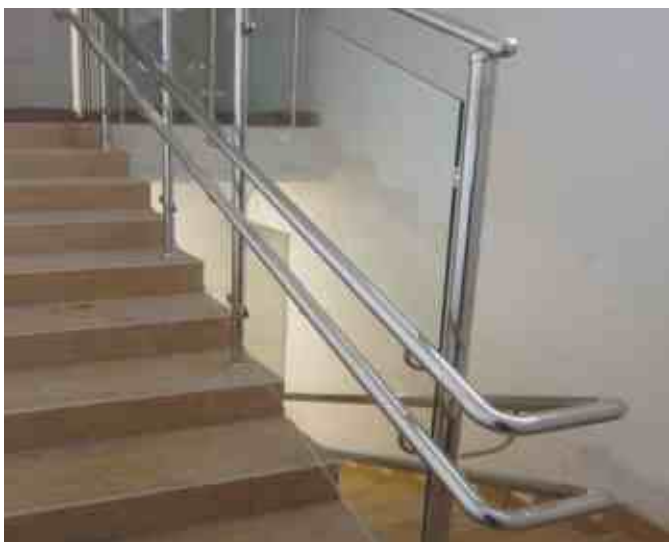
Ограждение для детского учреждения с безопасным стеклом триплекс 4+4 мм и 2-мя поручнями д. 38 мм на выносах от стойки на высоте 500 и 700 мм. Наконечник сфера k016, стеклодержатели k001, крепление сверху в ступень с маленькой крышкой k015.
