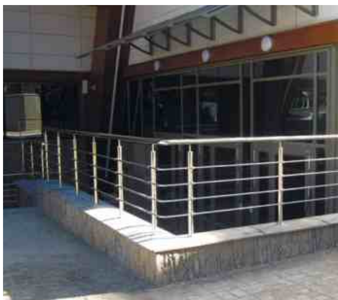
Ограждение парапета входной группы бизнес-центра. Круглые стойки и поручень, заполнение 4 ригеля с креплением к стойке через ригеледержатель k018.
