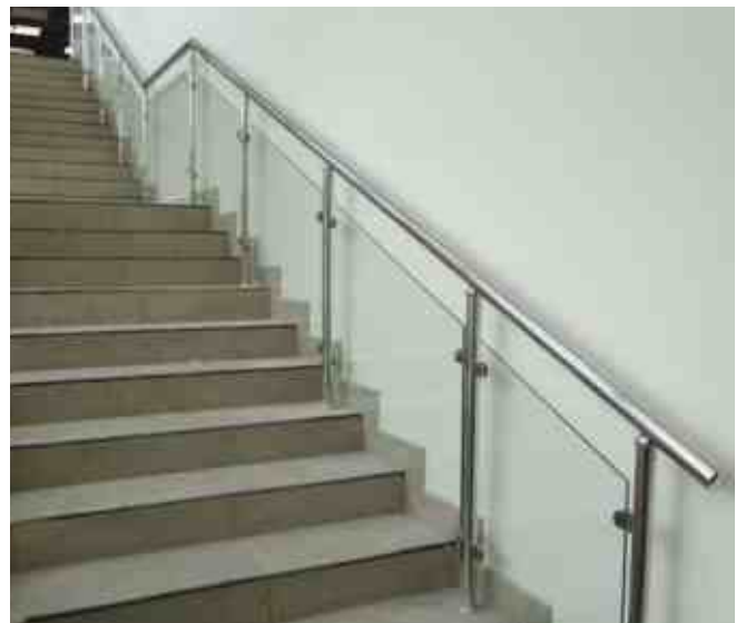
Ограждение с стеклом триплекс 4+4 мм на зажимных стеклодержателях. Наконечник сфера, крепление сверху в ступень. Поручень 50 мм, окончание плоская заглушка.
