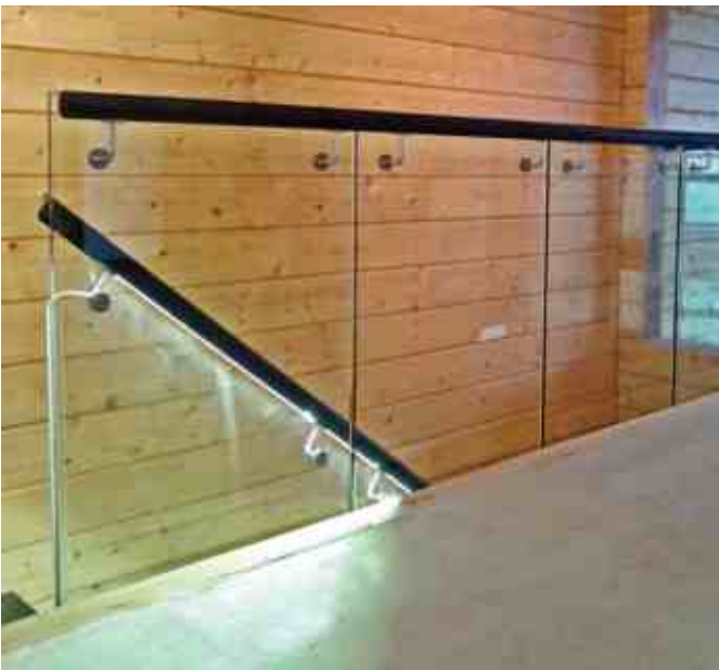
Освещение ступеней лестницы и балкона . LED лента встроена в деревянный поручень.
