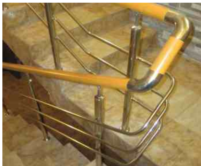
Ограждение с забегом площадки на верхний марш на 900 мм и выбегом нижнего марша на 2 ступени. Завязка круглого пластикового поручня и ригелей на повороте нержавеющей наискосок для компенсации перепада высоты в 2 ступени.
