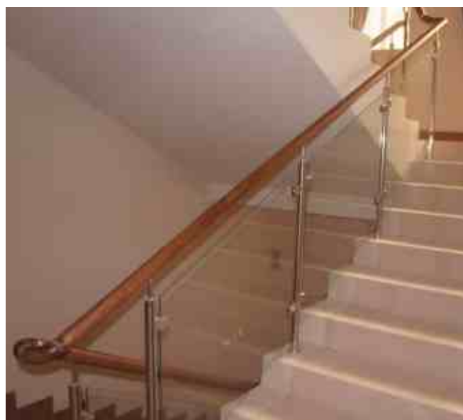
Деревянный поручень цвета вишня завязан деревянными сегментами, с соединением декоративными кольцами. На поворотах нет заполнения ригелями.
