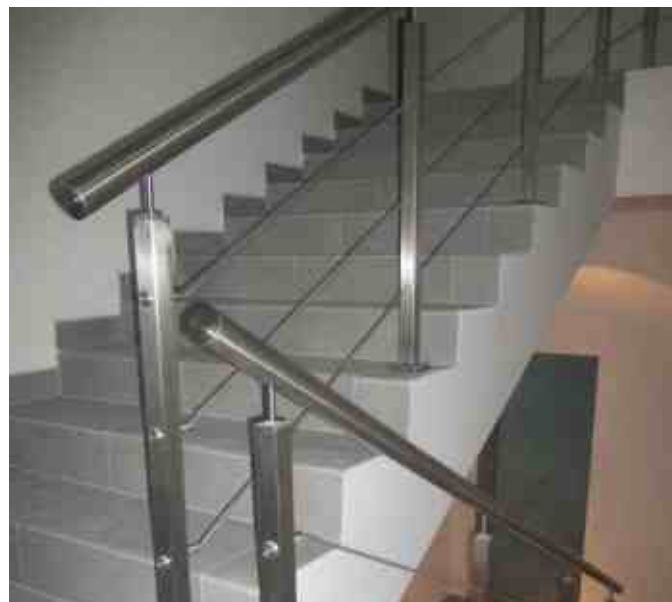
Ограждения из шлифованной нержавеющей стали с тремя тросиками на квадратных стойках 40x40 мм с круглым поручнем 50 мм.
