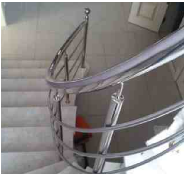
Ограждение забежной лестницы с наконечниками k041. Декоративное окончание ограждений - стойка с наконечником шар.
