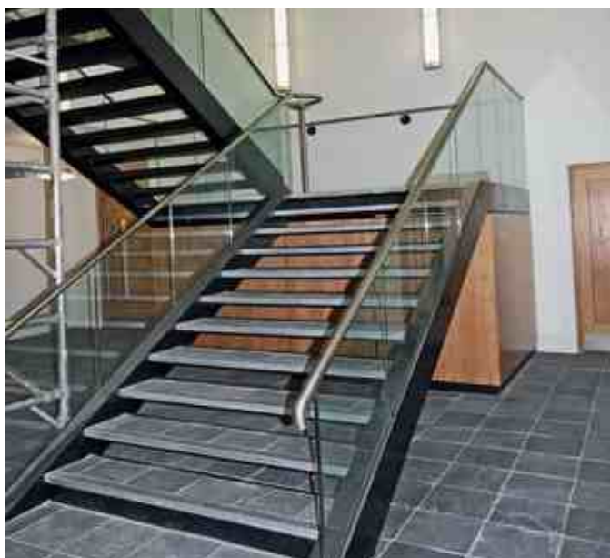
Ограждение без стоек со стеклом триплекс 8+8 мм со скрытым боковым креплением в косоур и круглым шлифованным поручнем с пазом k829, диаметром 48,3 мм
