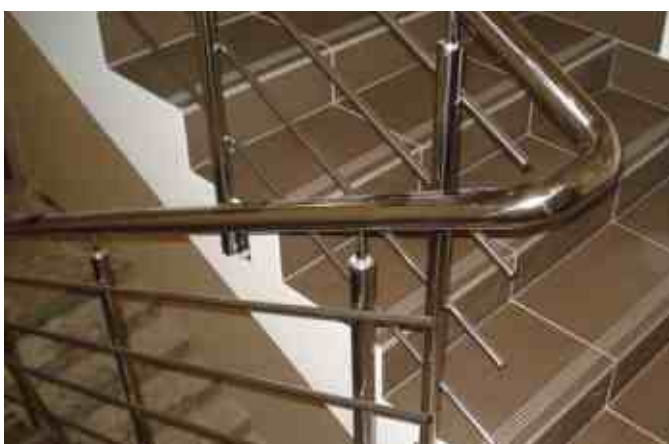
Стандартный марш с поворотом на 180 градусов. Площадка не выбегает и не забегает на марши, завязка горизонтально возможна. На фото боковой крепеж k056, наконечник k041, 4 ригеля не завязаны, поручень завязан между маршами.
