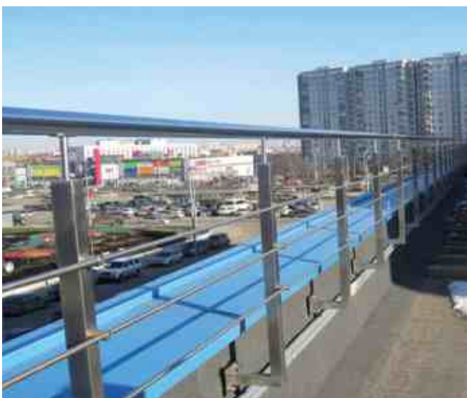
Ограждение кровли торгового центра из шлифованной нержавеющей стали на основе квадратной трубы 40x40 мм и тремя ригелями, закрепленными к стойке через ригеледержатель. Крепеж стойки сбоку в парапет. Наконечник k239.
