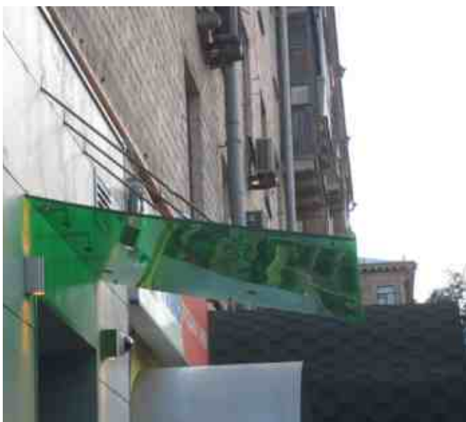
Козырек из триплекса 8+8 с зеленой пленкой между стеклами. На вантах 2 м x 2 м.
