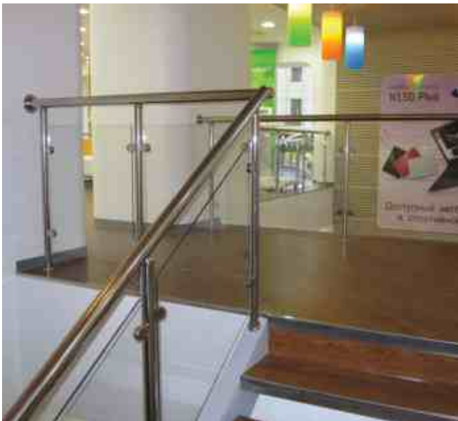
Ограждение в магазине с закаленным стеклом 8 мм и архитектурной пленкой для большей прочности на разбитие с наклонным креплением в парпет. Окончание поручня - фланец арт. k022.
