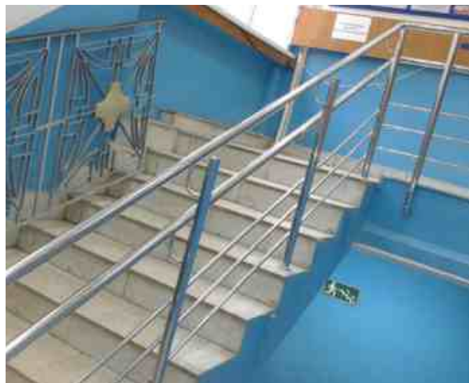
Ограждение в муниципальном учреждении, оборудованное дополнительным поручнем для детей 6-10 лет на высоте 700 мм. Оба поручня выполнены на выносе.
