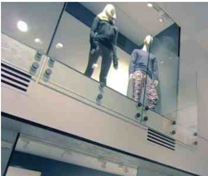
Ограждение, наряду с функцией защиты от падения, не мешает рассматривать витрину с одеждой на втором этаже. Точки бокового крепежа дополнительно окрашены в серый цвет.
