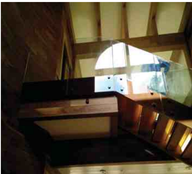
Ограждение без поручня с точечным боковым крепежом в металлический косоур.
