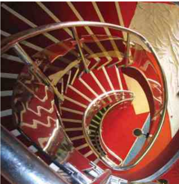
Ограждение с переменным радиусом. Заполнение - поликарбонат, который крепится к стойкам через зажимные стеклодержатели.
