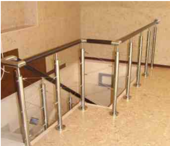
Ограждения из шлифованной нержавеющей стали с круглыми стойками и тросиками, установленными зигзагом. Поручень деревянный завязан на поворотах нержавеющей трубой.
