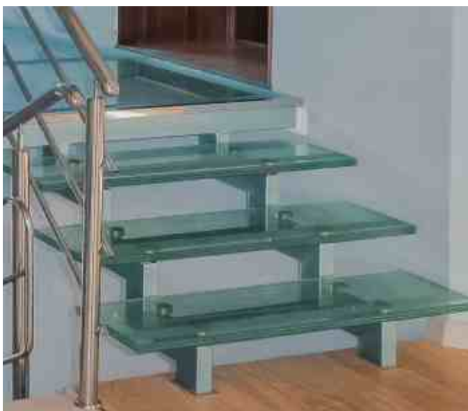
Стекло́нные ступени для выхода на стеклянную площадку. На торце ступеней хорошо видна структура стеклянной панели из трех листов.
