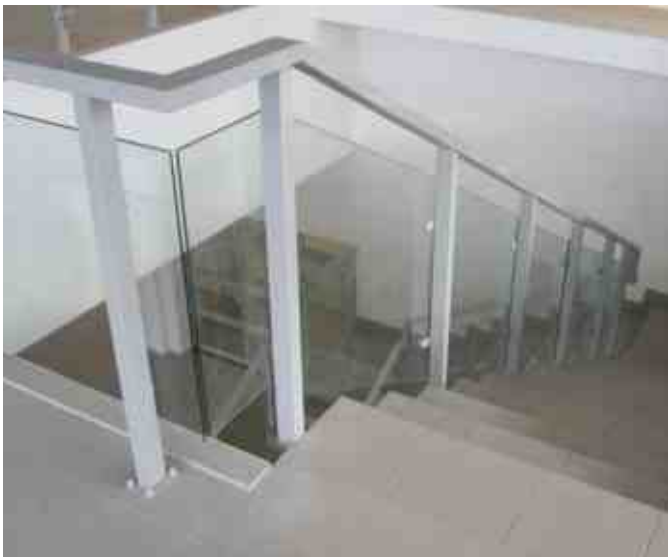
Вариант поворота ограждения со смыканием стеклянных панелей на углу. Стойки и поручень выкрашены в фирменный RAL.
