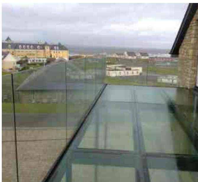
Ограждение балкона без стоек с креплением сбоку в металлический каркас балкона. Без поручня, кромки стекла открыты. Использовано обычное стекло с зеленоватым отливом.
