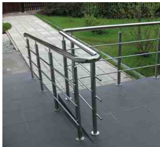
Ограждение парапета и балкона с тремя ригелями, наконечник k034. При повороте на площадку поручень непрерывен, ригель прерывается.
