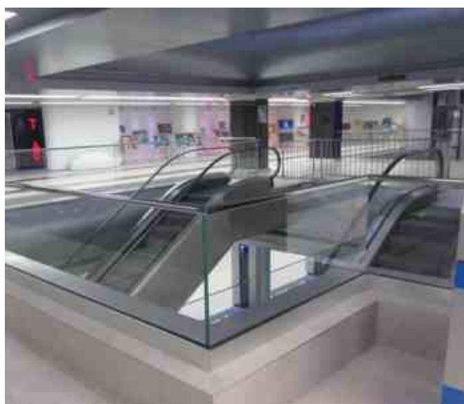
Ограждение торгового центра без стоек с креплением профиля k601 на фальш парапет.
