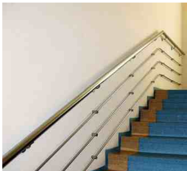
Пристенный поручень в офисе. В декоративных целях ригели дублируют рисунок заполнения основного ограждения лестницы.
