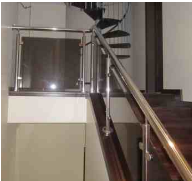
Ограждение со стеклом 8 мм цвет «бронза» с средним заполнением просвета между стойками стеклянным полотном. Наконечник стойки k006, крепление стойки на наклонный паралет с фрезеровкой крышки k201.
