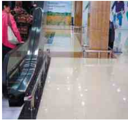
Отбойник защищает отделку эскалатора и колонны.
