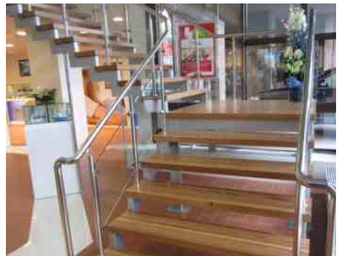
Ограждение со стеклом триплекс 4+4 мм в банке. Стойки через одну ступень. Заполнение стеклом между стойками минимальное по высоте. Приглашающие уходы поручня в пол.
