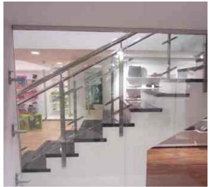
Ограждение из нержавеющей полированной стали с квадратными стойками и боковым крепежом на шпильках и наконечниками k239. Стеклодержатели удлиненные k047. Поручень круглый 50 мм.
