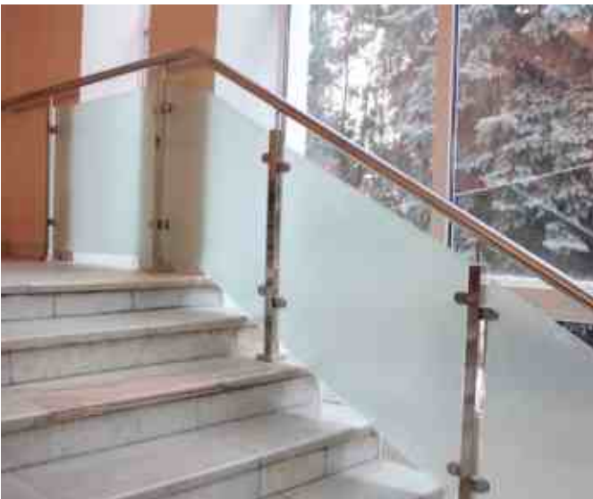
Ограждение вдоль окна с матовым стеклом на квадратных стойках 40x40 мм и зажимными стеклодержателями k001, расположенными на разных уровнях, но на одинаковой высоте от граней стекла, по желанию заказчика.
