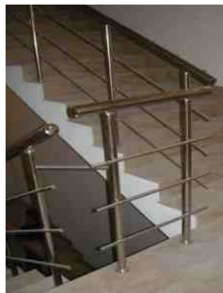
Лестница с большим межмаршевым расстоянием, поручень и ригели развязаны. Для жесткости соседние стойки завязаны одной перемычкой, торцы с заглушками.
