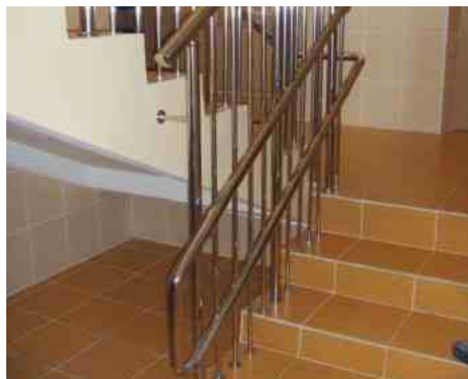
Ригельное ограждение в школе с креплением ригелей вертикально в плитку и дополнительным укреплением стойки в соседний марш. Поручни на высоте 500 мм, 700 мм, 1500 мм.
