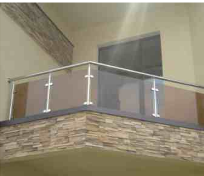
Ограждение балкона на зажимных стеклодержателях со стеклом 8 мм тонированным в массе под цвет "бронза".
