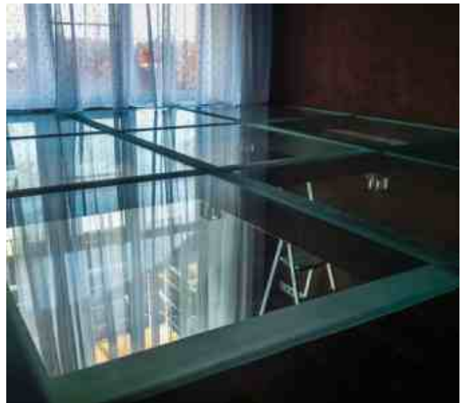
Стекланный пол из осветленного стекла. Когда свет падает снизу вверх такое стекло практически не заметно. Да, ходить страшно :) Но ведь стекланные полы для этого и делают.
