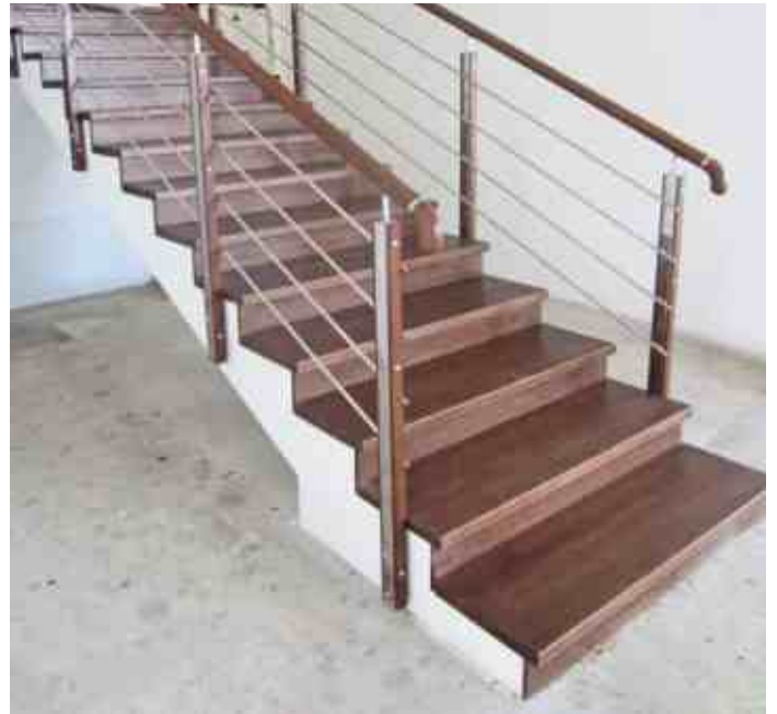
Ограждения в частном доме с ригелями, эксклюзивными стойками и деревянным поручнем с торцевым креплением по обе стороны марша для сохранения полезной ширины лестницы.
