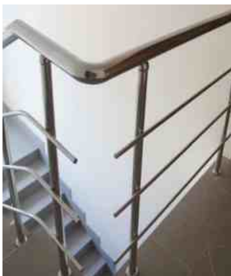
Выход на балкон лестничного марша, с завязкой только поручня, без завязки ригелей.
