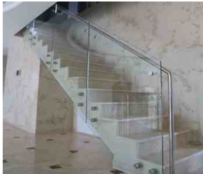
Ограждение без стоек с открытыми кромками и возвратом поручня на марш на выносах относительно стекла. Уход поручня в пол дополнительно укрепляет конструкцию.
