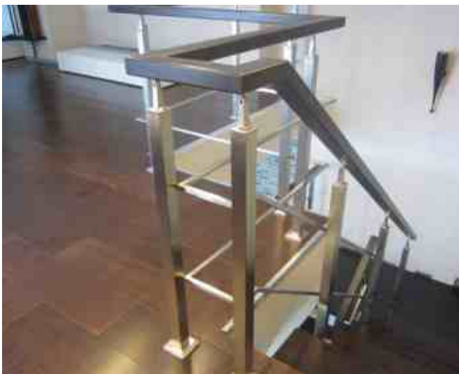
Ограждение на квадратных стойках с наконечником k222, с двумя квадратными ригелями с наружным креплением, с деревянным крашенным поручнем 60x40 мм.
