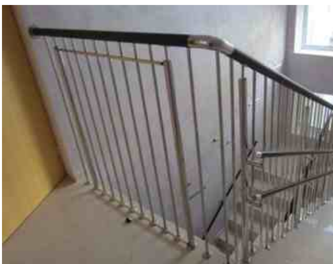
Ригельное ограждение элитного детского сада высотой 1500 мм с тремя круглыми деревянными поручнями, крашеными под венге и завязанными нержавеющими отводами. Поручни установлены на выносах k243.
