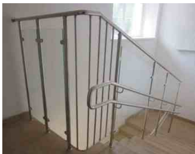
Ограждение средней школы высотой 1500 мм с безопасным стеклом триплекс 4+4 мм и двумя поручнями д.38 мм на выносах от стойки на высоте 900 и 700 мм. Наконечник k016, стеклодержатели k001, крепление сверху в ступень с маленькой крышкой k015. Поручень завязан травмобезопасно отводом k051.
