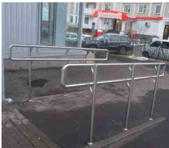
Ограждения пандуса эконом вариант: отсутствует выход поручней в горизонт на 300 мм в начале и в конце пандуса, а также нет нижнего ограничителя. Монтаж стоек осуществлен в асфальт.
