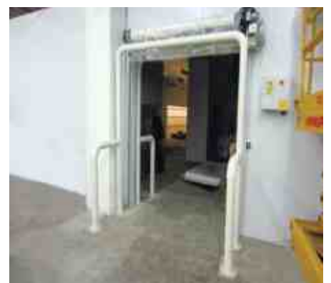
Защита проема механизма рольставен и проема ворот от погрузчика.
