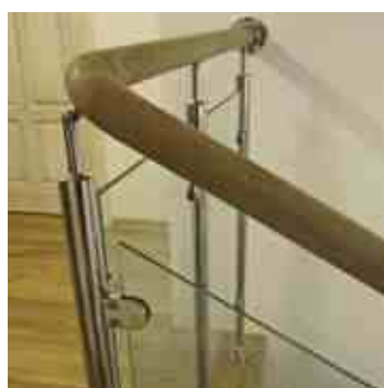
Завязка деревянным сегментом без соединительных колец.
