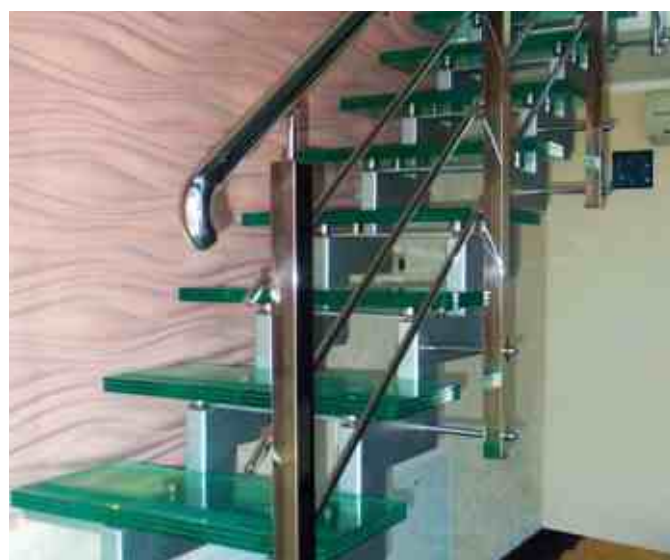
Лестница на двух косоурах из черного металла. Ступени из триплекса 10+10+10 мм.
