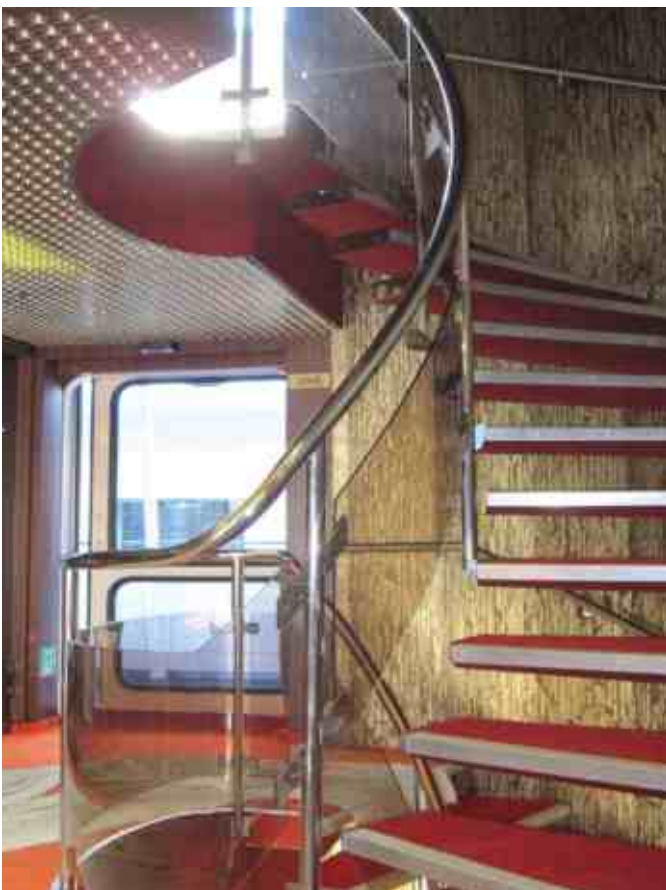
Ограждение на теплоходе с заполнением между стоек монолитным поликарбонатом в пластинчатых стеклодержателях.
