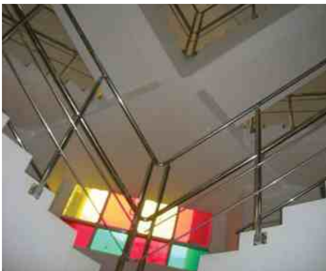
Ограждение колодезной лестницы с боковым крепежом, с двумя ригелями д.16 мм, одним поручнем д. 38 мм на высоте 950 мм на выносе и вторым поручнем д.38 мм на высоте 1200мм.
