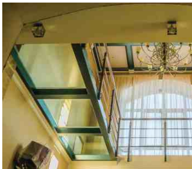
Снизу стеклянного пола проходит массивная подконструкция. При кажущейся хрупкости стеклянные полы очень мощные. Обычно их проектируют с расчетом на нагрузки от 500 кг/кв.м. и выше.
