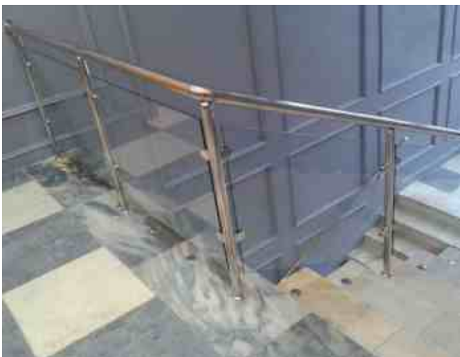
Реконструкция ВУЗа: демонтированы стойки в каждую ступень, старые отверстия закрыты заглушками. Одна стойка на углу с наконечником сферы.
