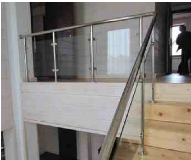
Ограждения в частном доме с прозрачным закаленным стеклом 8 мм. Крепление сверху в деревянную ступень на 3х анкерную закладную.
