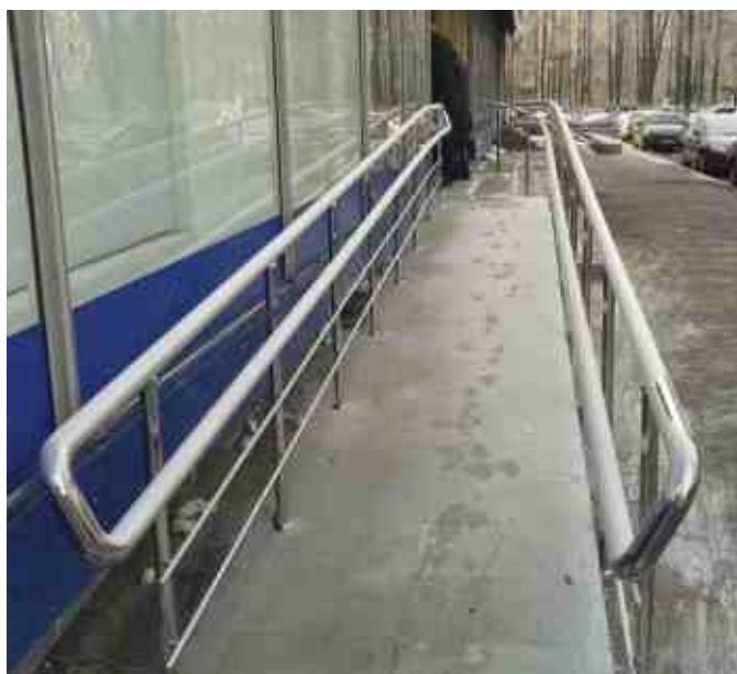
Перила на прямом пандусе при входе в магазин. Верхний поручень установлен сверху стойки на высоте 900 мм, нижний - на выносе относительно стойки на высоте 700 мм.
