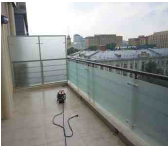
Рядом с существующим ограждением установлено дублирующее ограждение с панелями из стекла, чтобы дети могли безопасно играть на балконе и не могли перелезть через перила. Крепеж стекла скрытый. Архитектурная пленка 216 мкм по антивандальному стандарту А2.
