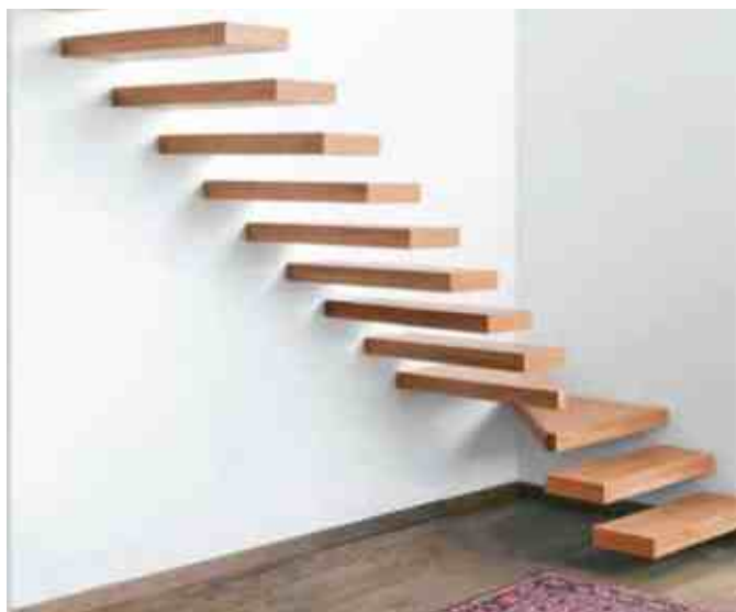
Консольная лестница без ограждений, металлокаркас обшит деревянными панелями.
