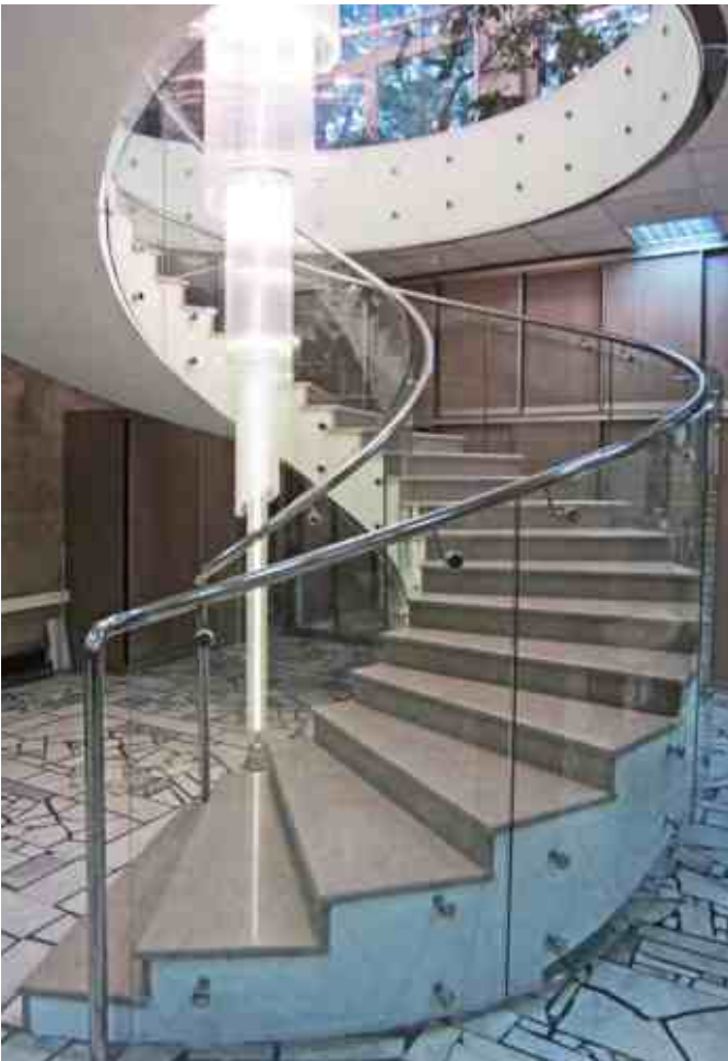
Ограждение в отделении банка, без стоек с боковым крепежом и выносами поручня внутрь марша. Для жесткости окончание поручня уходит в пол. Стекло 12 мм гнутое по радиусу, выносы k241, точечные крепежи k277.
