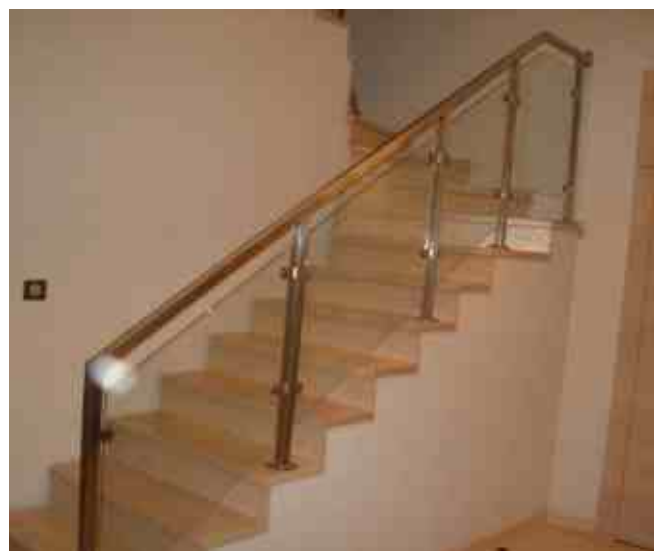
Ограждение из профиля 40x40 мм, с круглыми зажимными стеклодержателями k001. Окончание поручня в стену закрыто крышкой k076.
