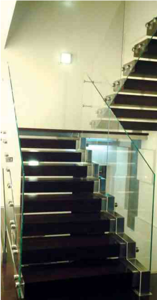
Ограждение без поручня со стеклом 12 мм, с боковым крепежом к277. Перемычки между маршами придают дополнительную жесткость.
