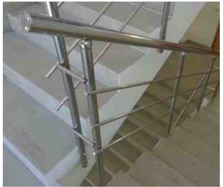
Стандартное 3-х ригельное ограждение с торцевым креплением через шпильку вплотную к лестничному маршу. Поручень и ригель прерывается.
