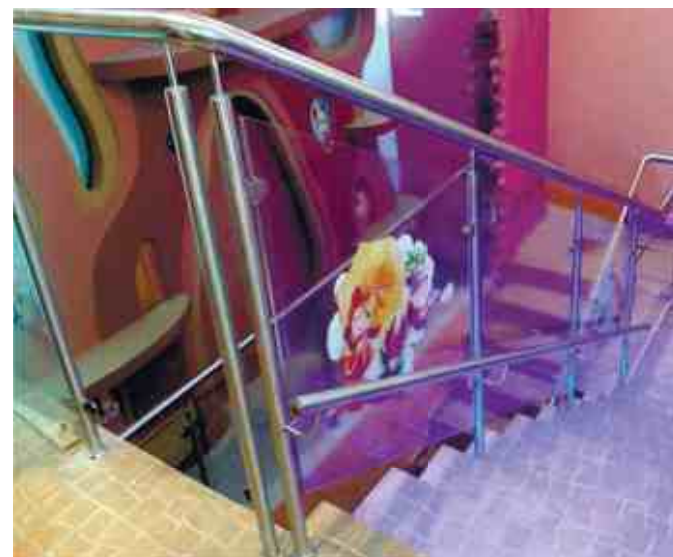
Ограждение для коммерческого детского центра высотой 1200 мм с безопасным стеклом триплекс 4+4 мм и поручнем д. 38 мм на выносах от стойки на высоте 500 мм. Наконечник k006, стеклодержатели k001, крепление сверху в ступень с маленькой крышкой k015.
