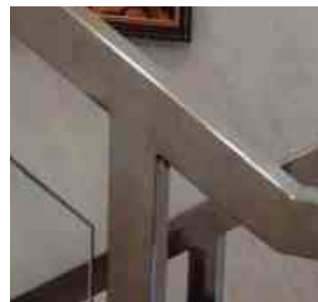
Наконечник отсутствует - стойка сваривается в поручень и полируется.
