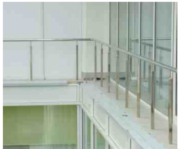
Техническое ограждение атриума вдоль стеклянных перегородок, примыкающих к атриуму. Клининг теперь не боится мыть стекла.
