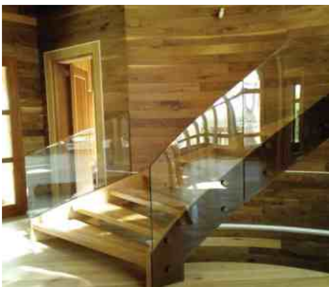
Ограждение без стоек с гнутым стеклом 12 мм с креплением на точках в псевдодеревянный косоур без поручня.
