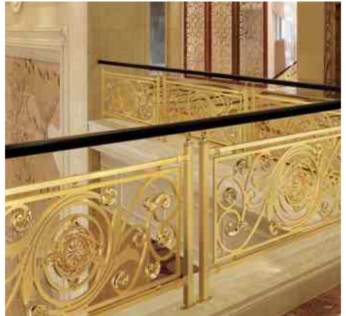
Литые секции из полированной латуни на лестнице в загородном доме.
