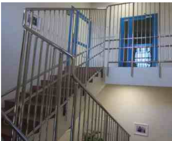
Ограждение с ригелями в детском саду для детей с отставанием в развитии. Выполнено с тремя поручнями д.38 мм на высоте 500 мм, 700 мм и 1500 мм по ГОСТу. Поручни завязаны между маршей. Из за бокового крепежа и колодцевого типа лестницы, при повороте на 90 градусов образуется выход на вертикаль высотой в 1 высоту ступени.
