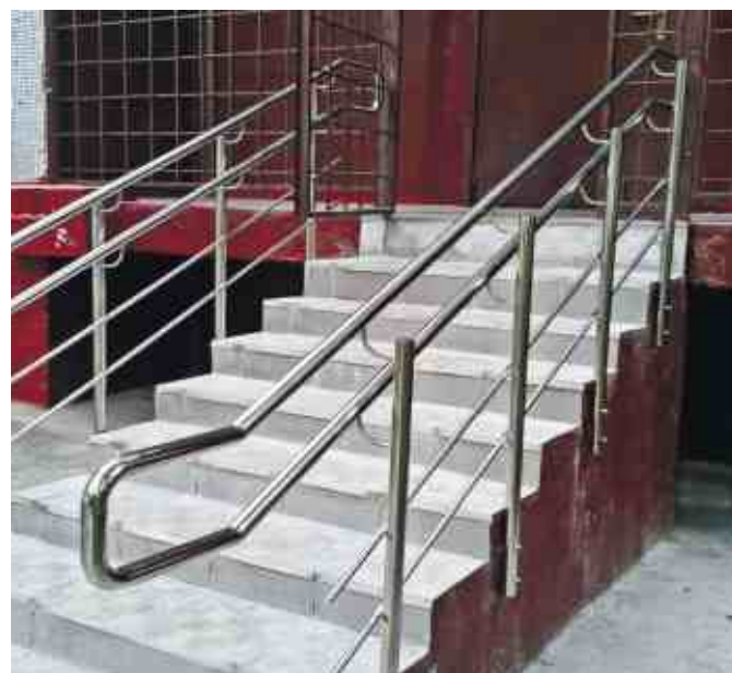
Ограждение лестницы с торцевым креплением для сохранения максимальной полезной ширины лестничного марша. Дополнительный поручень на высоте 700 мм.
