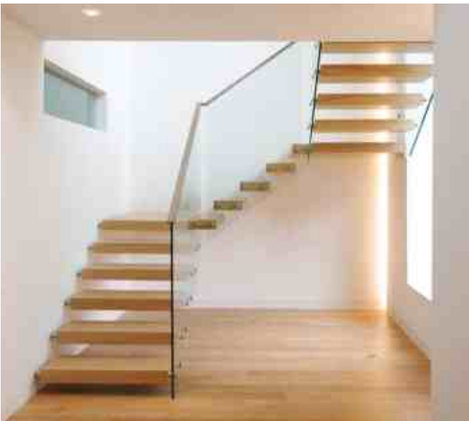
Красивая консольная лестница с ограждением без стоек и торцевым креплением. Подсветка эркера лестницы с помощью светильников, встроенных в угол лестницы.
