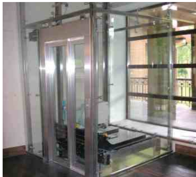
Облицовка портала нержавеющейкой. Облицовка шахты стеклом.
