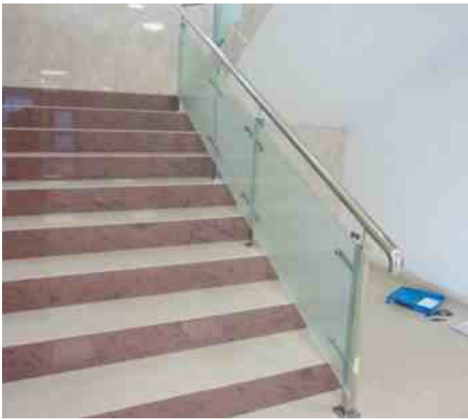
Ограждение на стойках 40x40 мм со стеклом матовым в массе, стеклодержатель k047 пластинчатый, окончание поручня k067.
