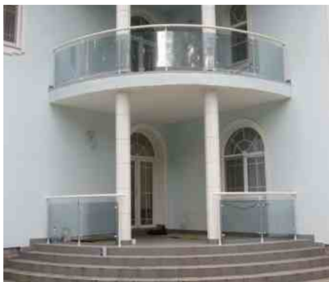
Ограждение балкона на круглых стойках со спайдерными стеклодержателями. Стекло 8 мм гнутое по радиусу тонировано серо-голубой пленкой в цвет фасада.
