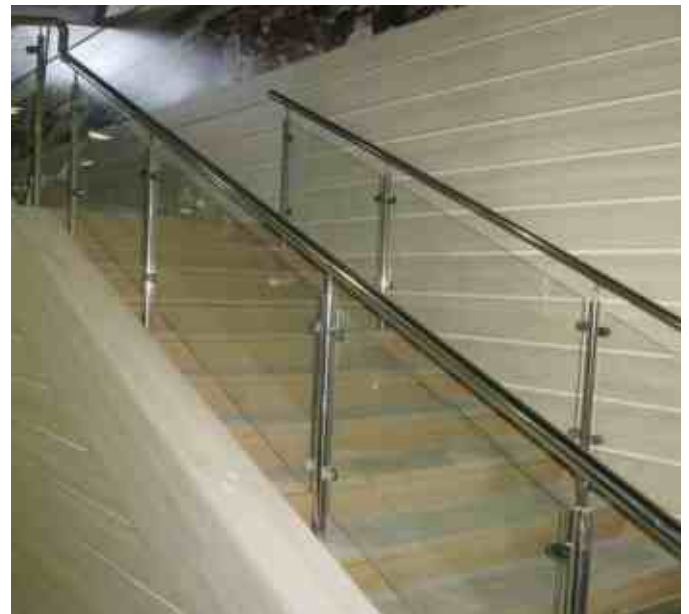
Экономичное ограждение со стеклом. Крепление стоек через три ступени на четвертую. Заполнение между стойками максимальной площади.
