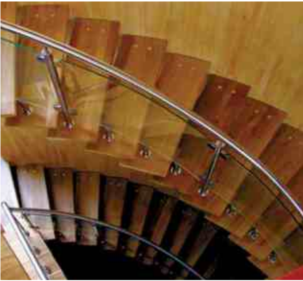
Ограждение забежной лестницы с прямым крепежом, через три ступени на четвертую. Для образования фермы стекло дополнительно связано с каждой ступенью.
