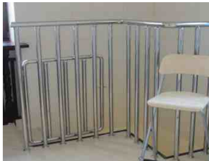
Ограждение детского этажа в коттедже. Оборудовано вертикальным заполнением - стойками д.38 мм и калиткой по чертежам заказчика.
