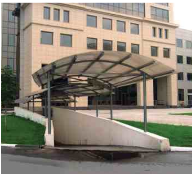
Навес над въездом на парковку бизнес центра из черного металла и сотового поликарбоната.
