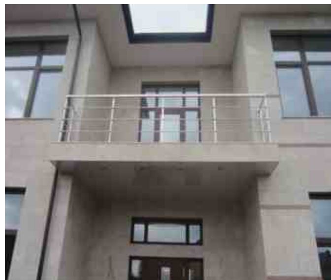
Ограждение балкона на квадратных стойках 40x40 мм с 4 ригелями диаметром 16 мм, приваренными внахлест снаружи балкона, квадратный поручень 40x40 мм. Наконечник K239.
