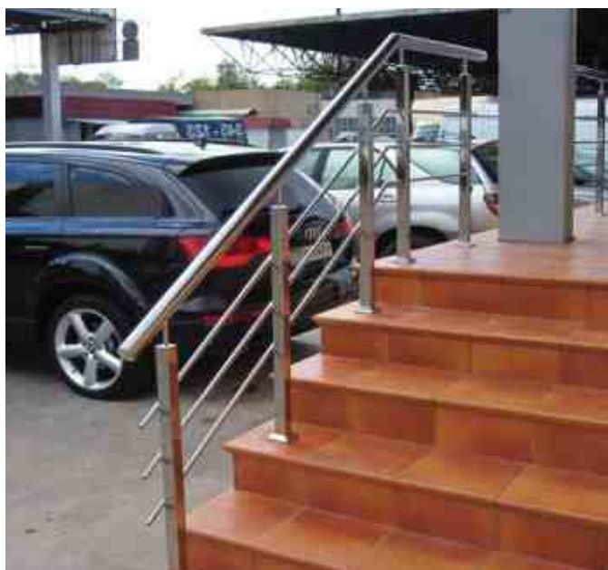
Входная группа с выходом на балкон первого этажа. Стойки 40x40 мм с креплением 3-х ригелей. При выходе на площадку поручень и ригель непрерывны.
