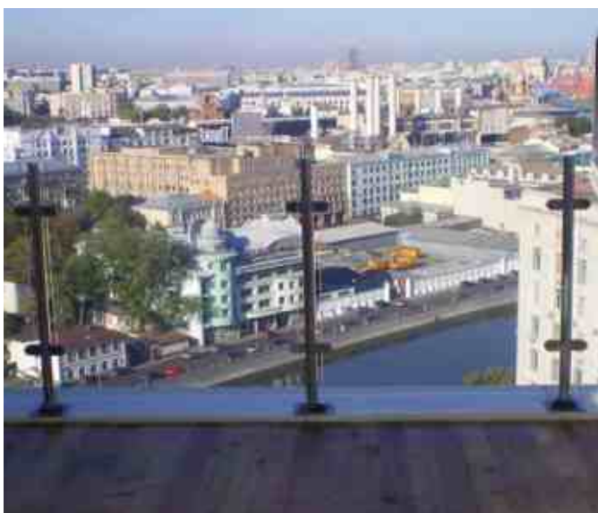
Экономичный вариант ограждения в ресторане на обслуживаемой кровле. Высота ограждения 900 мм, без поручня. Стойки круглые д.42 мм. Осветленное стекло установлено на зажимных стеклодержателях.
