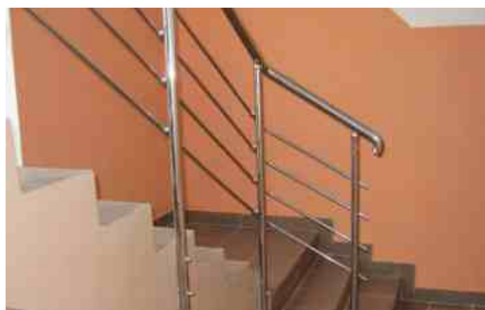
Высота на первом марше не одинакова с высотой на втором марше. Если марш короткий, это не будет заметно. С каждым маршем вверх, если не делать выход поручня на вертикаль, высота ограждения каждый раз будет на 1 высоту ступени ниже.
