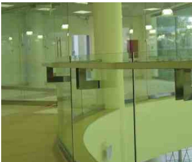
Ограждение атриума с использованием триплекса 8+8 мм, в алюминиевом профиле к601 и с поручнем 40 мм x 80 мм на выносах. Такой поручень можно использовать как полочку для сумочки или подставку под кофе.
