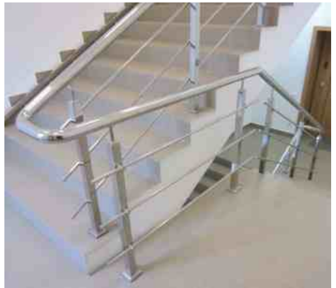
Ограждение лестницы на квадратных стойках 40x40 мм, с тремя ригелями диаметром 16 мм, на ригеледержателях, без завязки на поворотах. Поручень круглый, завязан между маршей, выходит на горизонт на всю длину выбега площадки.
