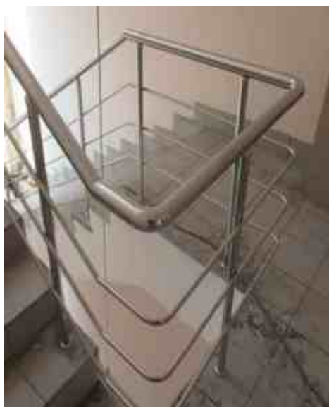
Ограждение лестницы с широким межмаршевым расстоянием. В связи с ограниченным бюджетом вставлена только одна дополнительная стойка.
