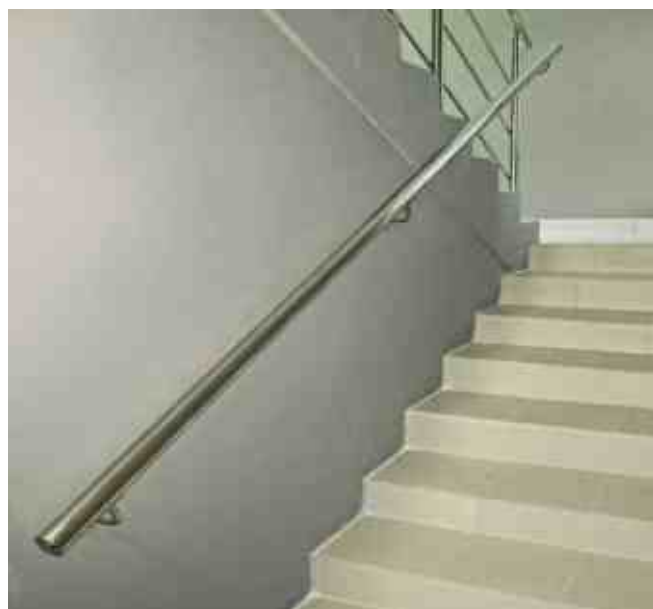
Бюджетный вариант выполнения спуска в подвал. Пристенок не завязан с основным ограждением марша. Для жесткости установлен с одной стороны на крайнюю стойку лестничного ограждения.
