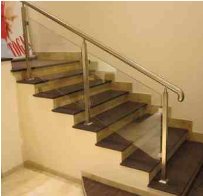
Ограждения лестницы на квадратных стойках 40x40 мм из шлифованной нержавеющей стали, с наконечником k203. Поручень заканчивается отводом оконечным k020.
