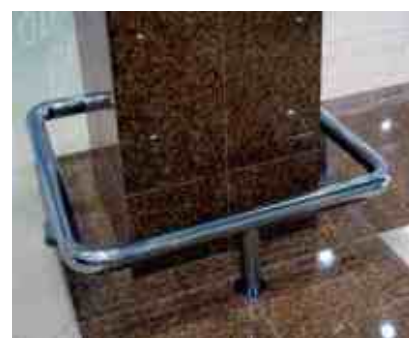
Колесоотбойники вокруг квадратной колонны, все завязано.
