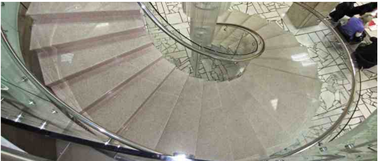
Ограждение забежной лестницы со стеклом 12 мм, гнутым по радиусу в двух плоскостях.
