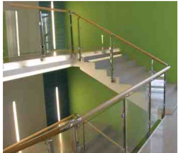
Ограждение с деревянным поручнем в офисе с небольшой проходимостью создает домашнюю уютную обстановку.
