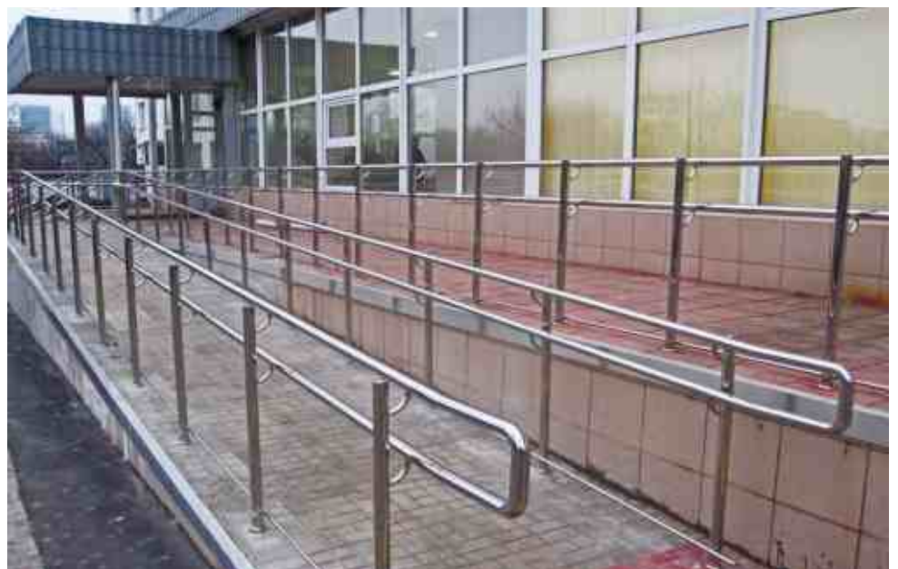
вариант исполнения ограждения 2 поручни на высоте 9 мм с верху на столбе поручень 7 мм на выносе относительно столба.
