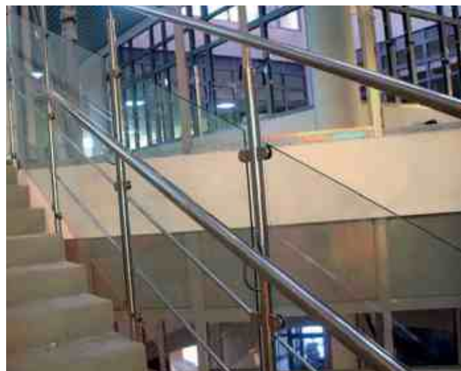
Ограждение для муниципальной школы с безопасным стеклом триплекс 4+4 мм и одним поручнем д.38 мм на выносе от стойки на высоте 900 мм. Крепление стоек сбоку от марша. Наконечник k006, стеклодержатели k038.
