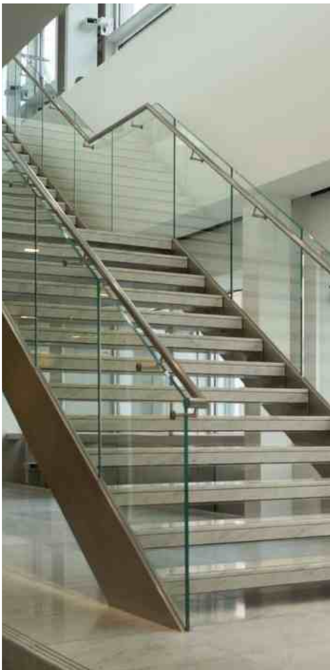
Ограждение без стоек с поручнем на выносе k241, с креплением в металлический косоур минимальной толщины.
