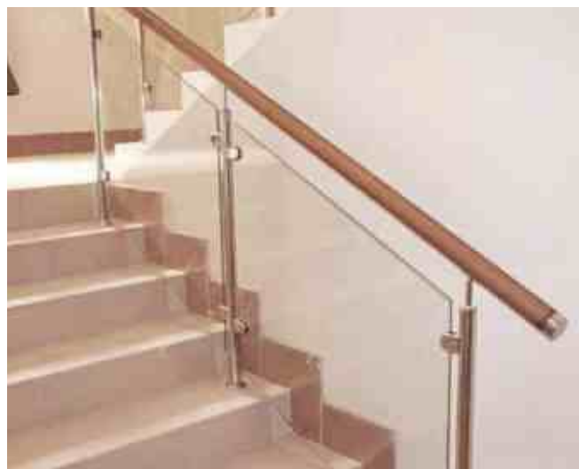
Деревянный поручень цвета «ольха», наконечник стойки k006, поворот без заполнения.
