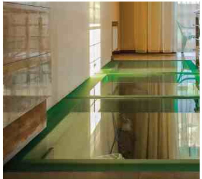
Стекланный пол в частном доме, триплекс 10+10+10 мм обычное, не осветленное стекло, с зеленоватым отливом.
