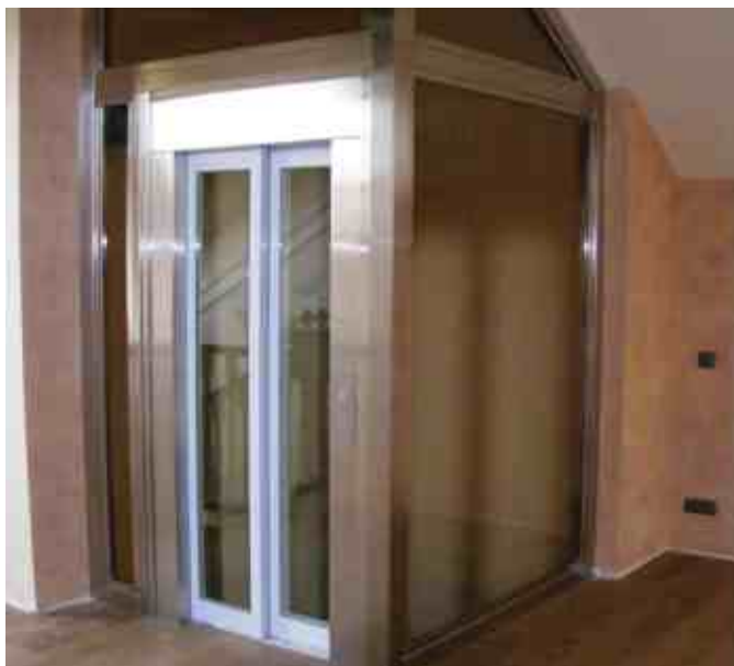
Облицовка портала нержавеющейкой и стеклом.
