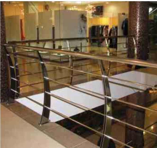
Ограждение атриума с четырьмя ригелями на стойках из полированной нержавеющей стали. Стойки изогнуты полукругом затрудняя детям использовать ограждение как лестницу.
