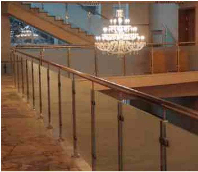
Ограждения балкона на квадратных стойках 40x40 мм. Наконечник стойки k239, крышка k076. Стекло матовое 8 мм, шаг стоек 1 метр, поручень 50 мм.
