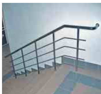
Окончание поручня в стену для жесткости.
