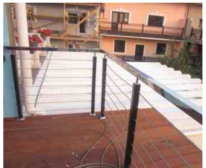
Ограждения балкона из полированной нержавеющей стали с 8 тросиками в морском стиле, стойки покрашены в RAL.
