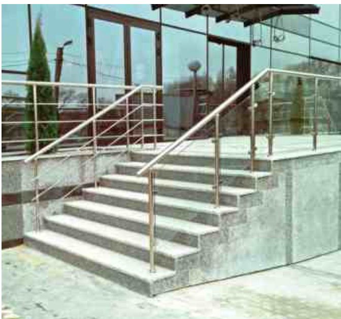
Ограждение входной группы комбинированное: с внешней стороны со стеклом на стойках, с ригелями ближе к фасаду.
