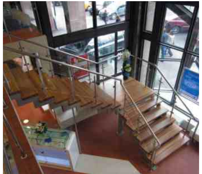
Ограждение колодезной лестницы в салоне связи. Осветленное стекло не мешает работать свету сквозь панорамное остекление витрины центрального офиса МТС на Арбате.
