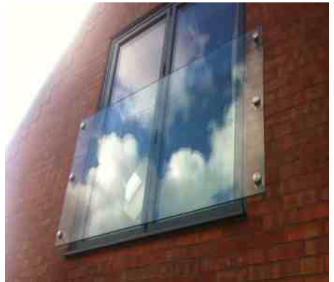
Ограждение французского балкона с креплением сбоку на точечных держателях. Без поручня, кромки стекла открыты.
