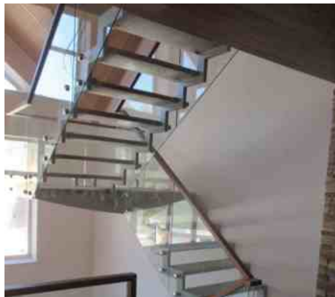
Лестница на двух металлических косоурах и площадка с опорой на стену. Ступени дуб 40 мм. Ограждение без стоек на точечных крепежах k277. Поручень дуб 40 x 80 мм с пазом завязан повторяя грани стекла.
