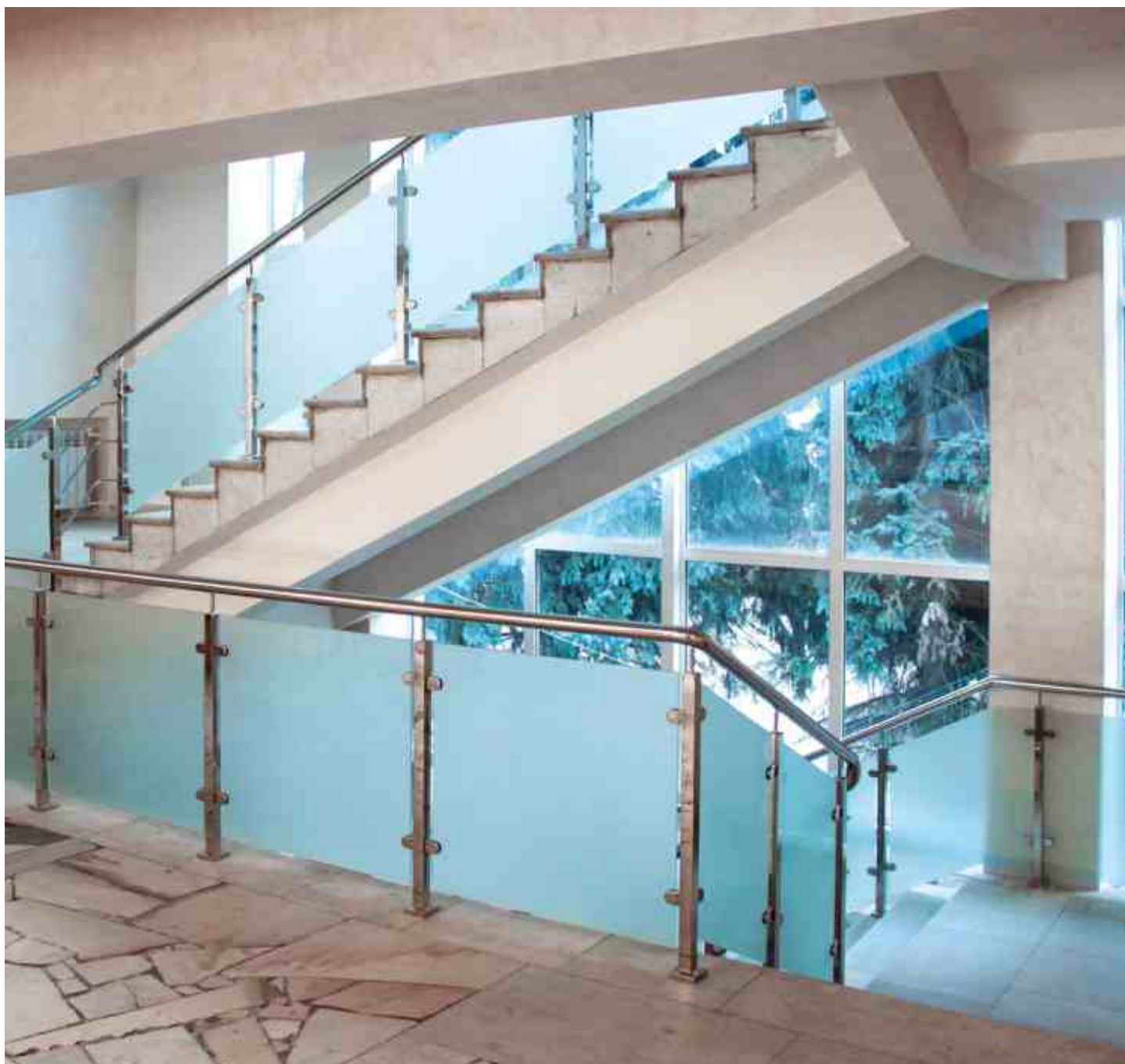
Ограждение колодцевой лестницы из полированной нержавеющей стали на квадратных стойках 40x40 мм с наконечниками k239, крышками k076, штампованными стеклодержателями k039, со стеклом триплекс 4+4 мм с матовой пленкой. Поручень 50 мм завязан на повороте одной стойкой. На следующем марше поручень завязан «с подскоком». Просвет закрыт тремя ригелями д. 16 мм.
