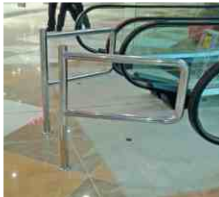
Потокоразделитель перед эскалатором.
