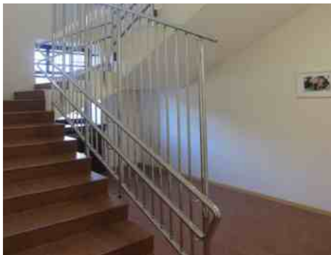
Ограждение с ригелями в психоневрологическом детском центре. Выполнено с тремя поручнями д.38 мм на высоте 500, 700 и 1800 мм по ГОСТу. Поручни завязаны между маршей, на конце каждого поручня закольцовка. Из-за колодцевой лестницы при повороте на 90 градусов образуется выход на вертикаль.
