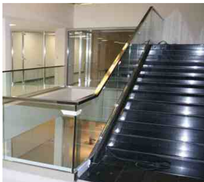
Ограждение без стоек со стеклом триплекс 8+8 мм с креплением в алюминиевый профиль сверху в перекрытие и облицованный полированной нержавеющейкой.
