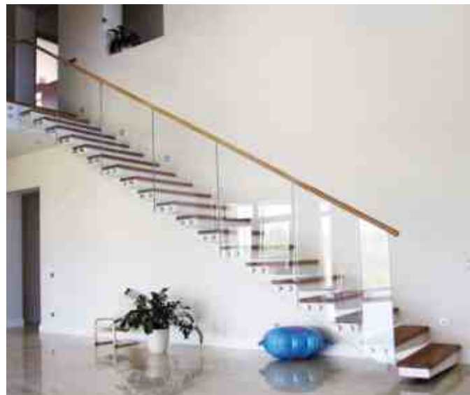
Консольная лестница и ограждение без стоек - классическое сочетание. Комбинация глянцевых боковых креплений и деревянного поручня с глянцевым лаком и осветленным стеклом 12 мм.
