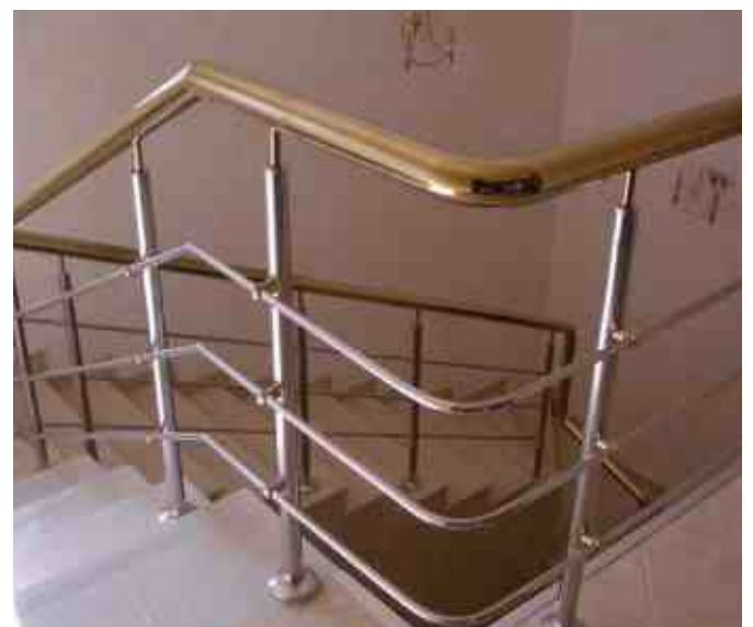
Обычное ограждение с тремя ригелями и поручнем из латуни. На поворотах поручень спаян по уникальной технологии.
