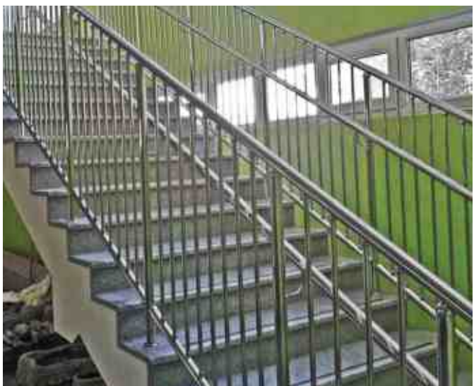
Ограждение в старшей школе. Выполнено с двумя поручнями д.38 мм на высоте 900 мм и 1200 мм. Вертикальные ригеля опираются на нижнюю балку д.38 мм с помощью деталей k212.
