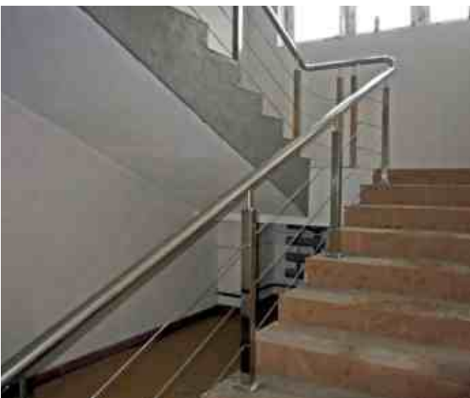
Ограждения из полированной стали с квадратными стойками 40x40 мм и завязкой на поворотах тремя тросами.
