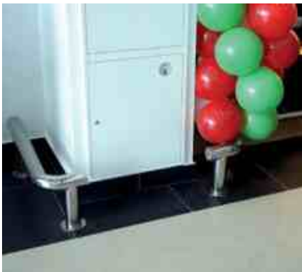
Отбойник защищает от ударов телег защищает пожарный шкаф.
