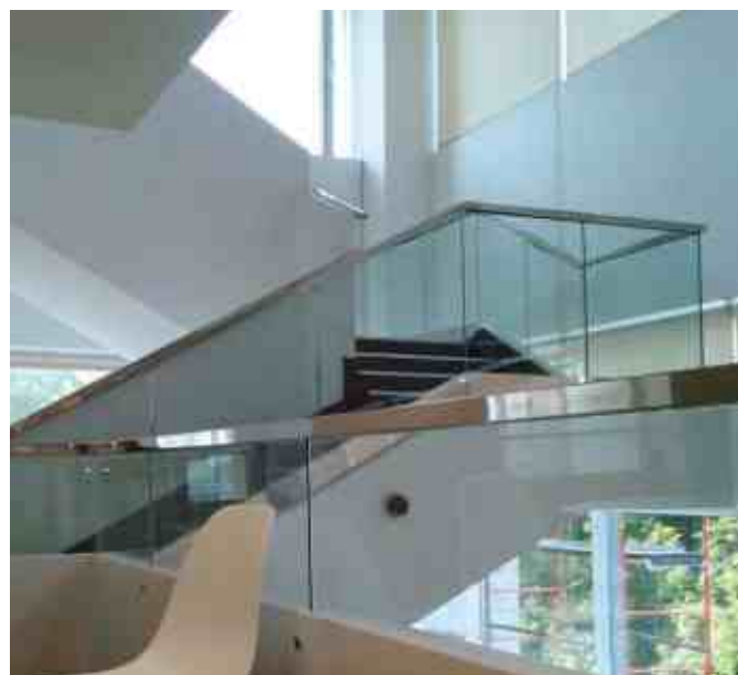
Ограждение без стоек с закаленным стеклом 15 мм и прямоугольным полированным поручнем с пазом k824, размером 40x60 мм.
