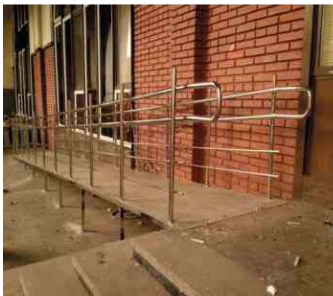
Каркас пандуса из нержавеющей трубы профильного сечения, покрытие нержавеющей текстурированный лист, стойки ограждения приварены к каркасу.
