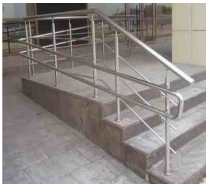
Комбинированное ограждение входной группы и пандуса. Стойки входной группы служат также опорами для двойного поручня перил пандуса.
