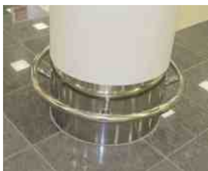
Колесоотбойник вокруг колонны (защищает облицовку от тележек).
