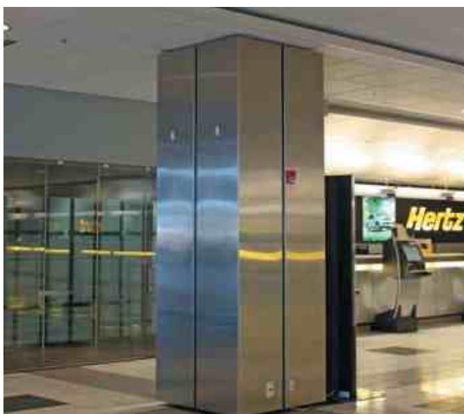
Облицовка колонны шлифованной нержавеющейкой.
