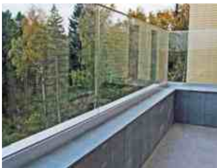
Ограждения балконов и кровли 62
