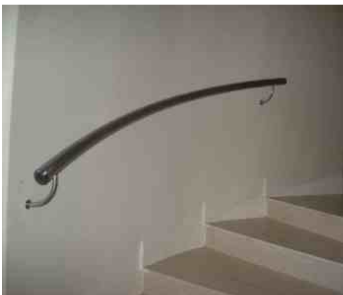
Пристенный поручень прокатанный по радиусу, дублирует изгиб стены.
