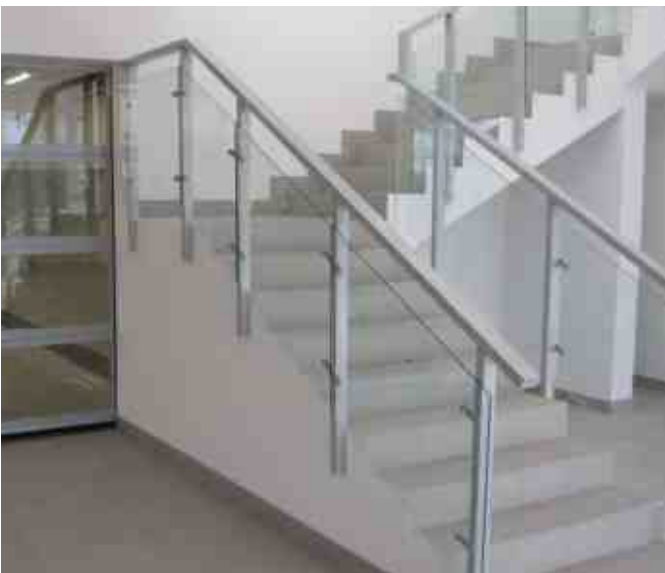
Ограждение из черного металла с боковым крепежом на пластинчатых стеклодержателях и с поручнем 30x60 мм, покрашенным в серый цвет. Стекло соединяется за стойками.
