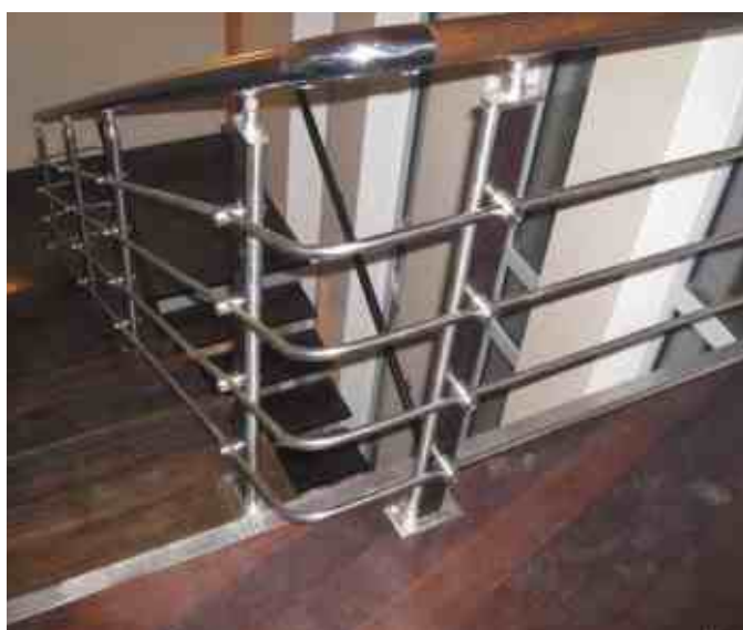
Стойки с деревянной вставкой “махагон” с четырьмя ригелями и завязками на поворотах. Поручень деревянный завязан на повороте нержавеющей.
