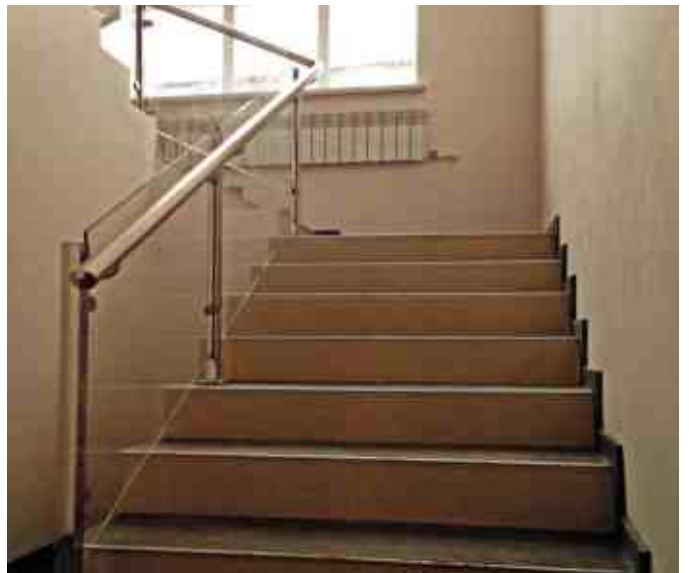
Ограждение со стеклом на зажимных стеклодержателях с поручнем на выносе и открытыми кромками стекла.
