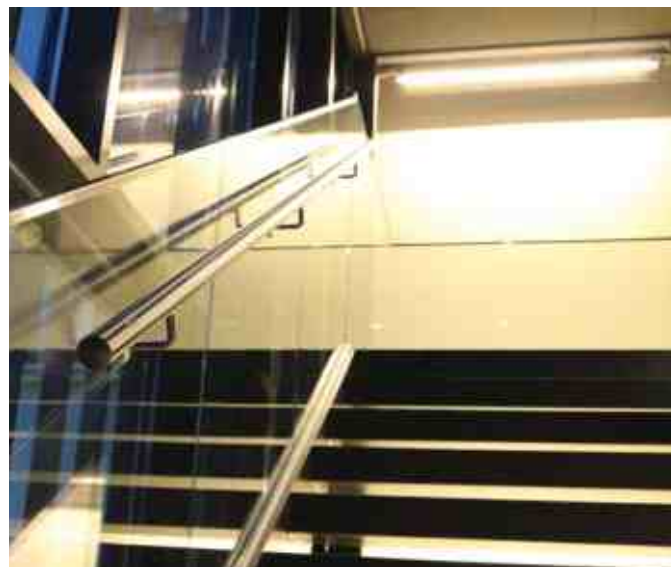
Ограждение без стоек с поручнем на выносе k008 с защитой кромок от разбития П-профилем.
