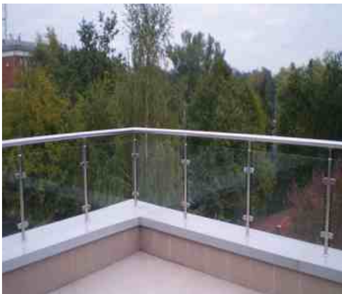
Ограждение балкона на зажимных стеклодержателях с осветленным стеклом и поручнем 50 мм. В углу одна стойка (обычно ставятся 2 стойки).
