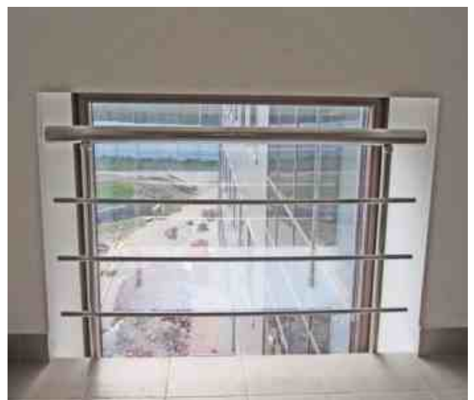
Трехригельное ограждение с креплением сбоку в площадку. Выполнено за плоскостью площадки из-за требований пожарной безопасности к ширине прохода.
