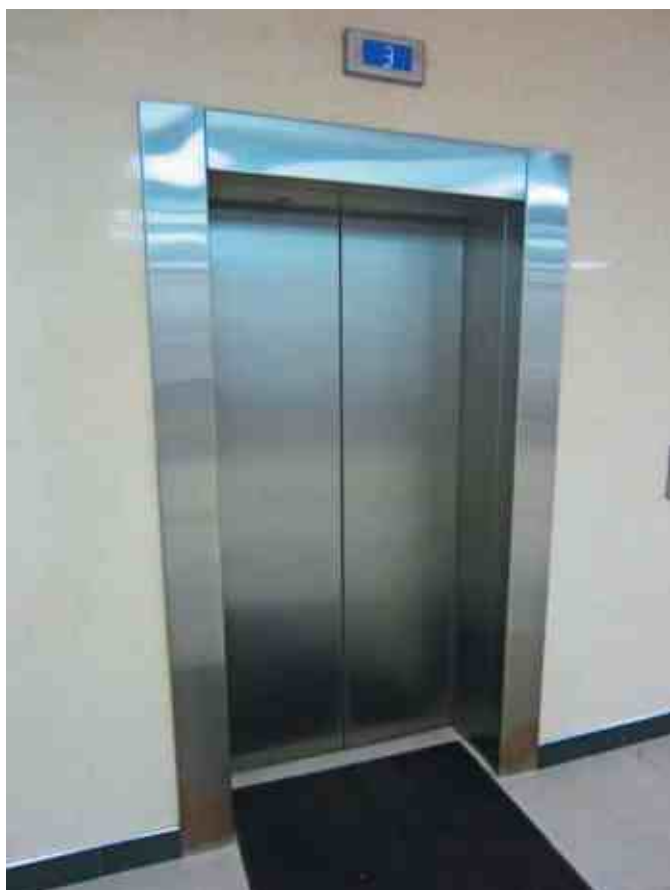
Облицовка лифта шлифованной нержавеющей сталью 1,5 мм с подконструкцией.
