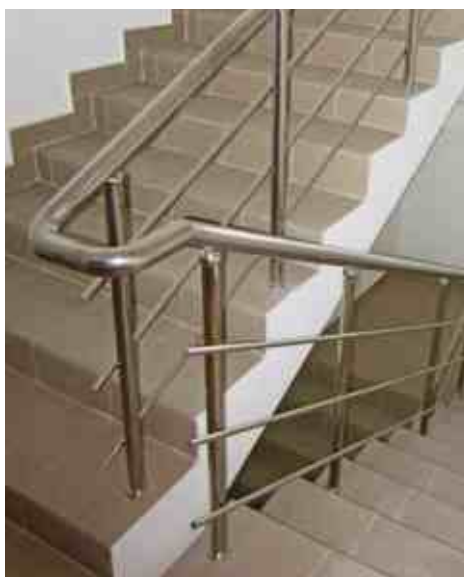
Ограждение лестницы с выбегающей ступенью, из-за этого поручень выходит в горизонт на длину выбега ступени.
