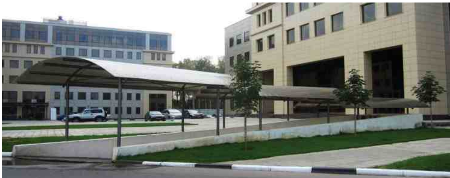
Недорогие навесы из черного металла, накрытые сотовым поликарбонатом цвета бронза.
