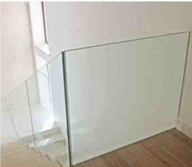
Минималистическое ограждение без стоек со стеклом 12 мм. Идеально подогнанные плоскости, открытые кромки, скрытый крепеж. Эко стиль в частном доме.
