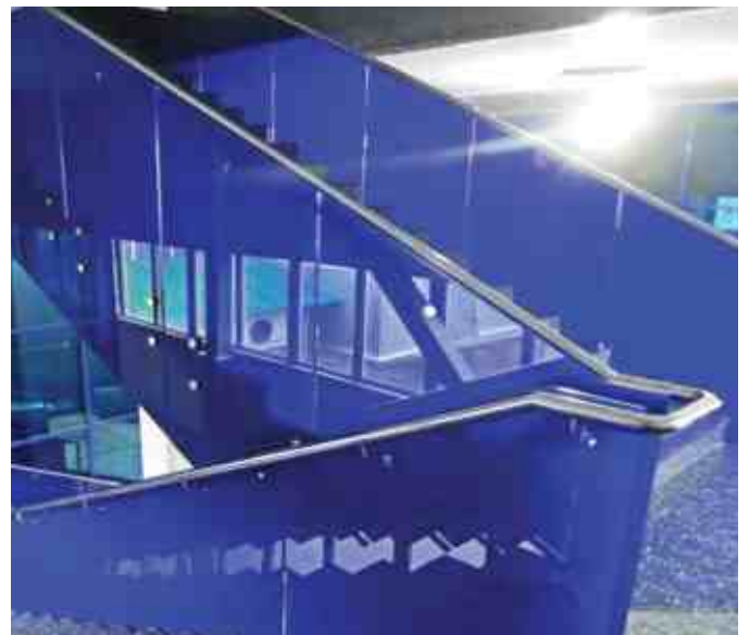
Ограждение в фирменном стиле из тонированного в массе синего стекла с нержавеющей полированным поручнем на выносах.
