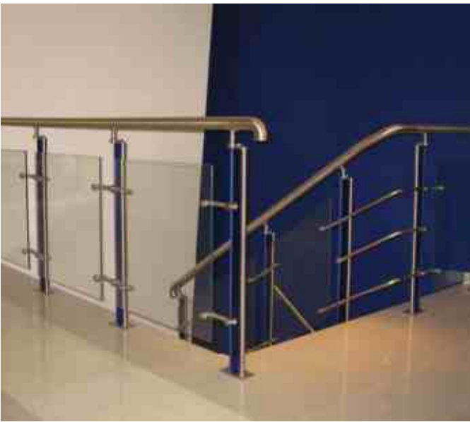
Ограждение со стойками с акриловыми вставками на спайдерных стеклодержателях в темно синем стиле дизайна банка. На поворотах красиво завязан тремя ригелями. Поручень шлифованный на микровыносах.
