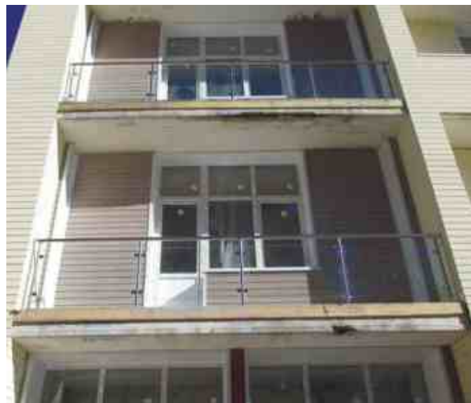
Ограждение балкона жилого дома со стеклом триплекс 4+4 мм. Стекло может крепиться в стену без стоек, но красивее устанавливать стойку вплотную к стене как на этом проекте.
