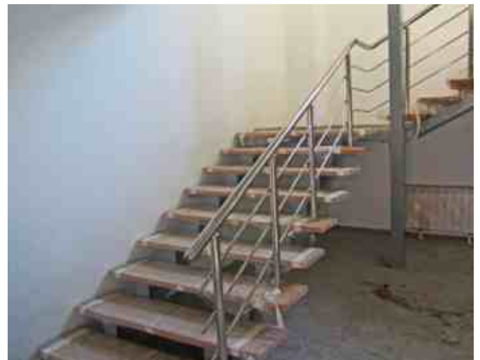
Дешевый вариант ограждения для колодезной лестницы. Ступени укрыты до начала монтажа пленкой. Наконечник полусфера, 3 ригеля завязаны на повороте.
