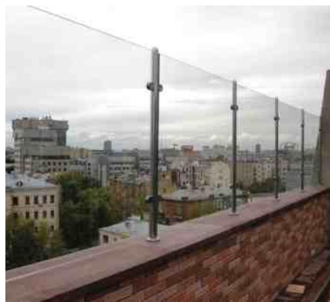
Ветрозащитное ограждение балкона с креплением сверху в парпетную крышку. Стойки круглые д.42 мм. Стеклодержатели литые k001. Гидроизоляция произведена специалистами компании.
