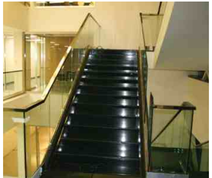
Ограждение в гостинице с полированным прямоугольным поручнем с пазом 40x60 и накладками из полированной нержавеющей стали внизу профиля.
