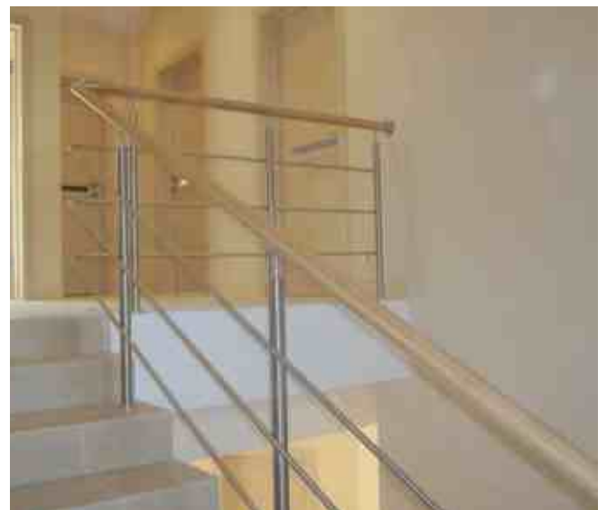
Ограждение из шлифованной нержавеющей стали с тремя ригелями и деревянным поручнем цвета натур, с окончанием в стену через фланец с открытым крепежом k022.
