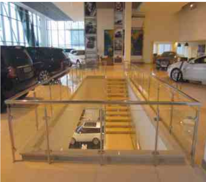
Ограждение экранного типа в автосалоне. Через стеклянные экраны стекла видны машины на первом этаже. Недорого и практично.
