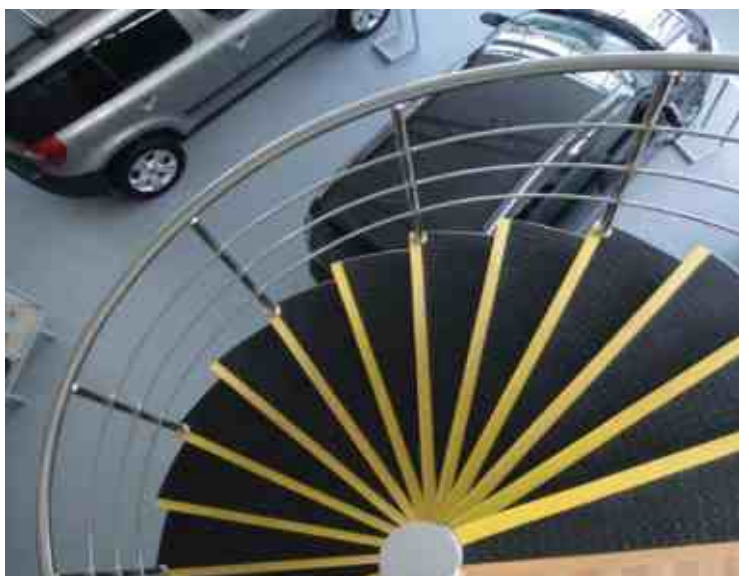
Винтовая лестница на центральном столбе. Ступени клеены противоскользящими полосами и текстурированными накладками из резины.
