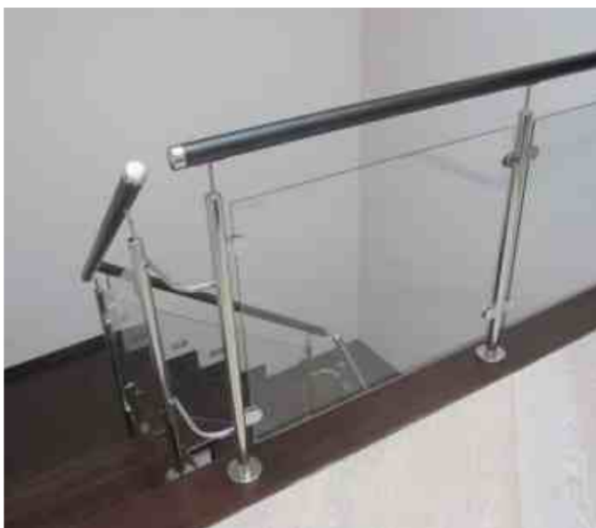
Пластиковый черный поручень не завязан на поворотах. Заполнение 2 ригеля диаметром 16 мм. Большая крышка основания стойки диаметром 100 мм, арт. k201.
