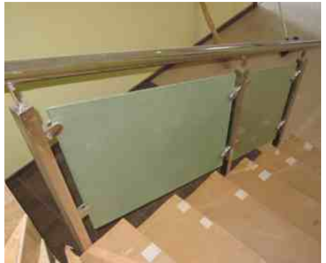
Ограждения лестницы на квадратных стойках 40x40 мм с боковым креплением. Стекло 8 мм с химическим травлением.
