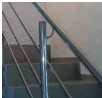
Наконечник на круглую трубу k261. Вынос поручня 65 мм.
