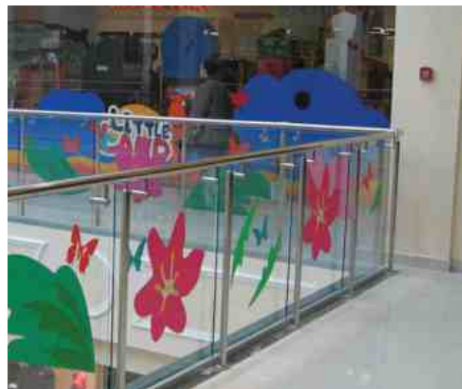
Сплошное стекло ограждения атриума обычно используется для размещения рекламы или как тематическое оформление этажа.
