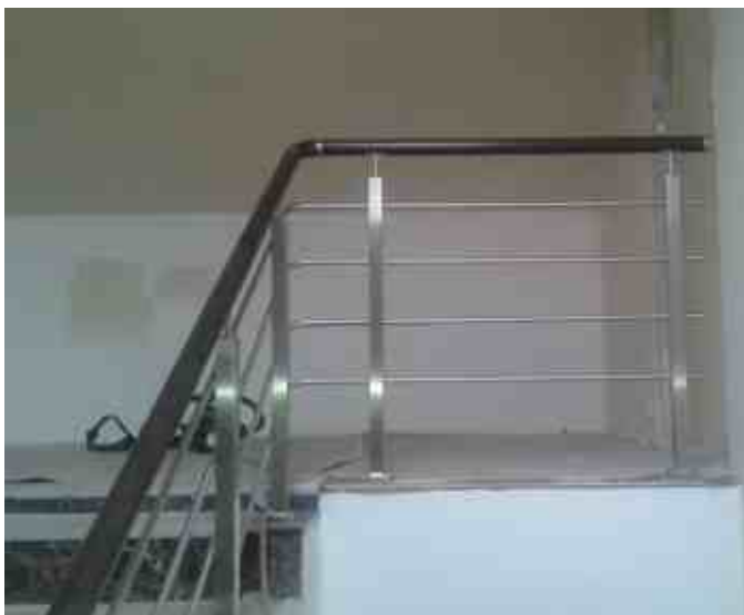
Ограждение из шлифованной нержавеющей стали на квадратных стойках 40x40 мм, с наконечником K239, с тремя ригелями диаметром 16 мм внахлест, со стойками и круглым деревянным поручнем цвета венге, соединенным кольцами.
