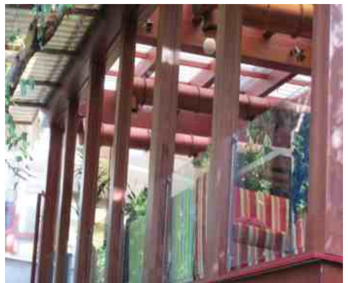
Ограждение балкона с креплением стекла в опорные металлические конструкции козырька, обшитые деревом.
