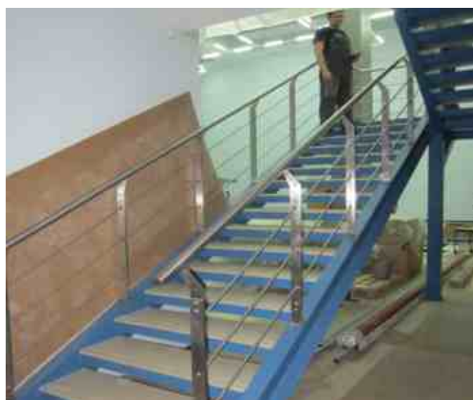
Дорогие, нестандартные, пластинчатые стойки с небольшим выносом поручня внутрь марша для удобства ходьбы. Три ригеля диаметром 16 мм сквозь стойку.
