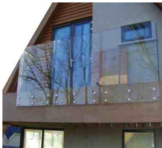
Ограждение балкона с креплением сбоку на точечных держателях. Без поручня, кромки стекла открыты.
