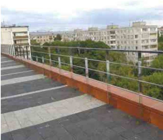
Пластинчатое ограждение обслуживаемой кровли из нержавеющей стали. 3 ригеля 16 мм. Каждая стойка обеспечена отверстиями для крепления люльки промышленных альпинистов в расчете 500 кг нагрузки. Стойки имеют зеркальную поверхность и малозаметны.
