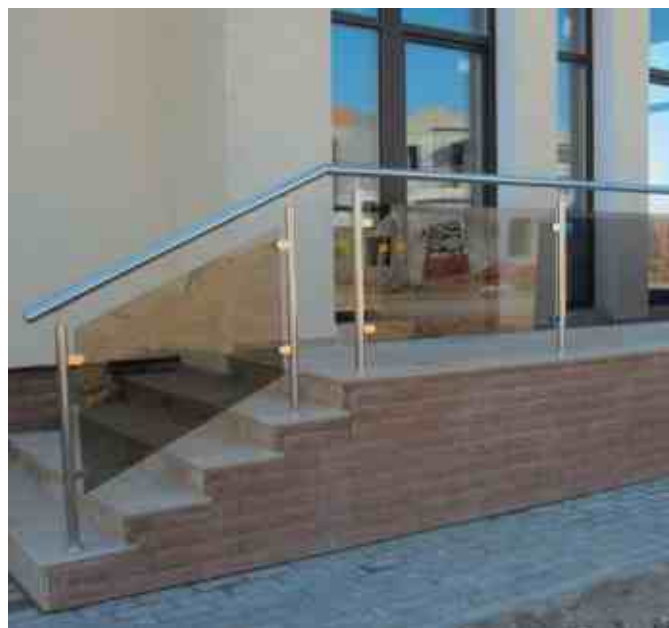
Ограждение входной группы с бронзовым в массе стеклом, сочетающимся по цвету с оконным профилем.
