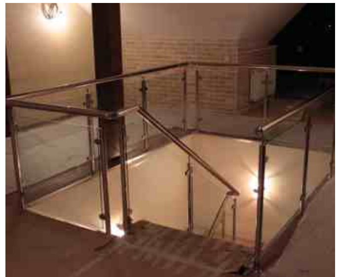
Ограждение второго этажа в частном доме, поручень завязан, пролеты между стойками не заполнены. Стекло сложной формы на выходе на площадку.
