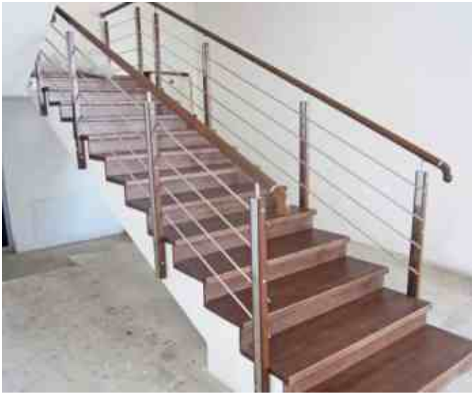
Стойки из шлифованной нержавеющей стали с боковым крепежом, со вставками из дерева, с деревянным поручнем 40 мм и оконечным деревянным отводом в цвет ступеней.
