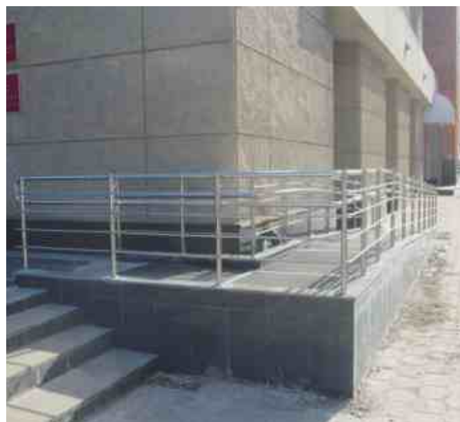
Ограждения «Г-образного» пандуса при входе в ФНС г. Тула. Бюджет позволил сделать дополнительные 4 ограничителя в виде ригелей \Phi 16мм помимо наличия небольшого парапета.
