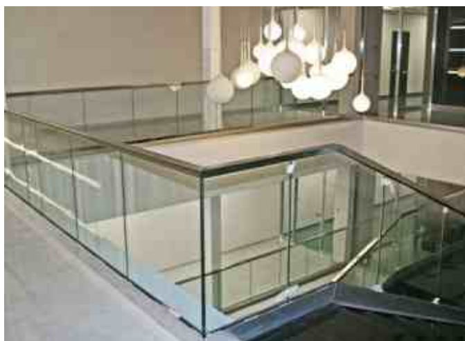
Стеклянное ограждение триплекс 8+8 мм, в алюминиевом профиле к601 и поручне 40 мм x 60 мм с пазом под стекло.
