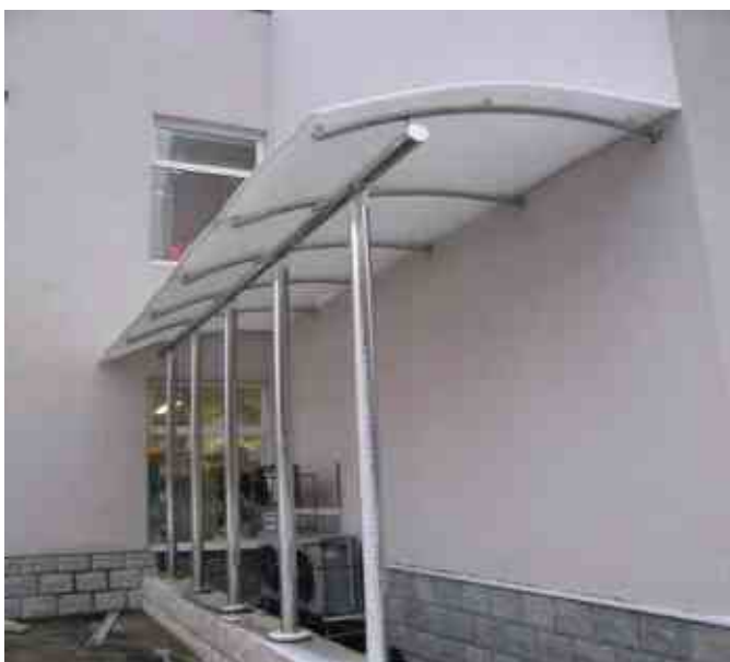
Навес над входом в подвал. Каркас из нержавеющей стали накрыт монолитным поликарбонатом молочного цвета.
