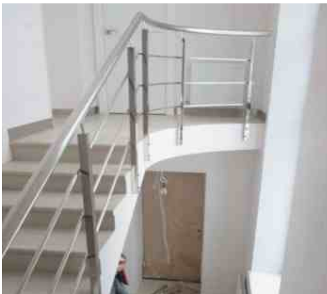
Боковой крепеж квадратных стоек 40 x 40 мм. Поручень круглый 50 мм, на площадке прокатан по радиусу. Три ригеля диаметром 16 мм приварены внахлест к стойке. Наконечник k239. Поручень и ригели завязаны на выходе на балкон.
