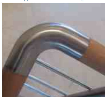
Завязка поручня поворотом из нержавеющей стали.
