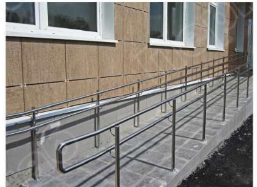
Ограждение пандуса поликлиники со стойками k750 и двойным поручнем \varnothing 38\text{мм} из нержавеющей стали.
