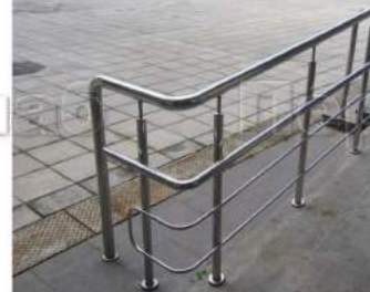
Ограждение входной группы бизнес-центра со стойками k751 и двойным поручнем из нержавеющей стали.
