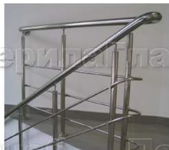
Ограждение лестницы и площадки со стойками k713, тремя ригелями и поручнем Ø50,8мм из нержавеющей стали.
