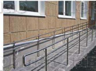
Ограждение пандуса поликарбоната со стойками k750 и двойным поручнем Ø38мм из нержавеющей стали.
